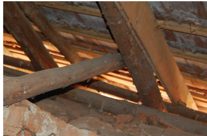
Abb.129 Aufschieblinge
