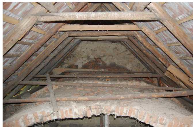
Abb.133 Ziegelgewölbe mit den verstärkenden Ziegelbändern
