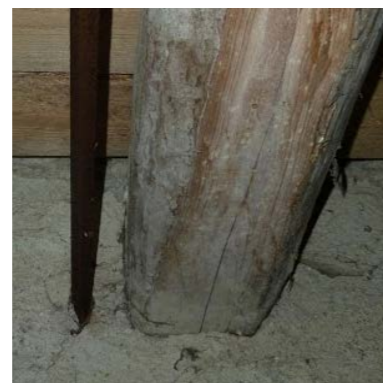
Abb.110 Parallel mit einem Tram verlaufendes Zugband
