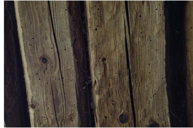
Abb.88 Holzwurm in den Holzüberlagern
