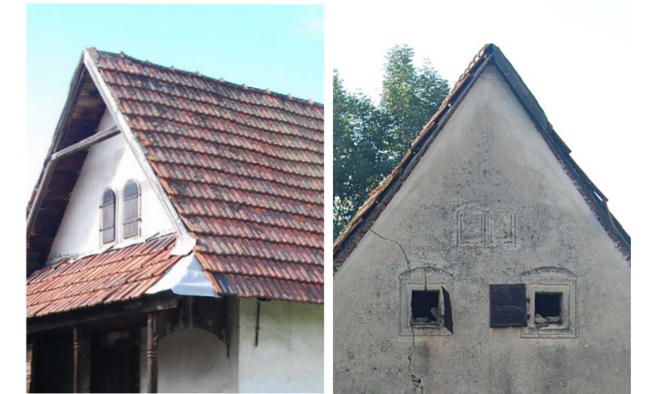
Abb.220 Grundformen oberer Lüftungsöffnungen in Trstené und Dovalovo
