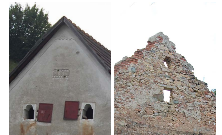
Abb.221 Eine etwas seltener vorkommende Form der oberen Lüftungsöffnungen am Getreidespeicher in Smrečany, linsenförmige Öffnung am Getreidespeicher in Trstené
