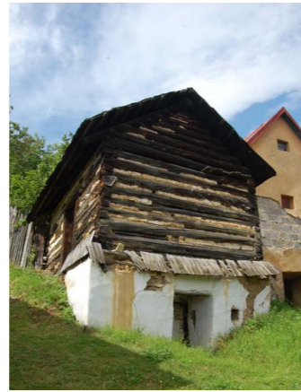
Abb.206 Unterkellertes Getreidespeicher in Vikartovce
