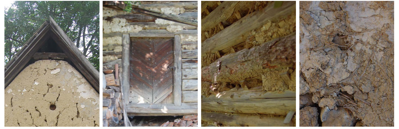
Abb.189 Typische Merkmale eines hölzernen Getreidespeichers: obere Lüftungöffnung und abnehmbares Dach, gezimmerte Eingangstür, Holzkeile zur Anbringung vom Lehmputz, Beimischung vom Stroh ins Lehm
