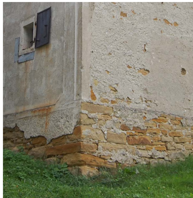
Abb.194 Sandstein am Getreidespeicher in Smrečany
