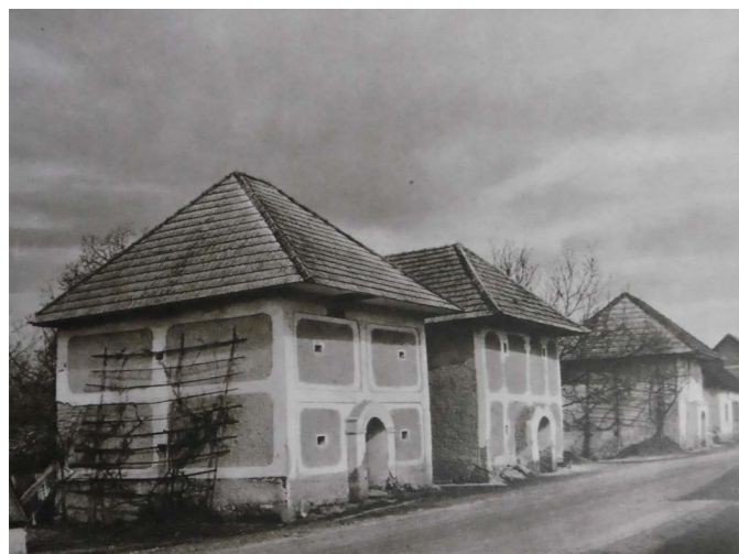
Abb.180 Doppelgeschossige Getreidespeicher aus Lehm in Nedožery
