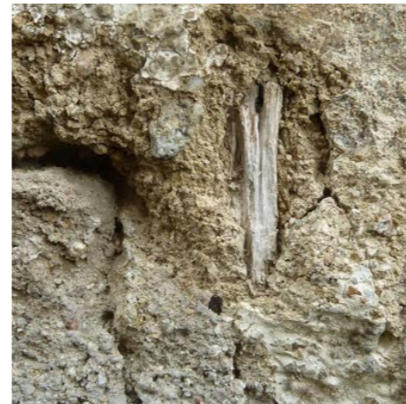
Abb.56 Füllung der Löcher im Steingefüge durch kleine Holzteile
