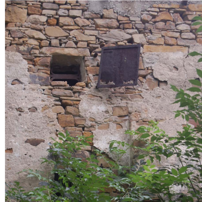
Abb.5 Lüftungsöffnung am Getreidespeicher in Pavlova Ves
