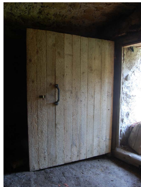
Abb.87 Innerer Teil T2 der neuen Kellertür
