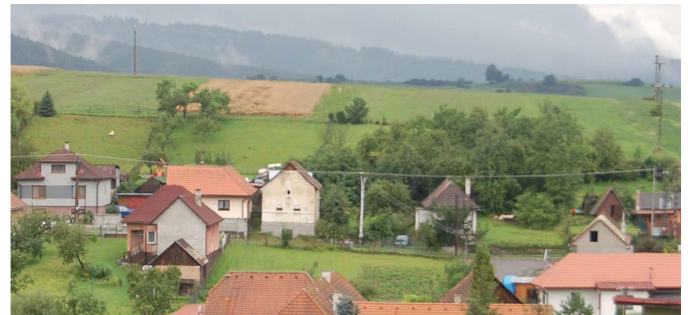
Abb.54 Blick auf den Getreidespeicher Turčičik samt des gegenüber liegenden Hauses seiner Instandhalter
