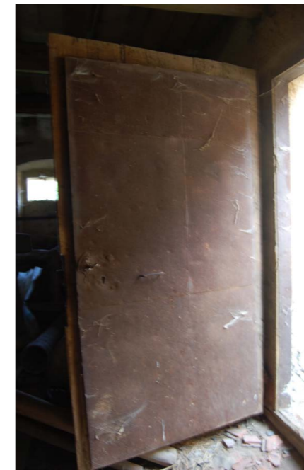
Abb.65 Verblechung der Tür
