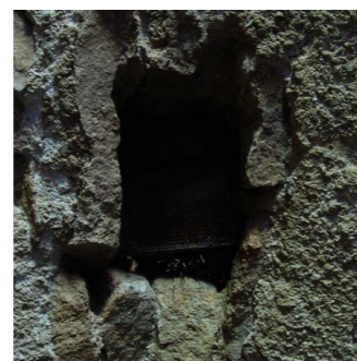
Abb.79 Manipulationsloch im Tonnengewölbe
