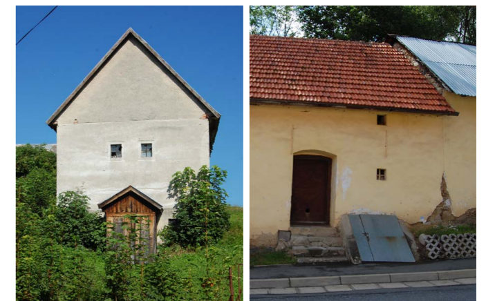
Abb.214 Kellereingänge in Lazisko und Kravany
