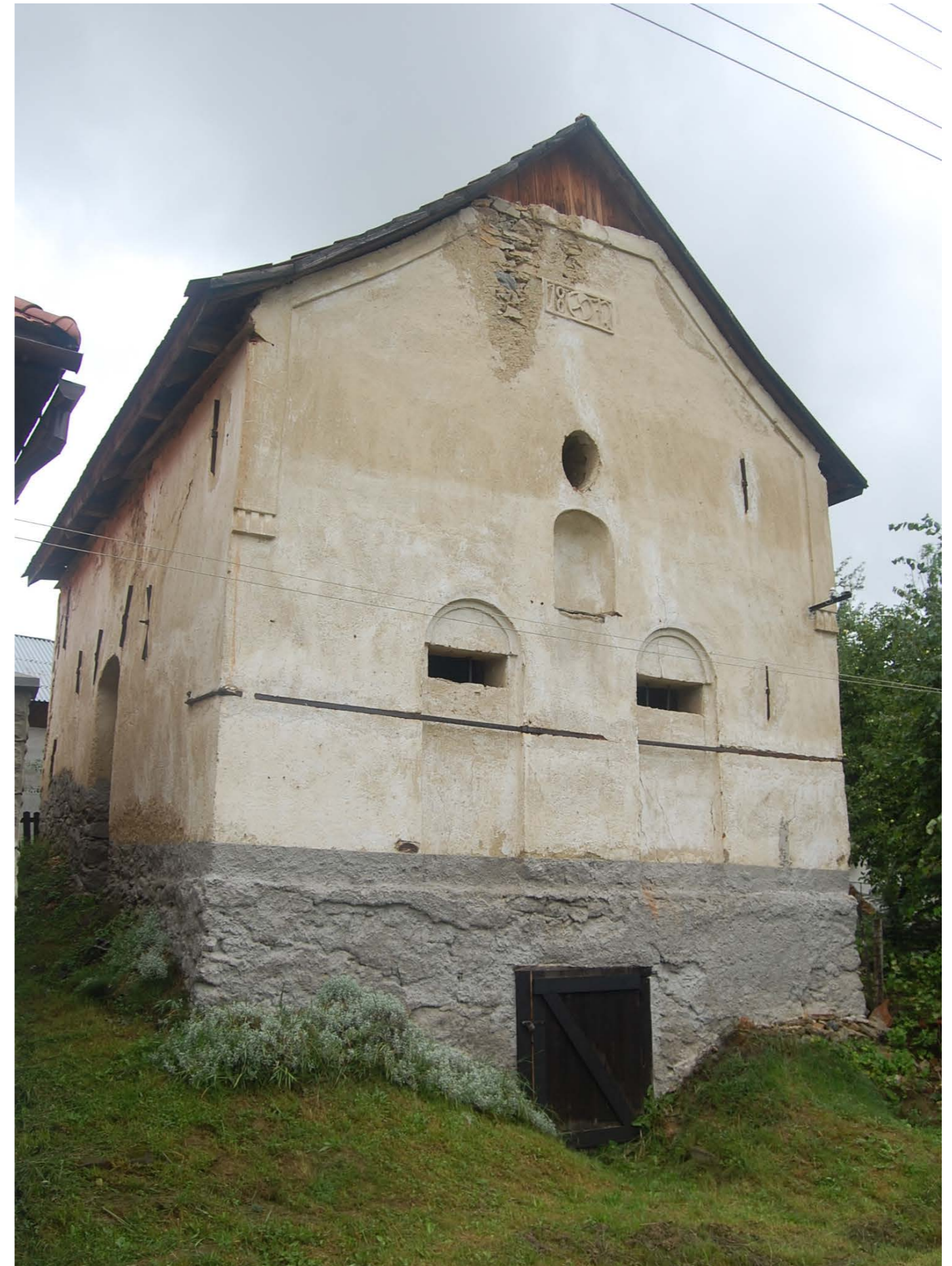
Abb.59 Hauptfassade - Zustand von 2016, Zustand von 2017 siehe Kapitel 1, Abb. 3
