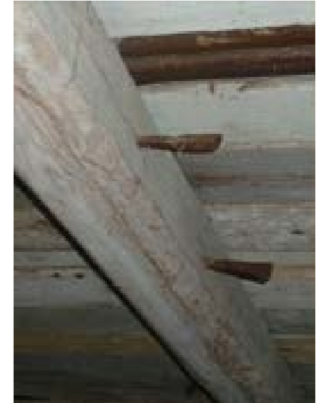
Abb.107 Eiserne Keile zur Aufhängung von geschlachteten Tieren
