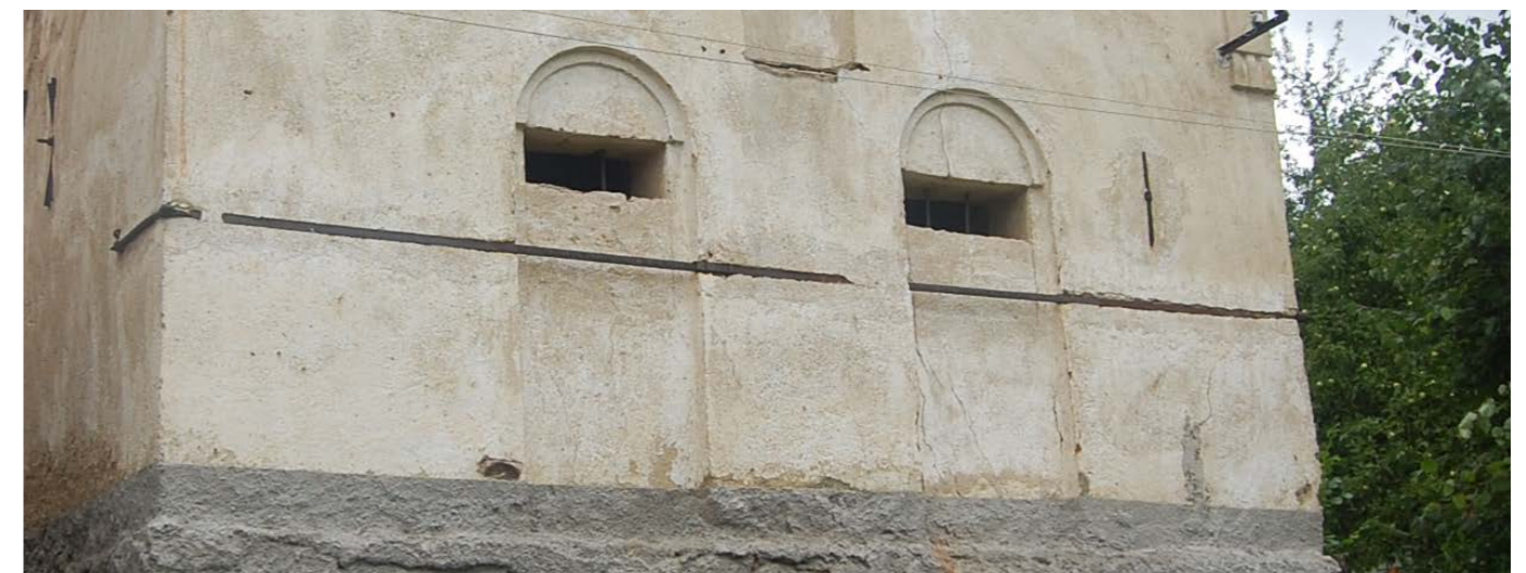
Abb.147 Sonderform eines Zugbands, welches die Hauptfassade stützt
