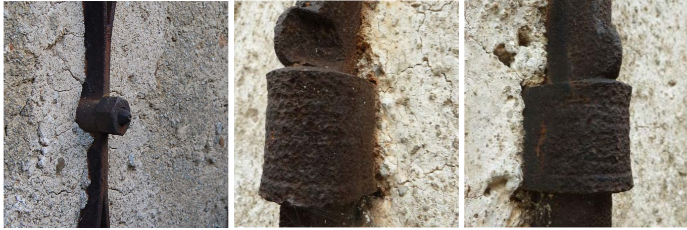
Abb.136 Schraube am Ende eines Ankers
