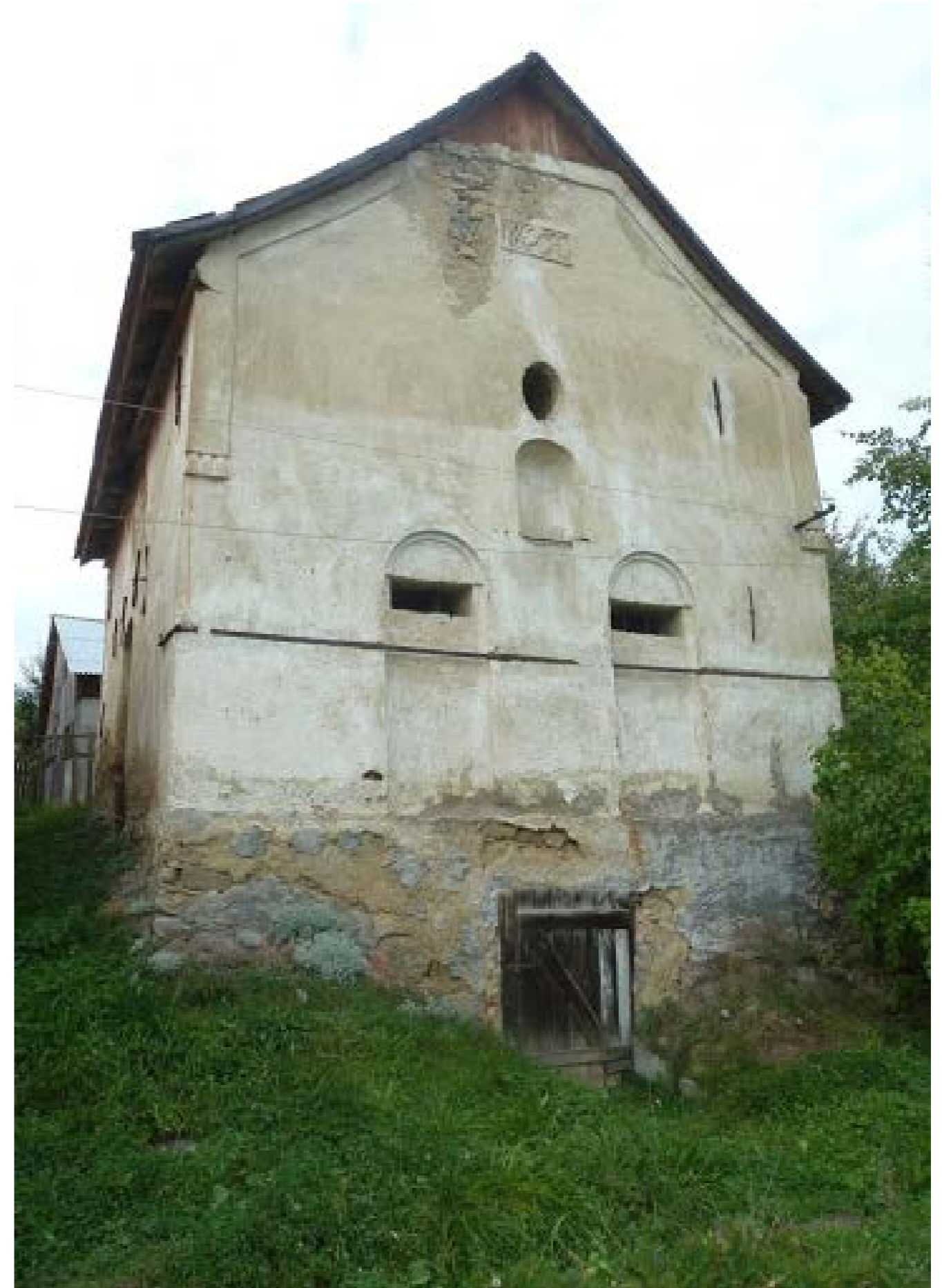
Abb.58 Hauptfassade - Zustand von 2012, Zustand von 2017 siehe Kapitel 1, Abb. 3
