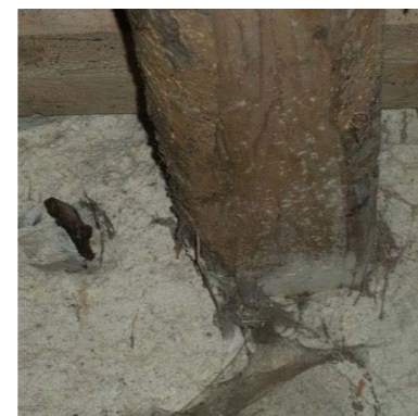
Abb.111 Abgebrochenes Zugband
