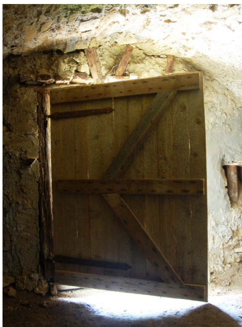
Abb.86 Innerer Teil T2 der neuen Kellertür
