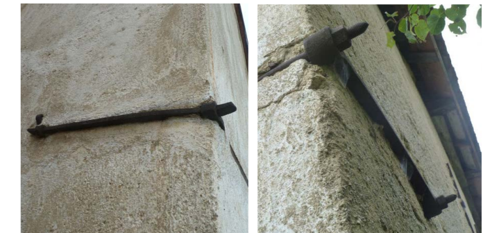
Abb.145 Linke Verankerung des Zugbands der Hauptfassade
