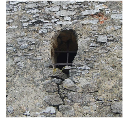
Abb.71 Detail der Hinterfassade
