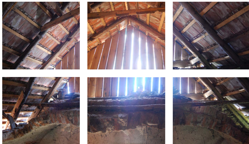
Abb.130 Blick ins Dachraum in Richtung Wand D
