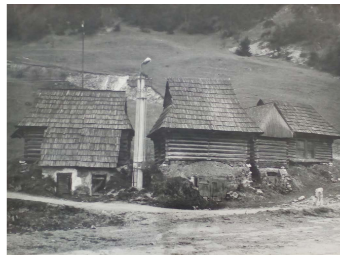
Abb.181 Hölzerne Getreidespeicher in Hubová
