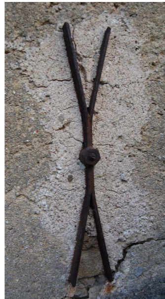
Abb.69 Detail der Seitenfassade
