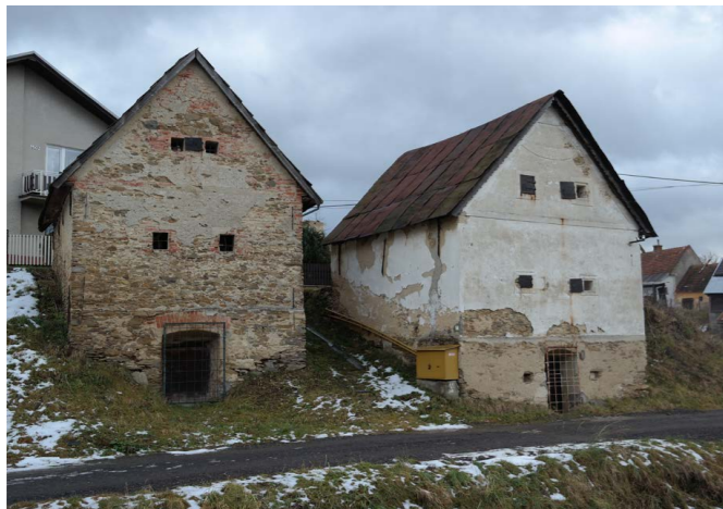
Abb.139 Getreidespeicher mit Zugankern in Východná
