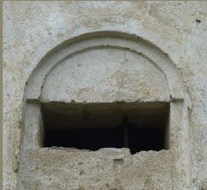
Abb.1 Lüftungsöffnung des Getreidespeichers Turčičik
