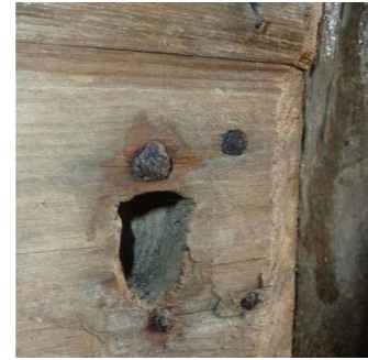
Abb.83 Detail der alten Kellertür
