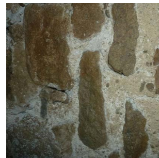
Abb.78 Sichtbare Steine im Scheitel des Gewölbes
