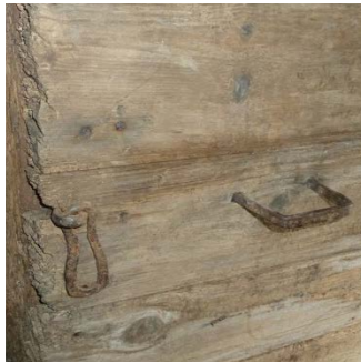
Abb.81 Detail der alten Kellertür
