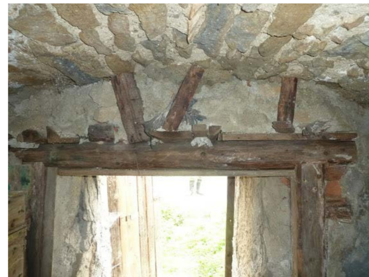
Abb.89 Nachträgliche statische Maßnahme über der hölzernen Türzarge
