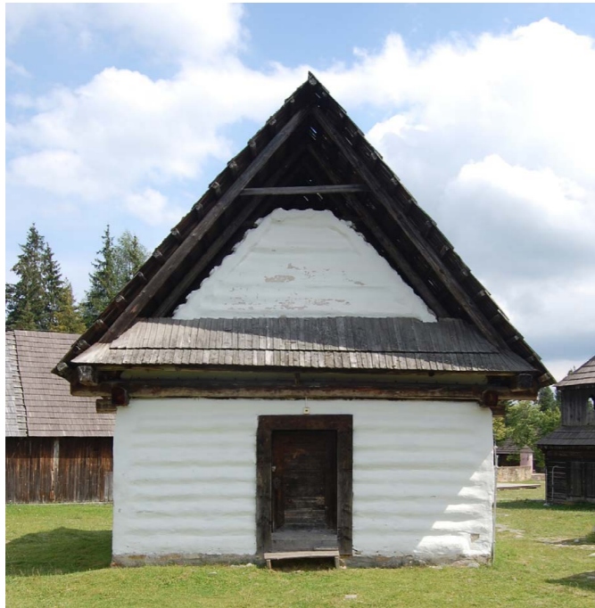
Abb.184 Typisches abnehmbares Dach an einem kleineren hölzernen Getreidespeicher im Freilichtmuseum in Pribylina
