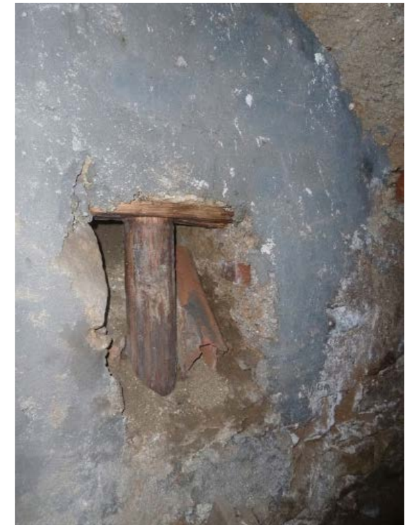
Abb.92 Holzene Stütze in der zugemauerten Öffnung
