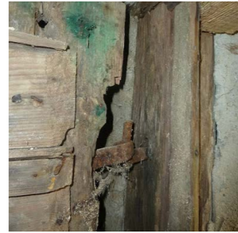
Abb.82 Detail der alten Kellertür
