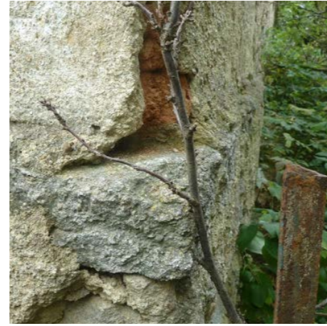
Abb.55 Übergang des Sockels aus Steingefüge ins Ziegelmauerwerk
