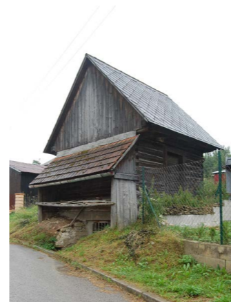
Abb.211 Zubau am Getreidespeicher in Osádka
