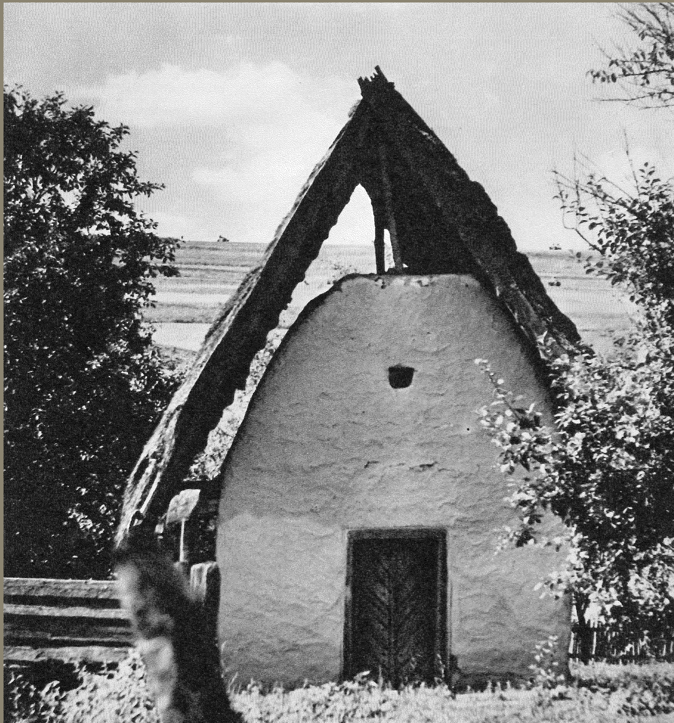
Abb.4 Abnehmbares Dach an einem Getreidespeicher
