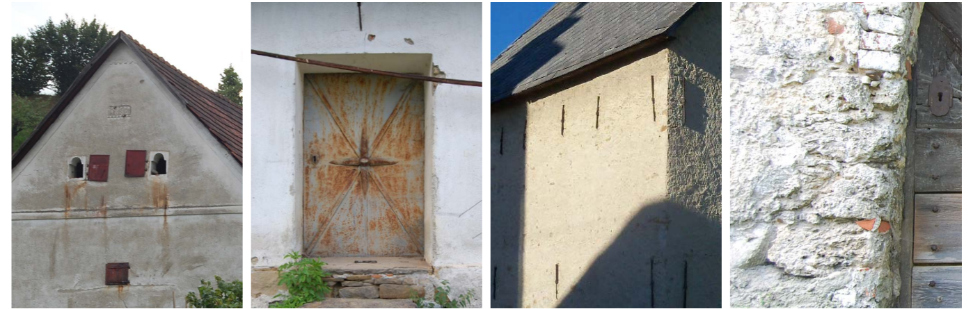
Abb.190 Typische Merkmale eines gemauerten Getreidespeichers: obere und untere Lüftungöffnungen mit metallenen Läden, metallene Eingangstür, sichtbare metallene Zuganker und gemischtes Mauerwerk
