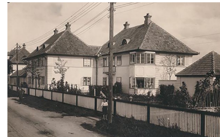
ABB. 53 Wohnhäuser der EBG.
