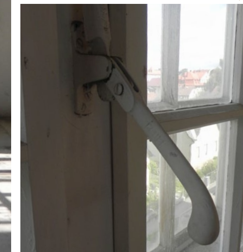
ABB. 11 Fenster- Detail Kippfunktion.
