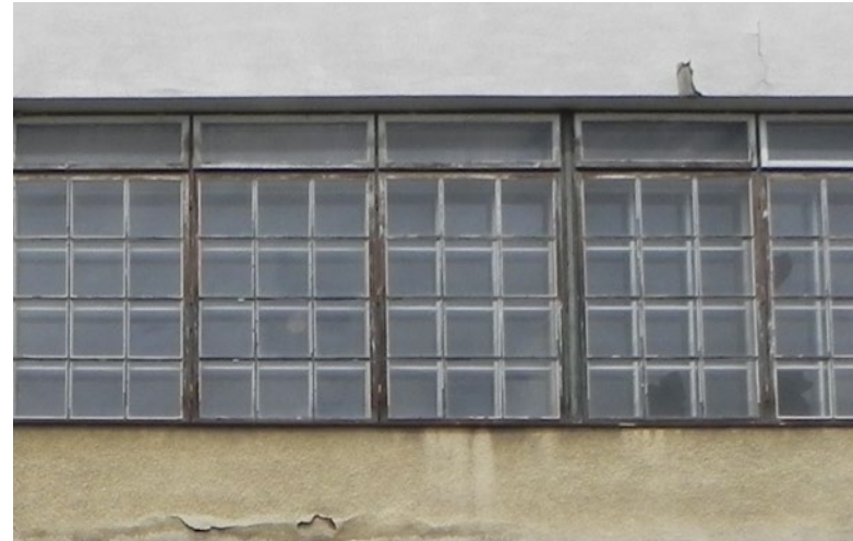
ABB. 115 Kastenfenster an der Südfassade.
