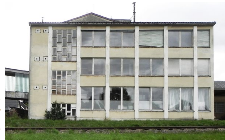
ABB. 136 Nordfassade des Bürohauses.
