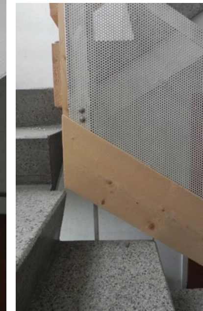
ABB. 88 Raum 3, Absturz- sicherung, Treppe.
