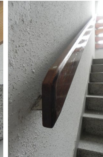
ABB. 86 Raum 3, Detail - Konstruktion Treppe.
