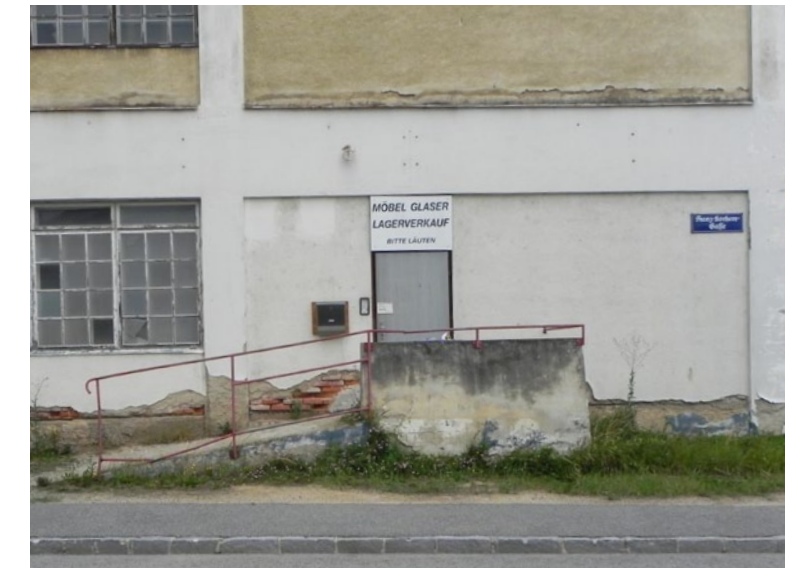
ABB. 113 Eingang an der Nordfassade.
