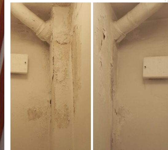
ABB. 122, ABB. 123 Raum 11, Wasserschäden in den beiden Kabinen.
