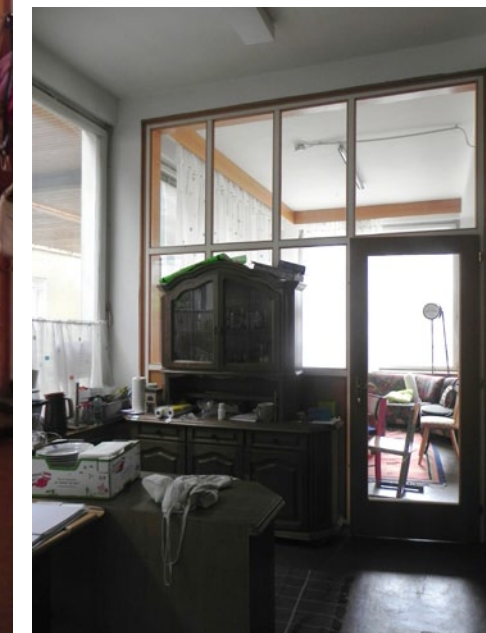
ABB. 111 Raum 8, Ecke Wand 2 und 3.
