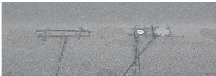
Abbildung 66: Bodensensoren eingebaut
