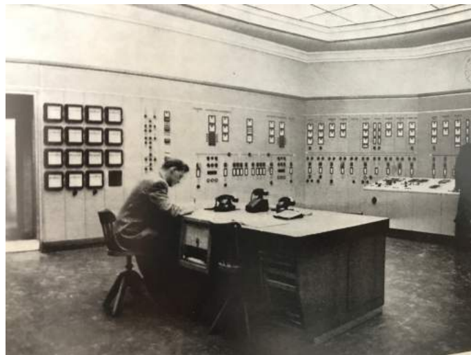
Abbildung 4 Warte der Talsperre Limberg
