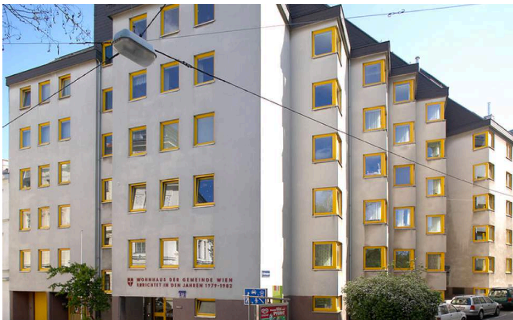
Abbildung 27 Wohnhausanlage in der Leitermayergasse
