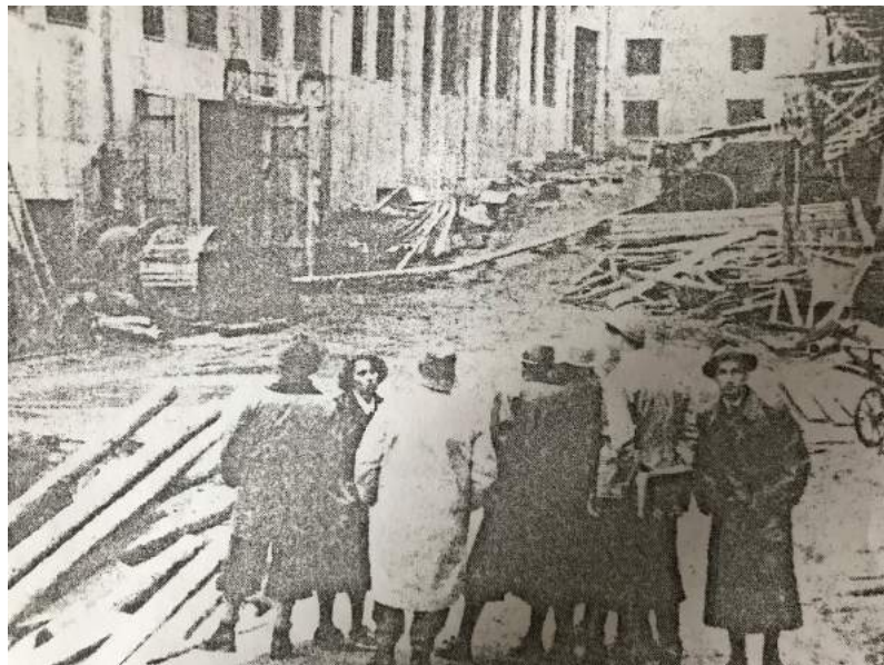
Abbildung 5 Architektin Lassmann auf der Baustelle Kaprun
