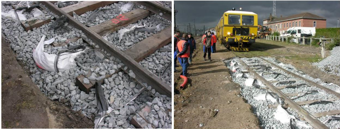
Abbildung 2.21: Positionierung der mit sauberem Neuschotter befüllten „Big-Bags“ unter dem Gleisrost [23]
