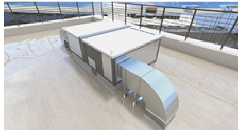
Abb.4.21:Dachmontage eines Kombigerätes
