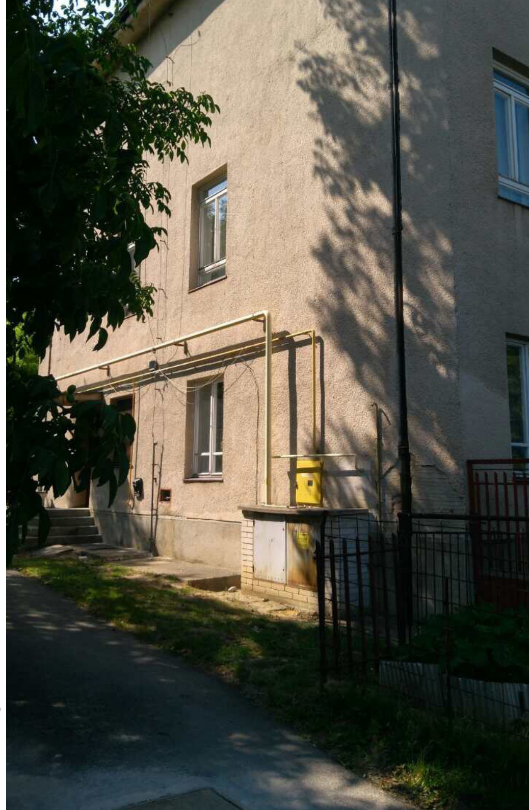
Abb.2.36: das bestehende Kindergartengebäude
