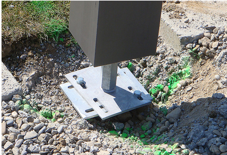
Abb.2.20: Schraubfundament
