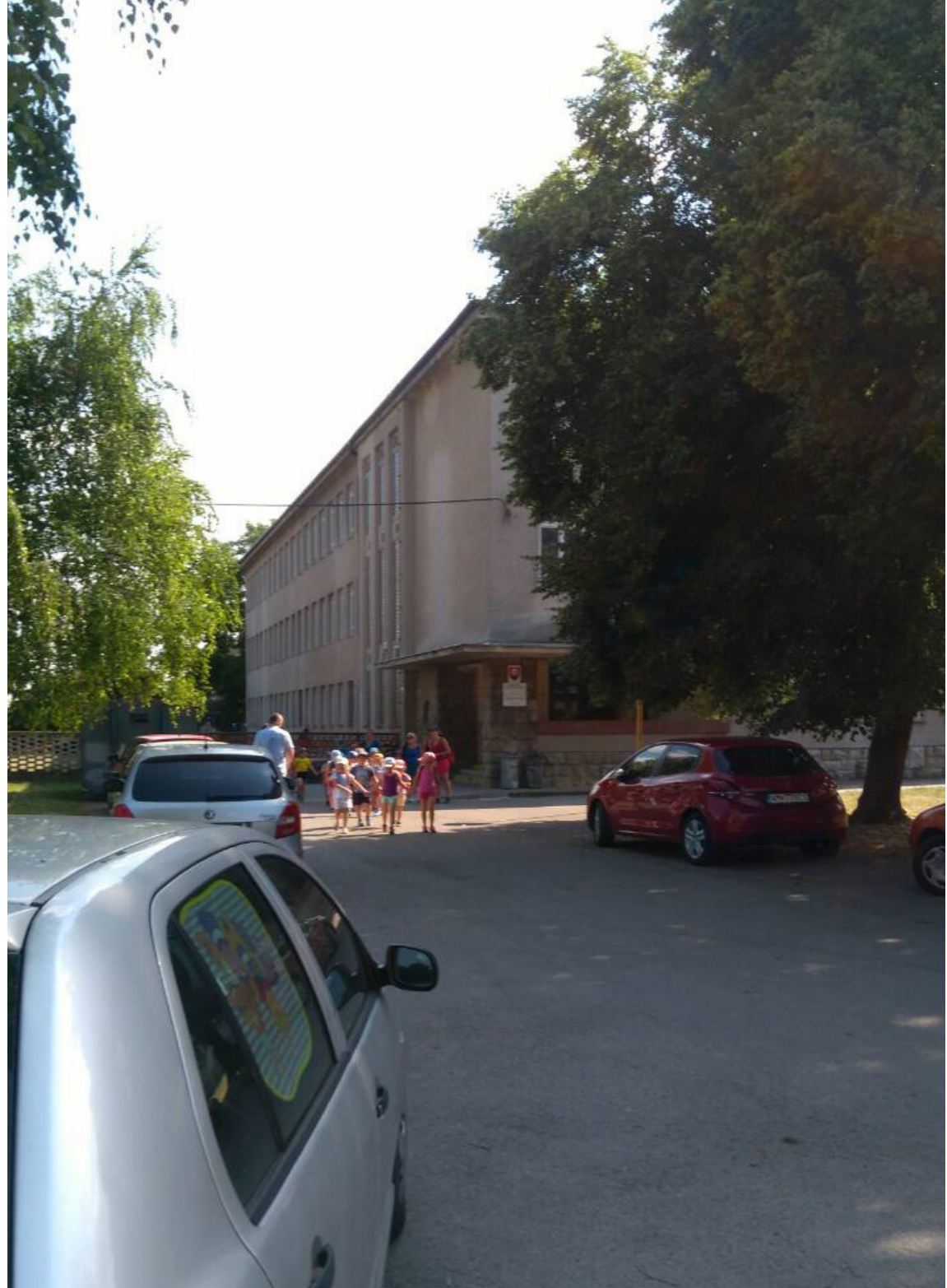
Abb.2.38:das bestehende Kindergartengebäude
