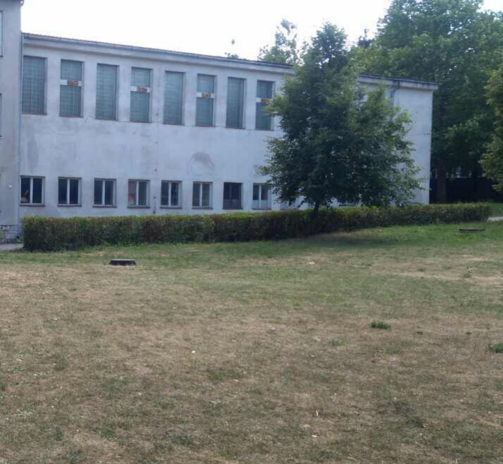
Abb.2.34:das bestehende Kindergartengebäude
