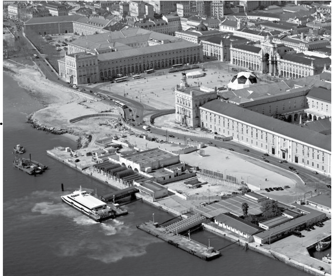
Abb. 170: Umbau und Zubau
