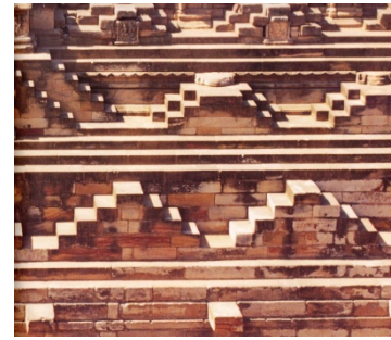
Abb. 97: Treppenförmige, dreieckige Elemente im kund
