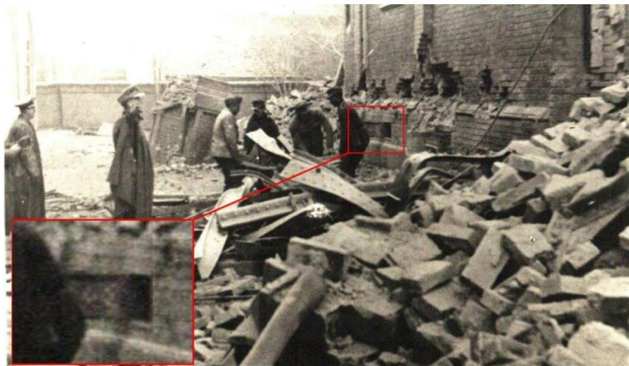
Abbildung 47: Foto nach dem Brand mit Detailblick auf Kellerfenster
