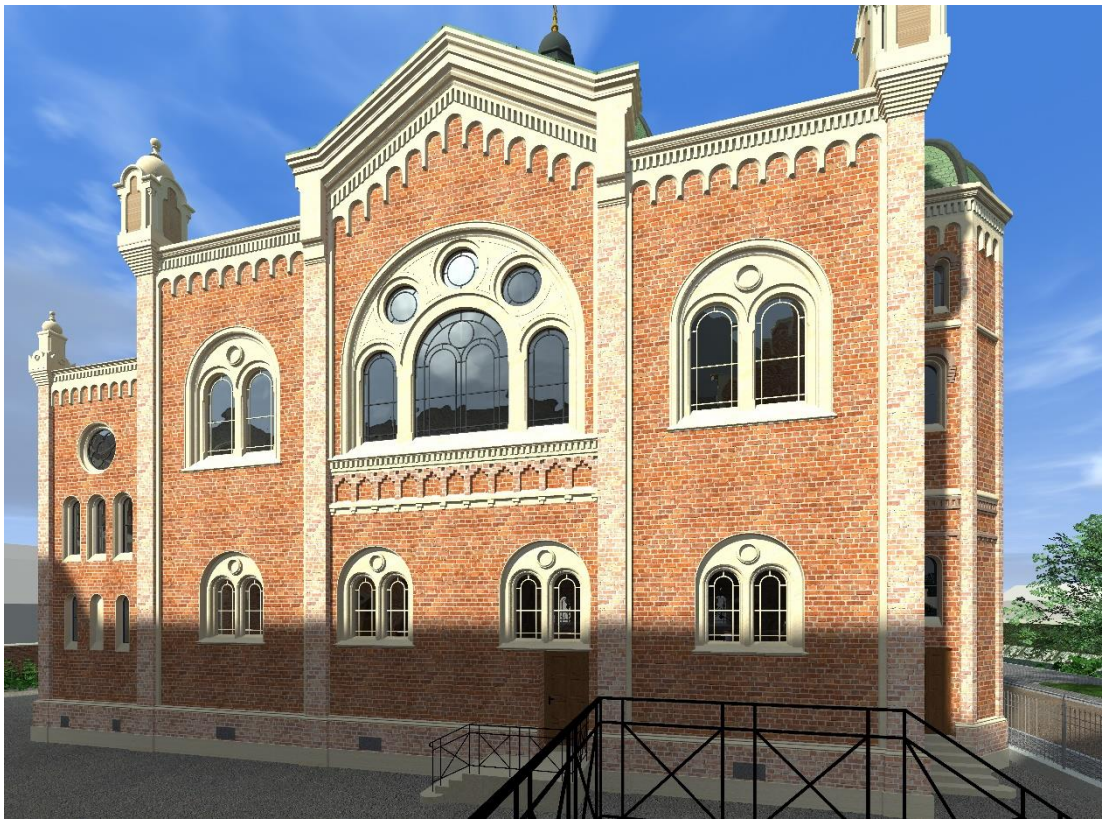
Abbildung 100: Südfassade der Synagoge
