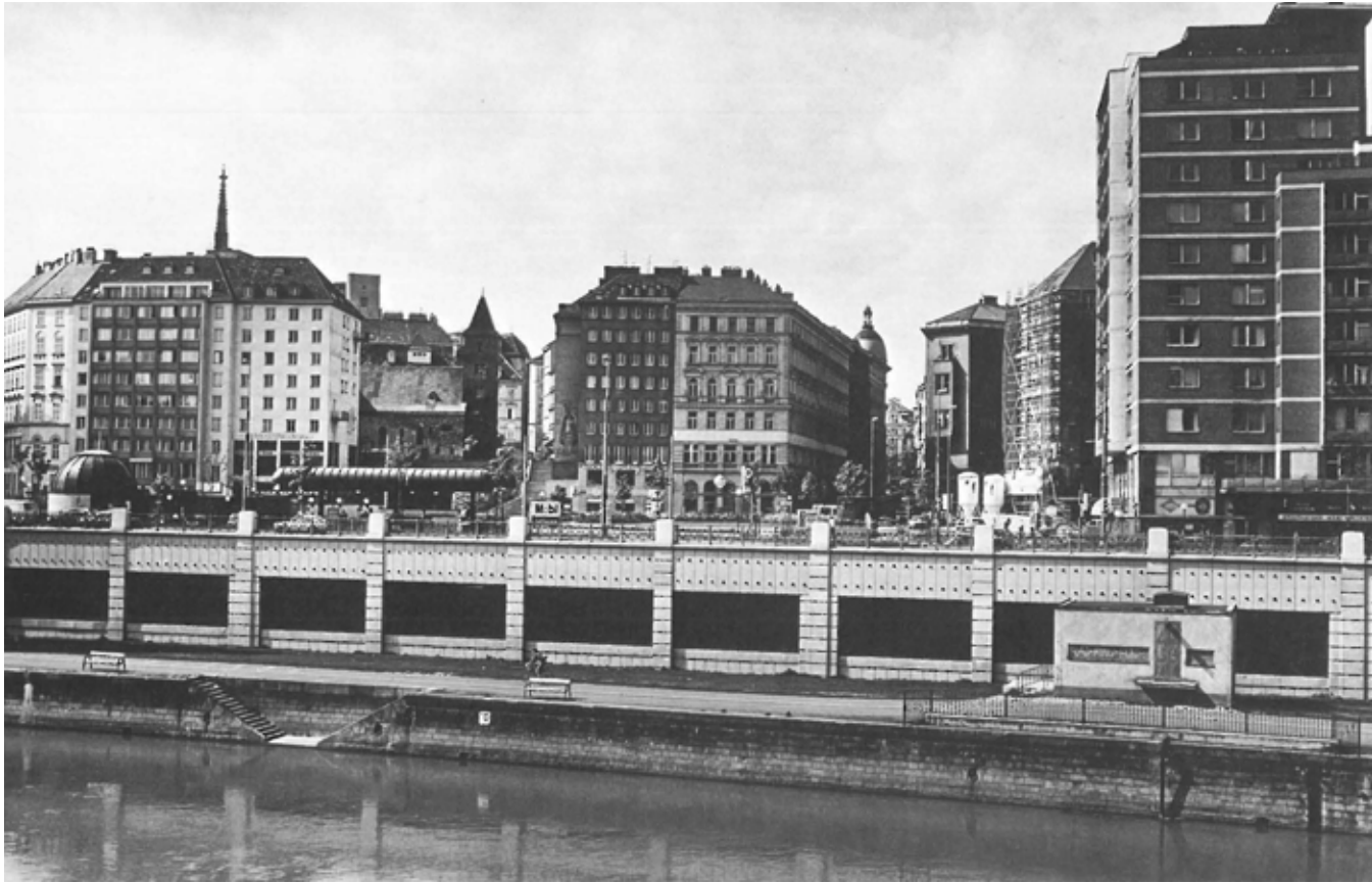
Abb. 58: Der Donaukanal im Bereich des Morzinplatzes mit der neuen U-Bahn-Galerie, 1983
