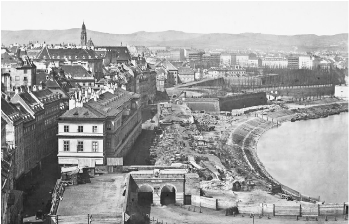
Abb. 51: Die Befestigung auf der Donaukanalseite, vor 1857
