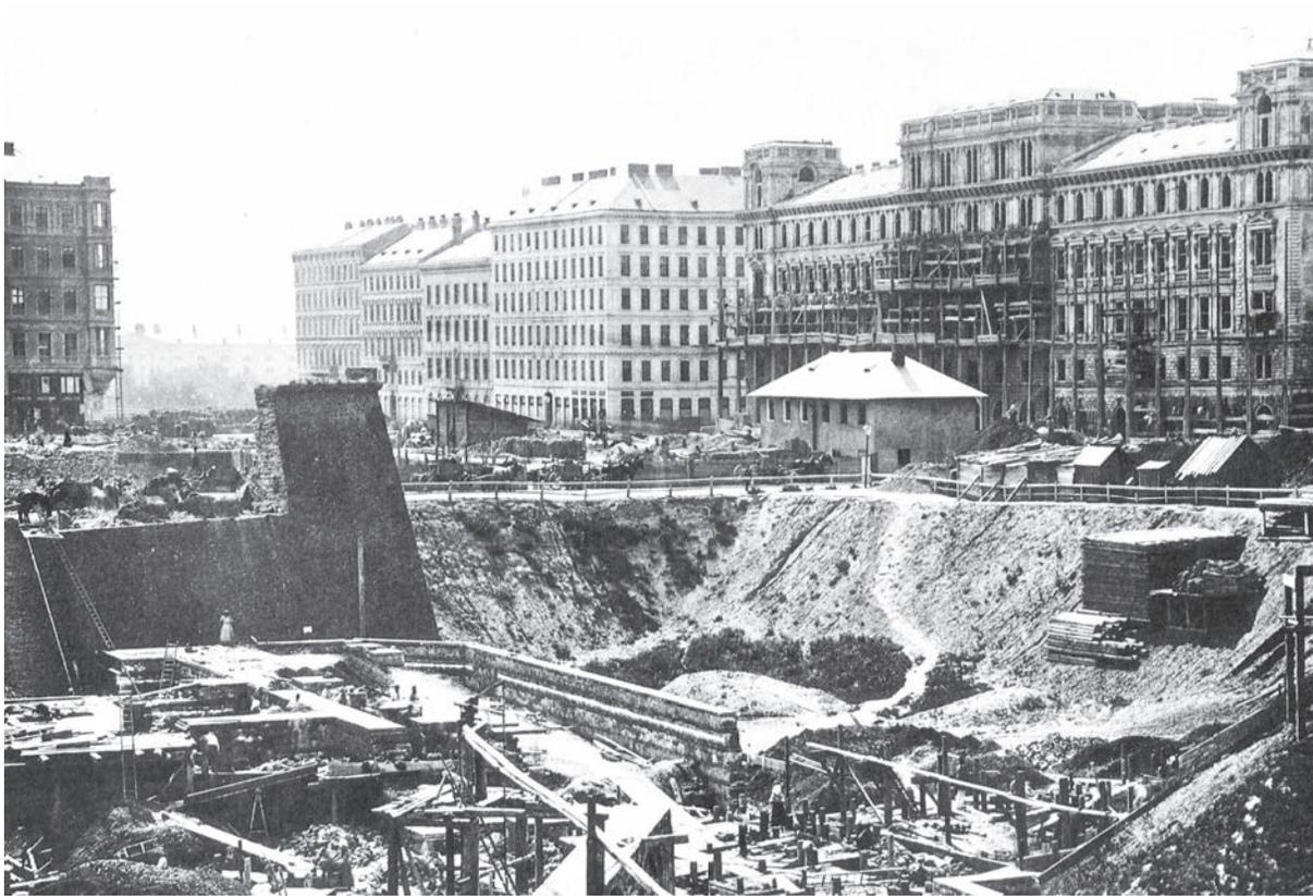
Abb. II.4. Abbruch der Kärntner Torbastei und Aushub für die Fundamente der Staatsoper, 1863
