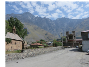
Abb. 4.46 Talstation in Stepanzminda
