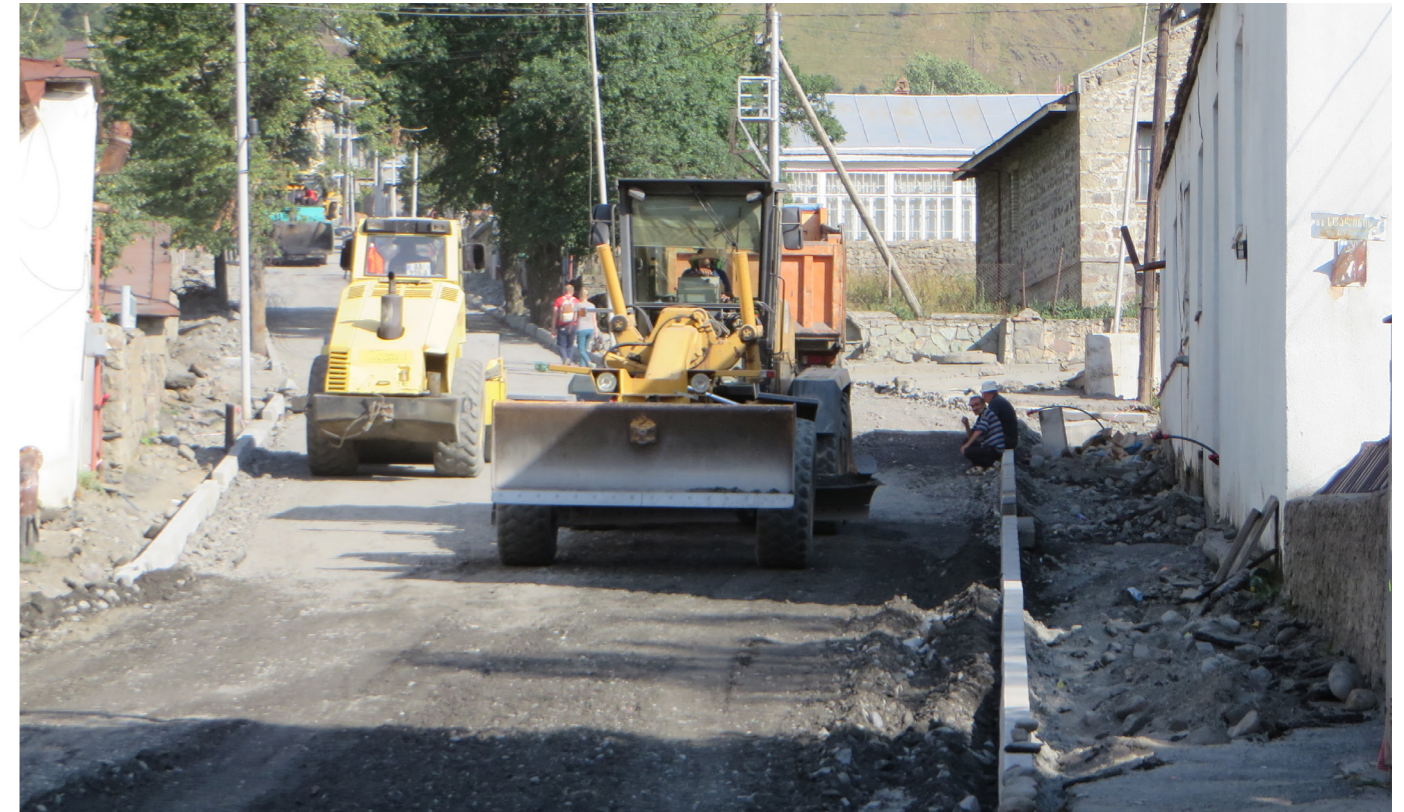
Abb. 4.52: Straßenbauarbeiten in Stepanzminda
