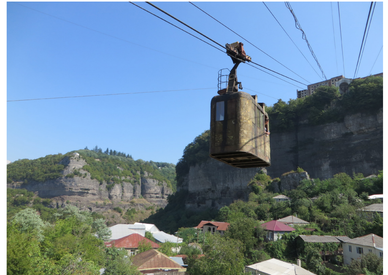
Abb. 2.1: Foto Seilbahnanlage in Tschiatura
