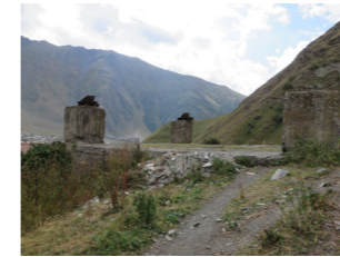
Abb. 4.43 Fundament der Stütze
