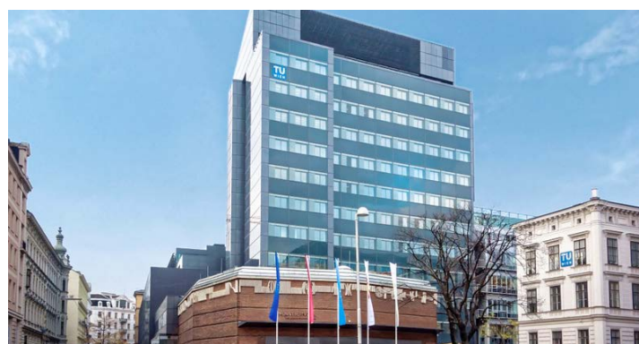
Abb. 40: Gebäude der TU-Wien am Getreidemarkt
