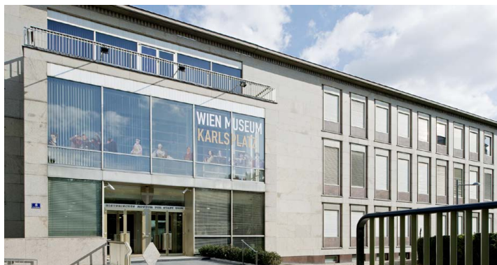
Abb. 9: Wien Museum am Karlsplatz; Haupteingang
