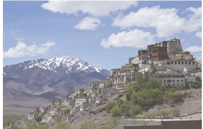
Abb. 120. Kloster Thikse , Lehmziegelbau , Ladakh Region, Himalaja
