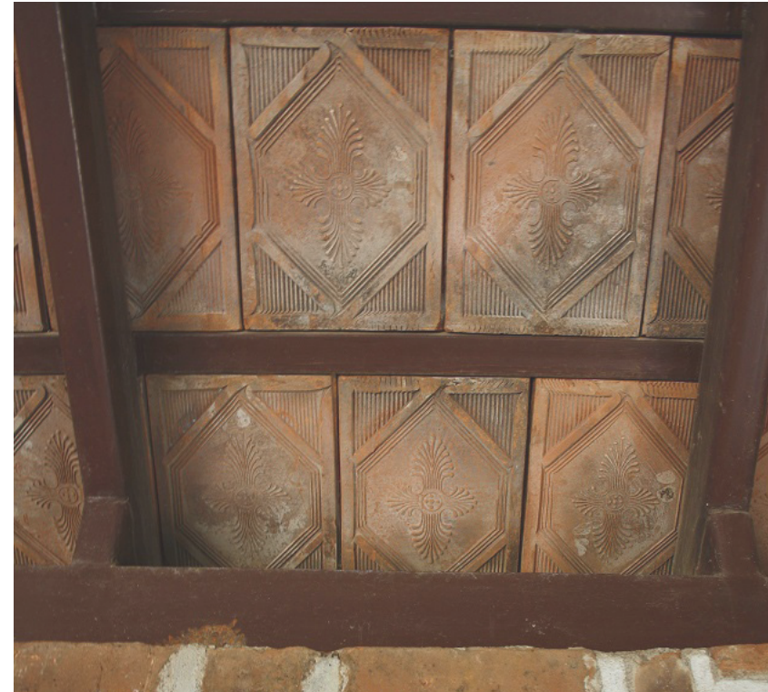
Abb. 178. Foto Untersicht einer traditionellen Ziegeldeckung in Tamil Nadu, Dakshina Chitra
