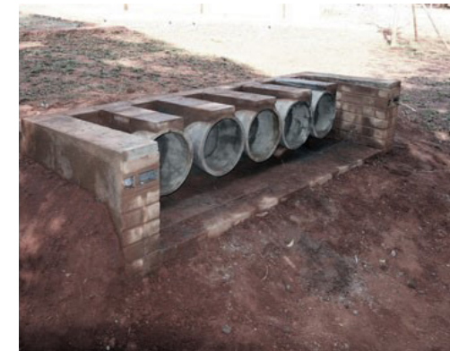
Abb. 164. Earth Tube - Kühlsystem in Verbindung mit Regenwassertank Auroville
