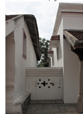
Abb. 63. Baulücke mit Luftschlitzen in Mauer, Agraharam
