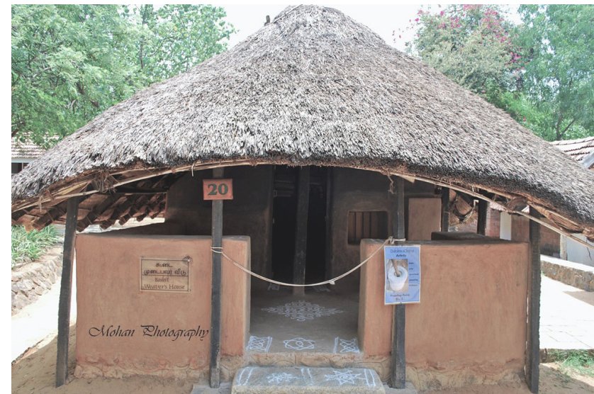
Abb. 59. Lehmbau mit Bambus- Strohdach, Chengelpet, Tamil Nadu, Dakshina Chitra
