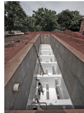
Abb. 164. Earth Tube - Kühlsystem in Verbindung mit Regenwassertank Auroville
