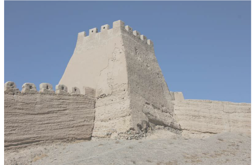
Abb. 116. Teil der Chinesischen Mauer, Lehm- und Ziegelbau
