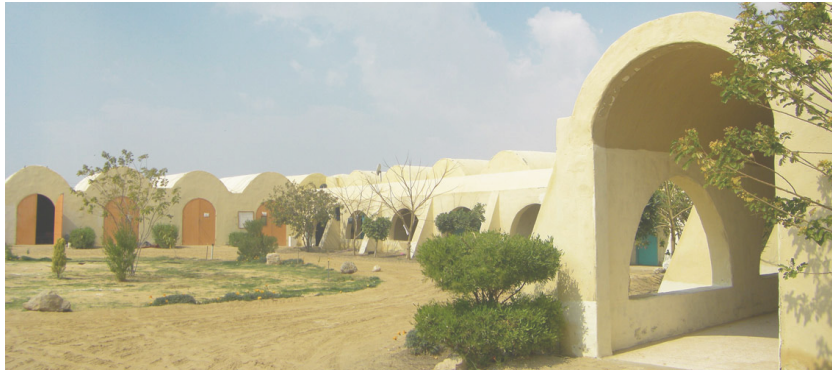
Abb. 79. Hauptgebäude Sekem Farm
