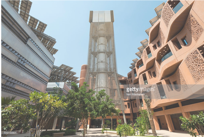
Abb. 86. Ansicht Windtower Masdar City
