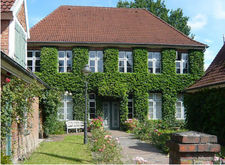
Abbildung 129: Efeu auf Fassade
