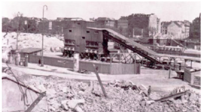
Abbildung 44: Vibro-Anlage in Wien
