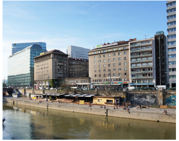
Abbildung 27: Ansicht von der Schwedenbrücke
