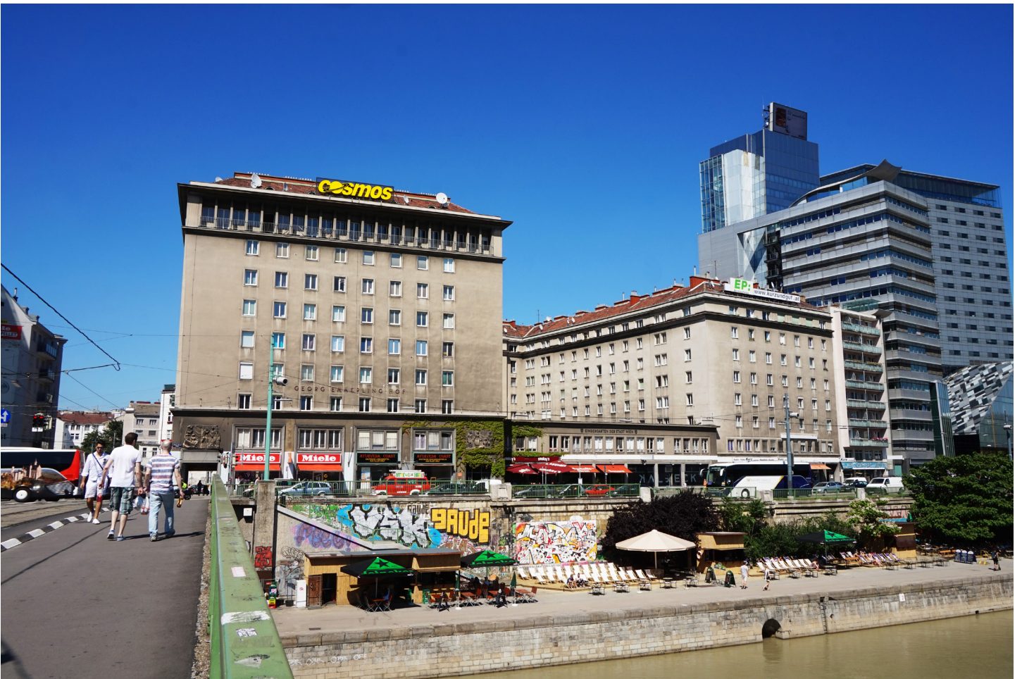
Abbildung 28: Ansicht von der Marienbrücke
