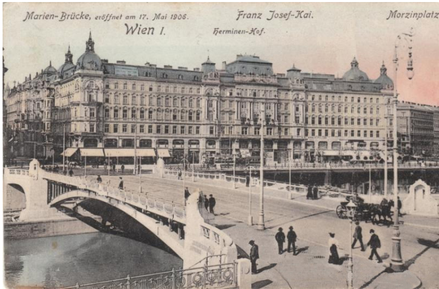
Abbildung 9: Blick über die Marienbrücke Richtung Franz-Josefs-Kai und Herminenhof 1906
