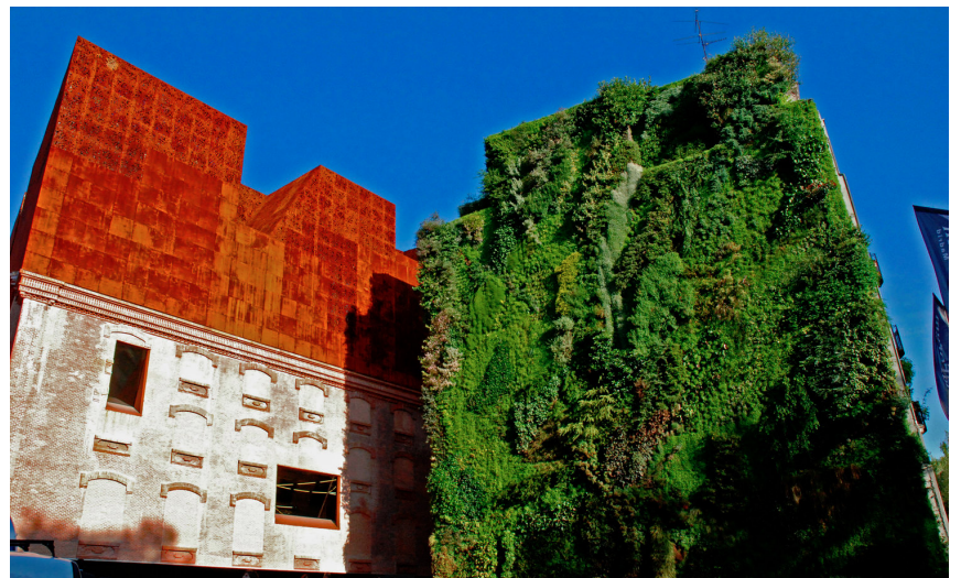
Abbildung 91: Beispiel vollflächiger Vegetationsträger, Gesamtsystem
