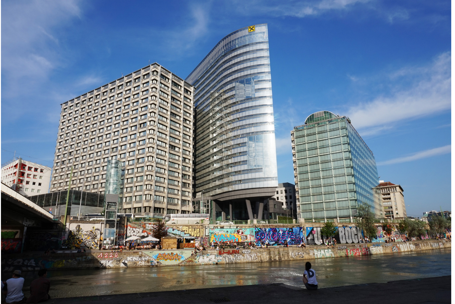
Abbildung 16: Raiffeisen-Klimaschutz-Haus zwischen den Gebäuden von Georg Lippert
