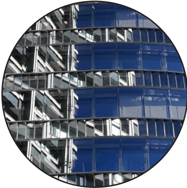
Abbildung 96: Fassade Raiffeisen Hochhaus
