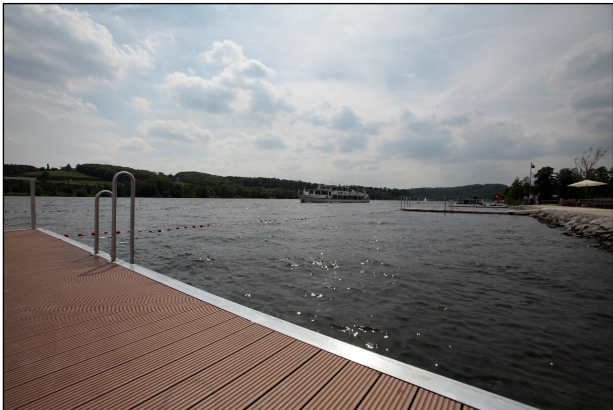
Abbildung 3: Steganlage an der Flussbadestelle Seaside Beach am Baldeneysee in Essen
