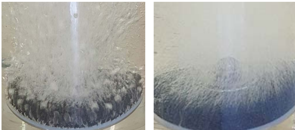
Abbildung 8: Blasenbild Ozon-Diffusor in der KA Neugut. Links: Diffusor vor der Reinigung mit deutlich grösseren Blasen; Rechts: Diffusor nach der Reinigung mit vielen kleinen Blasen. Juni 2018.
