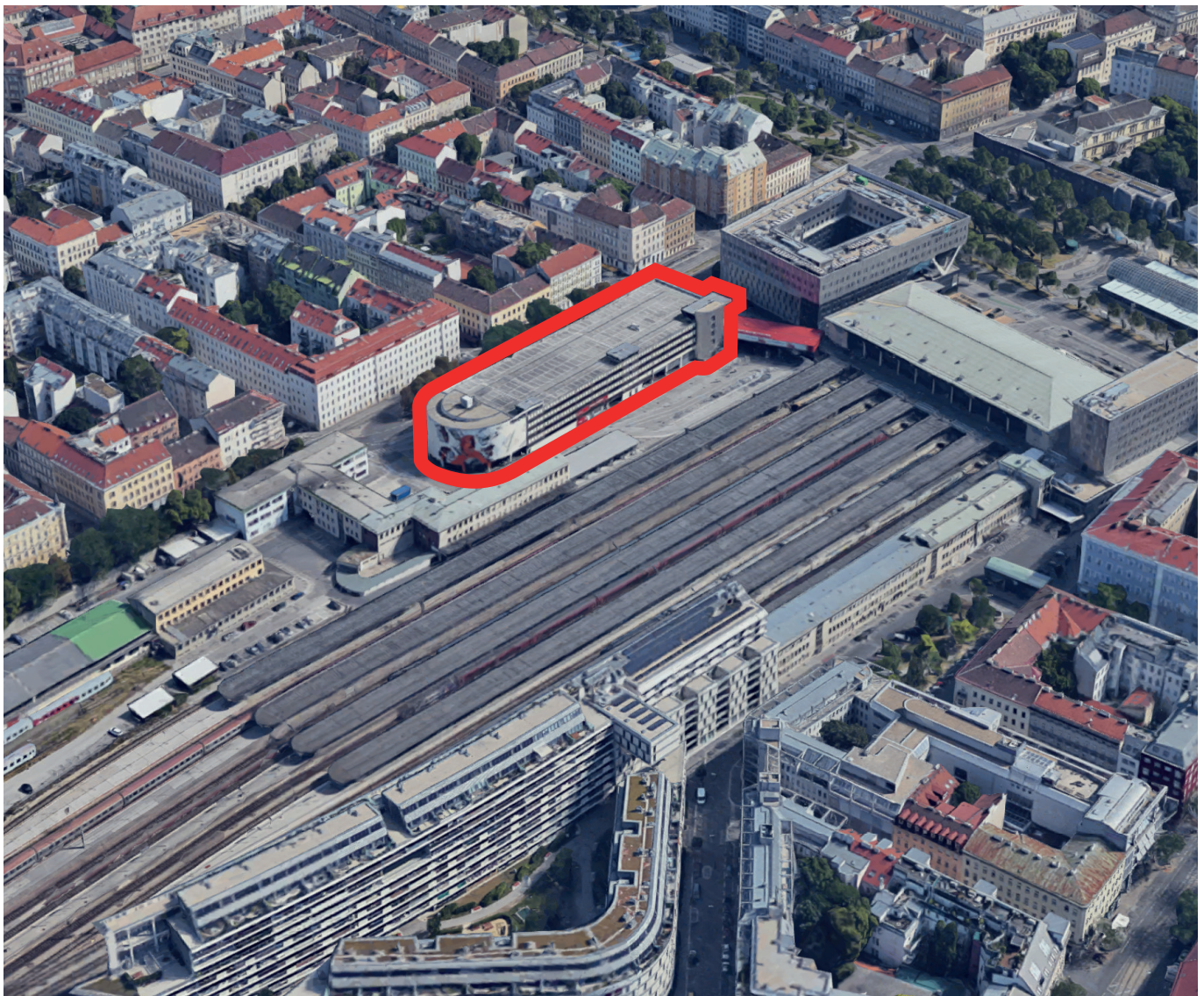
94 LUFTBILD PARKGARAGE WESTBAHNHOF
