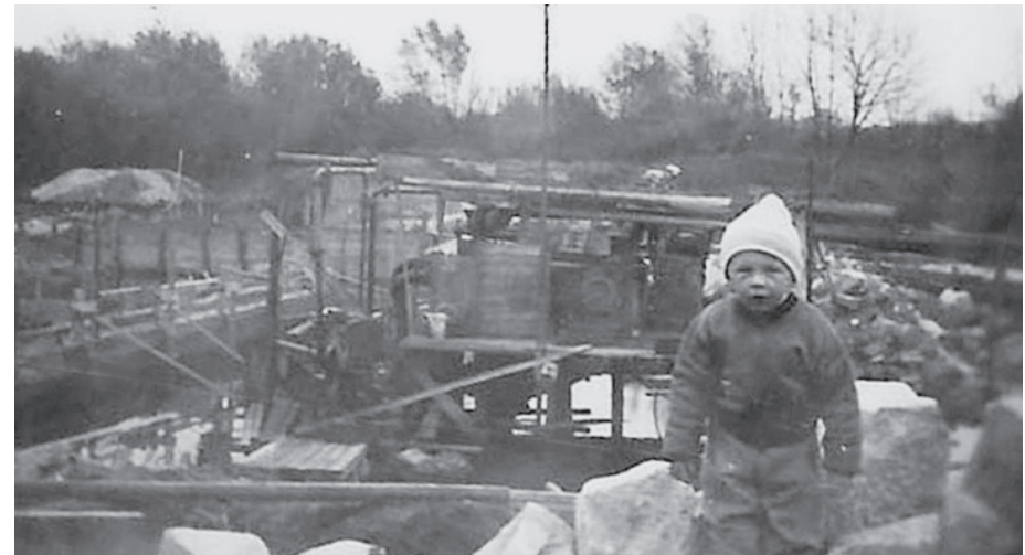
Abb. 6: Bau der Bühnenanlage an der Traisen, 1958
