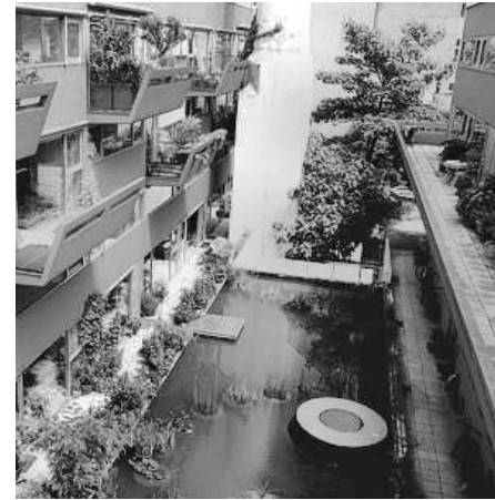
Abb. 100: Sargfabrik, Wien, 1996 BKK-2 Architektur
