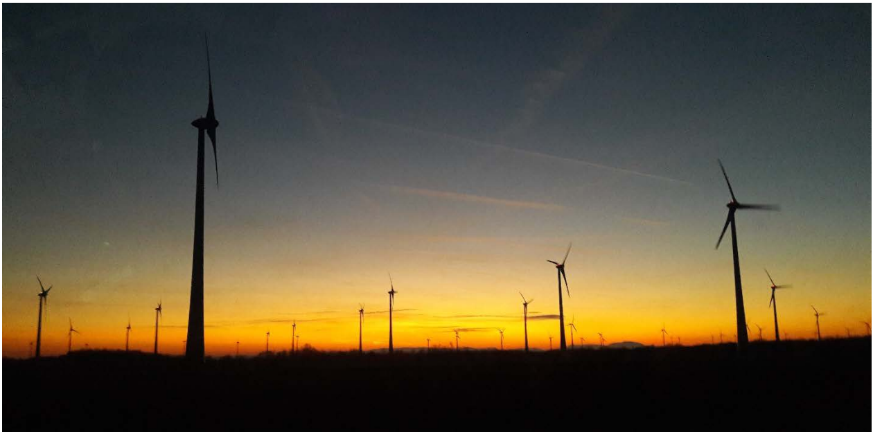
Abbildung 30: Windkraftanlagen Mönchhof/Gols (eigenes Foto, 2018)
