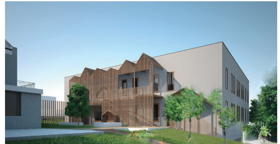
Holzlamellen mit Giebelöchern als Filterebene
