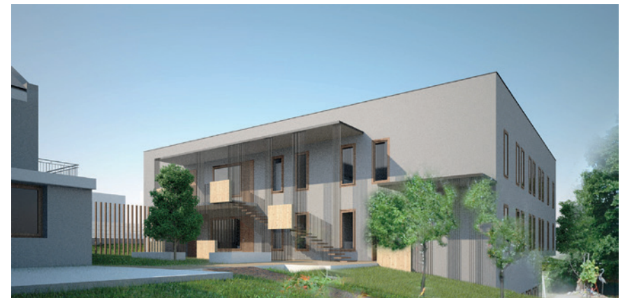
Stahllamellen mit vorgehängten, begrünten Holzkästen
