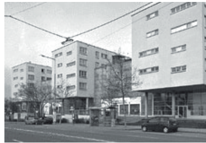
Abb.12:Gemeindebau Laaer Berg -Straße 67
