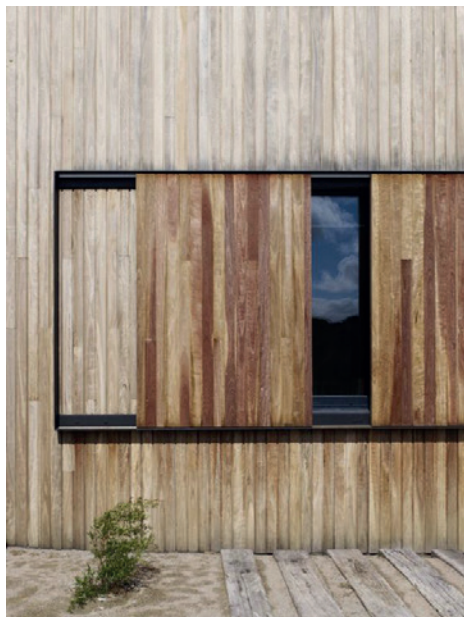
Abb.45: Lamellenfassade horizontale Schiebeläden in Stahlrahmen, Mt Martha, Australia; wolveridge architects
