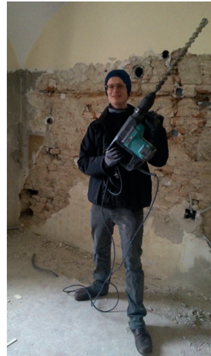
erste Probeöffnungen des Bodens im Erdgeschoss
