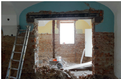
Unterfangen der neuen Wandöffnung Küche
