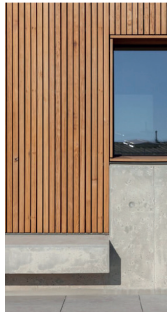
Abb.47: Lamellenfassade, Holzrahmenblende Fenster, Betonsockel, Avanca/Portugal; nu.ma architects
