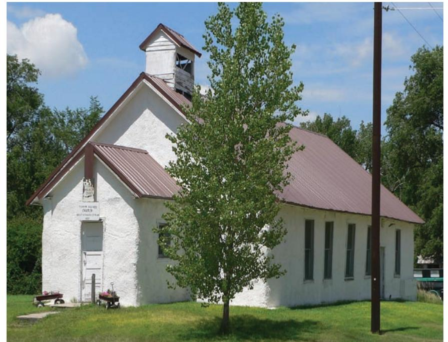
Abb. 30\_Das älteste bestehende lasttragende Strohballenhaus
