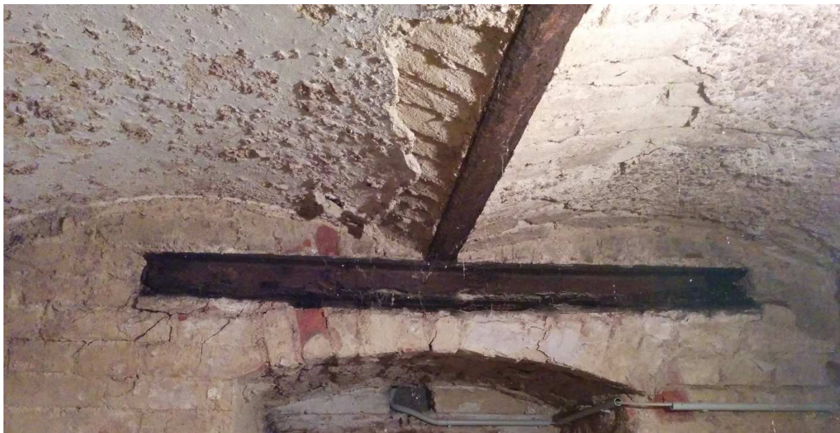
Abb. 1.7: Untersicht einer Platzdecke eines Wiener Gründerzeithauses [Aufnahme des Autors]
