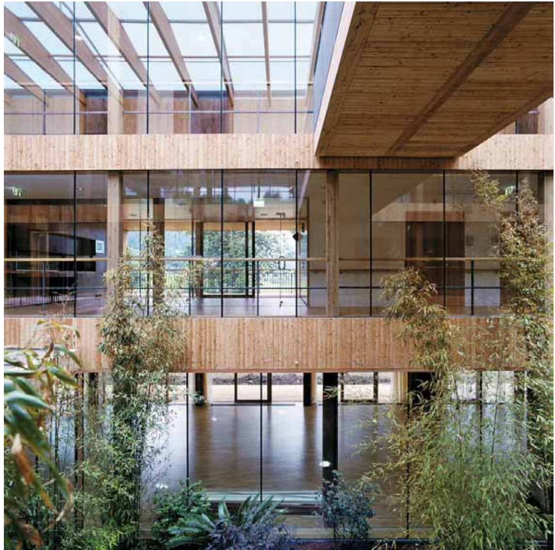
Abb. 31: Atrium im Altenwohn- und Pflegeheim Steinfeld, Dietger Wissounig Architekten
