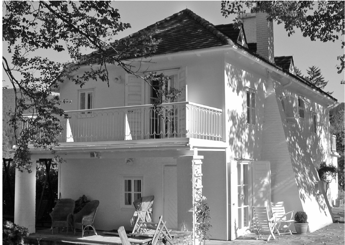
Abb. 53: Erdgeschossige Terrasse vor dem Wohnzimmer und die Terrasse vom Schlafzimmer von Haus Bunzl
