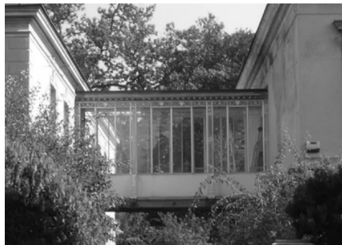
Abb. 70: Verglaster Verbindungsgang, Lainzer Straße
