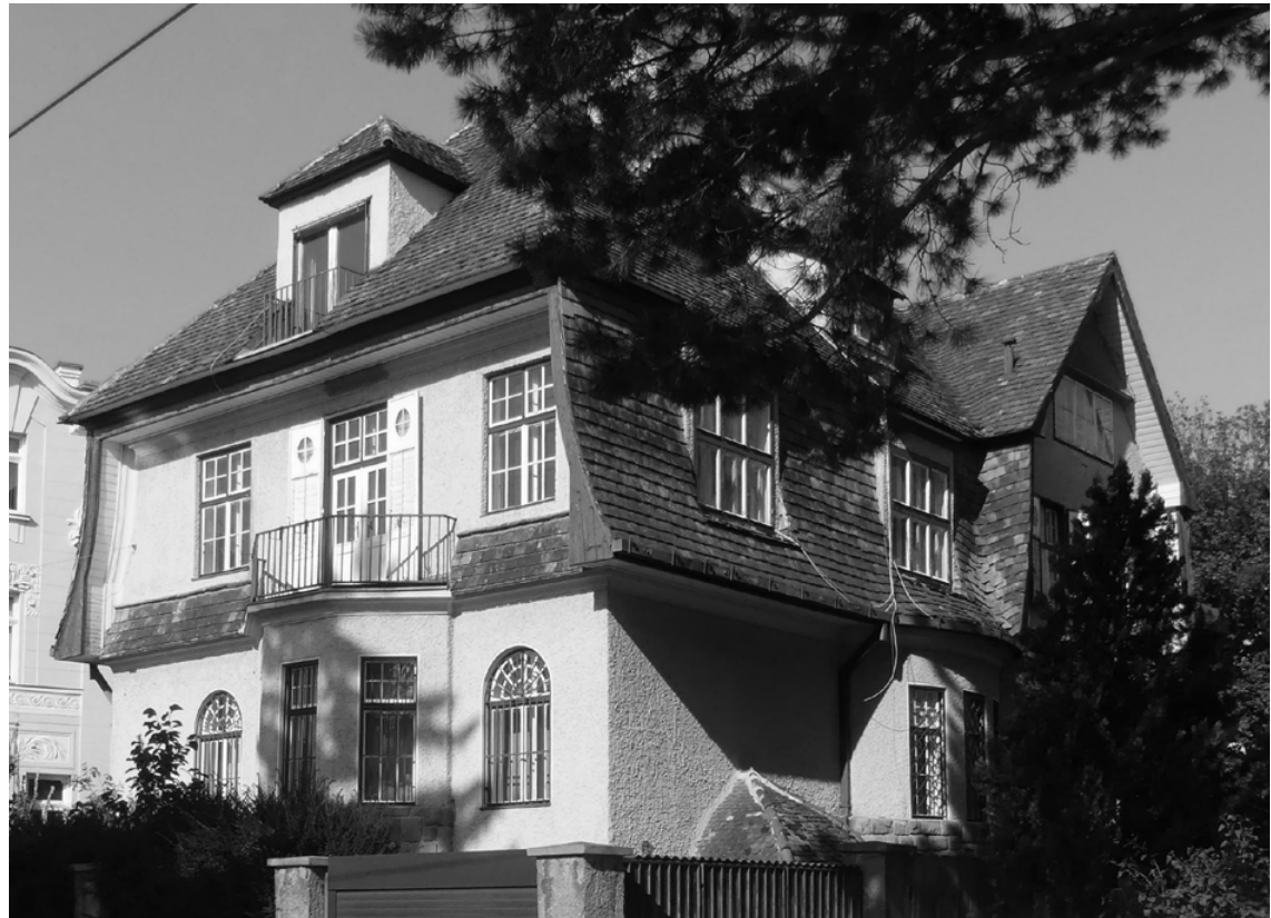
Abb. 66: Prominente Dachkonstruktion, Kopfgasse
