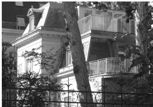
Abb. 68: Terrassen auf Dachlandschaft, Kopfgasse
