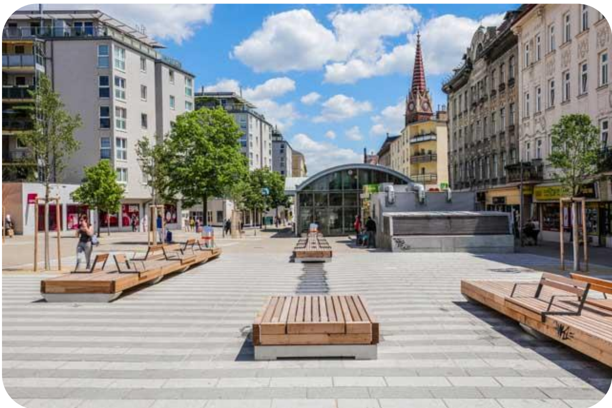
Abbildung 7: Neue Wasserwelt nach der Umgestaltung; Quelle: MA19, Architektur und Stadtgestaltung
