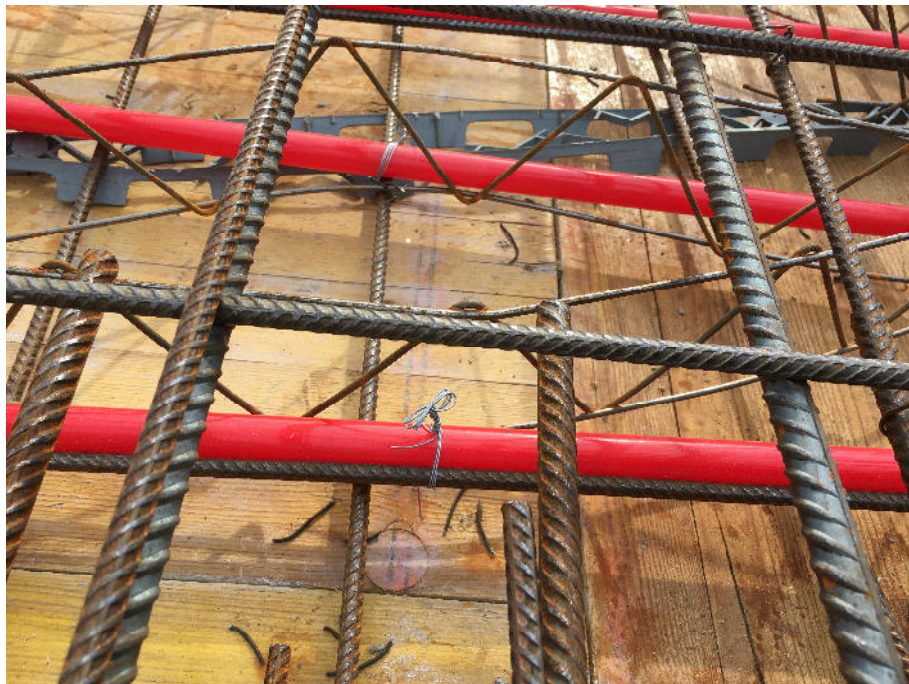
Abbildung 42: Detailfoto - Befestigung der Rohrleitung an die Bewehrung (Quelle: Hoffmann J., 2018)
