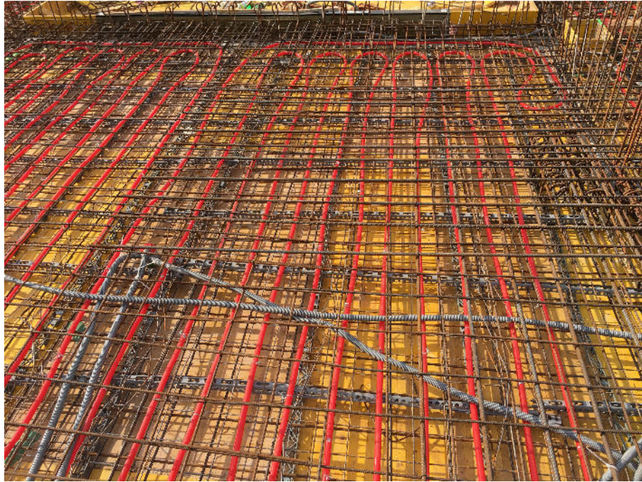
Abbildung 43: Detailfoto - Fertigverlegte Ortbetondecke
