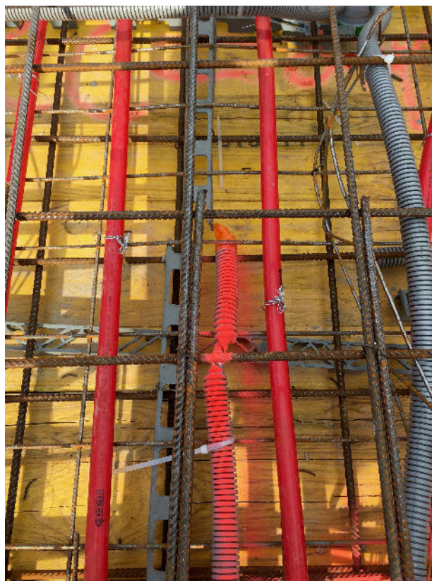
Abbildung 35: Detailfoto - Temperaturfühler zwischen den Rohrleitungen (Quelle: Hoffmann J., 2018)
