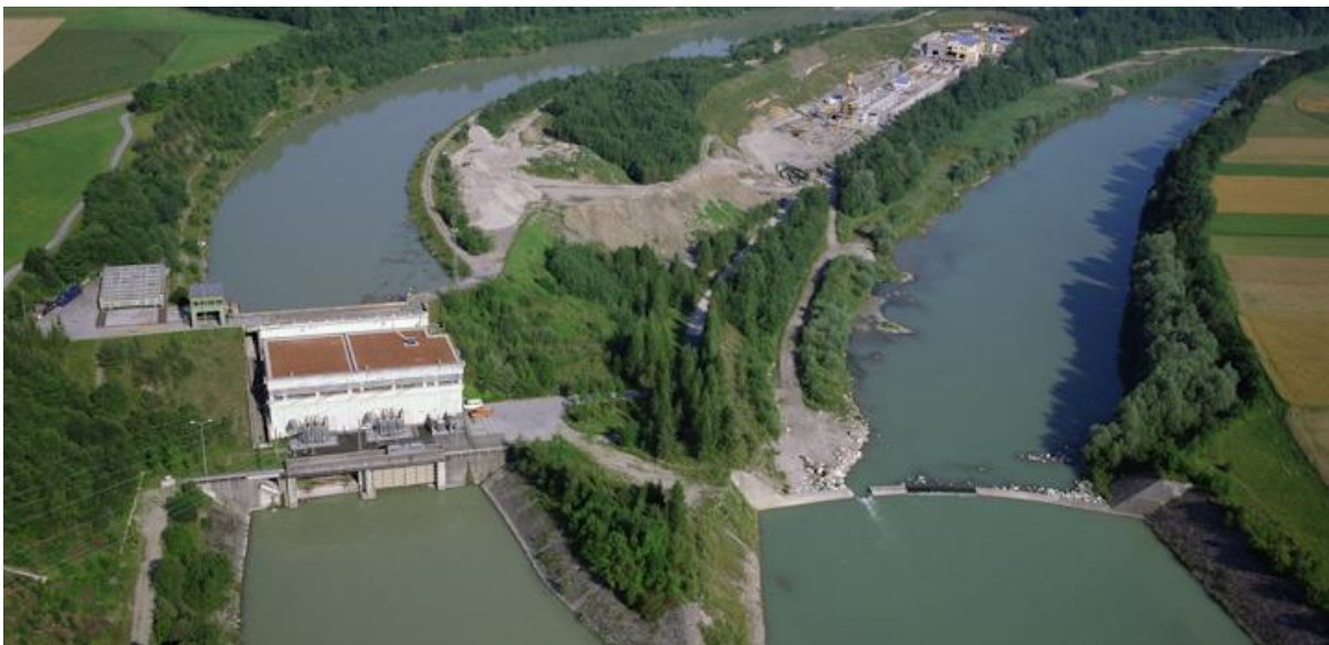
Abbildung 10: Beispiel für Ausleitungskraftwerk: Kraftwerk Rosegg-St. Jakob, Drau, Österreich (© VERBUND, 2015)
