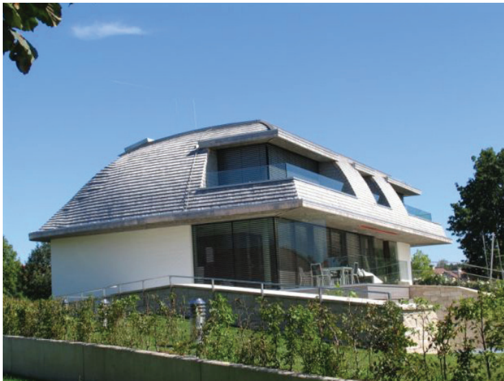
Abb. 50: Haus mit Holzschindeldach
