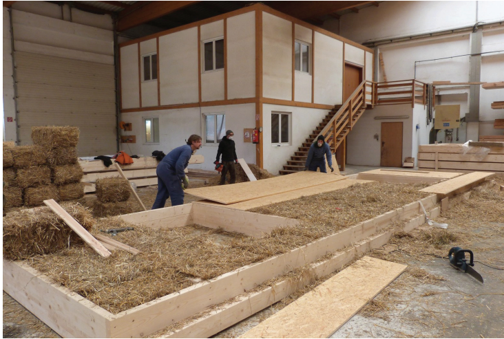
Abb. 35: Befüllen der Wandelemente Haus Herler
