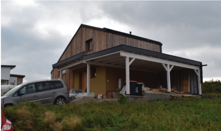
Abb. 42: Ansicht Haus Rausch mit Carport
