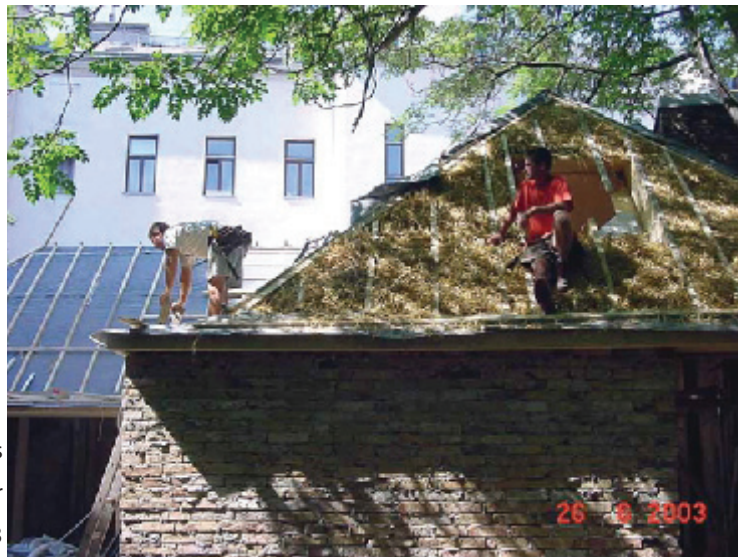
Abb. 9: Dämmen des Daches des ersten Wiener Strohballenbaus, 2003
