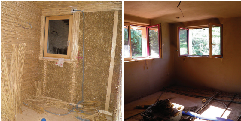
Abb. 41: Wände Haus Rusch - unverputzt und verputzt
