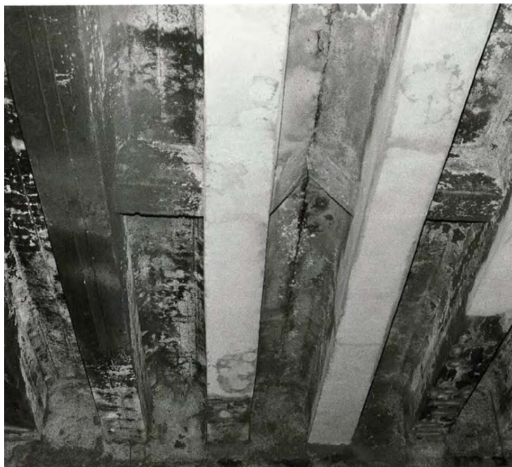
4.8.4 Sanierte Balken
