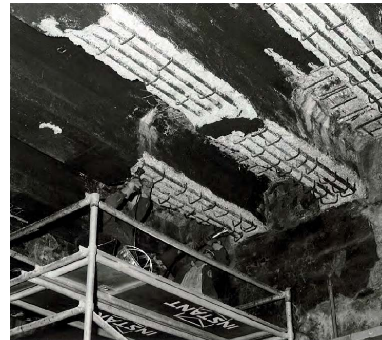
4.8.2. Freilegen der Armierung
