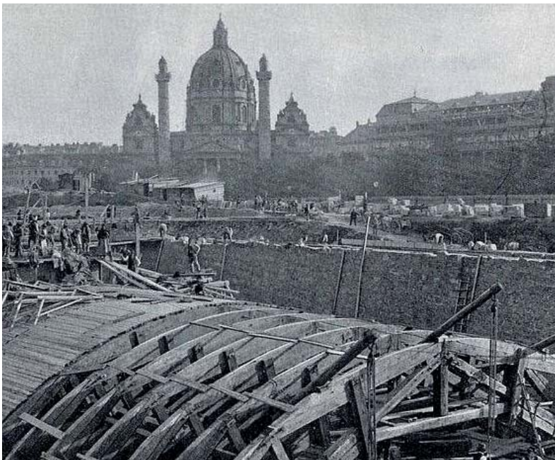
4.2.2 Arbeiten der Eindeckung beim Karlsplatz 1897–1898
