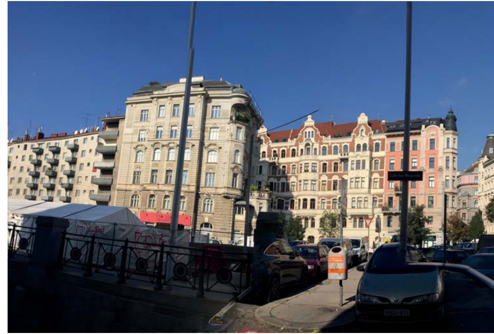
5.2.5 Bebauung an der Linken Wienzeile
