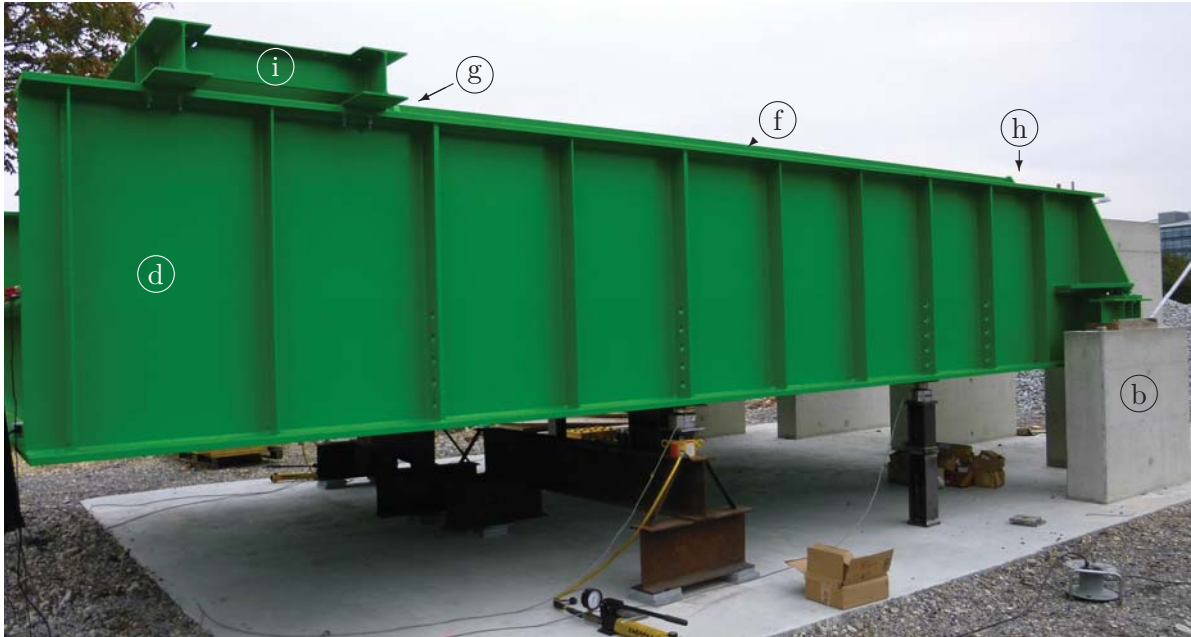
Abbildung 5.3: Versuchsanlage bei der Wägung
