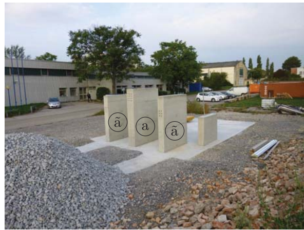
(b) Endzustand des Fundaments
