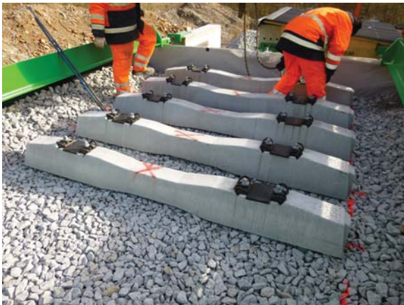
(a) Positionieren der Schwellen
