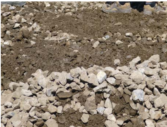
(a) Nahaufnahme - Zustand
