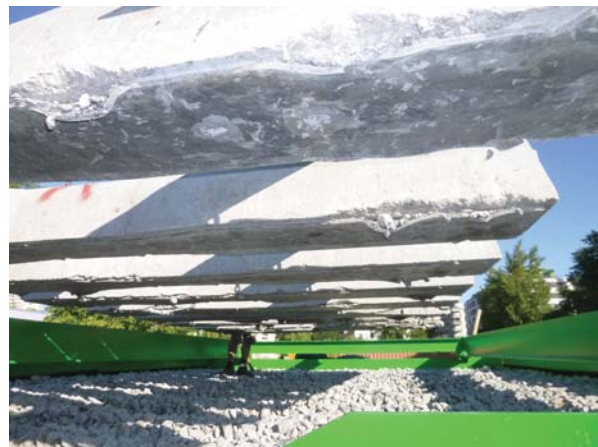
(b) Untersicht Schwellen
