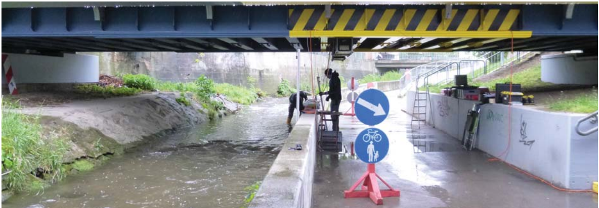
Abbildung 7.6: Überblick zu den sich gleichenden Versuchsaufbauten für TW Gl. 3 und TW Gl. 4; hier dargestellt: Tragwerk Gleis 4 (Blick entgegen der Fließrichtung des Mödlingbaches)
