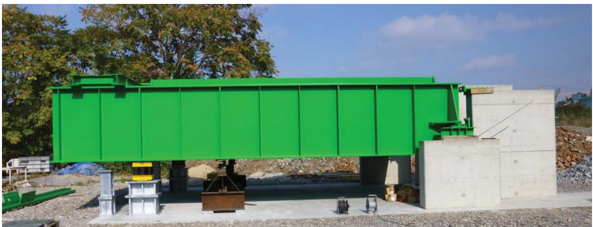
Abbildung 5.1: Versuchsanlage ohne Schotteroberbau vor Ausschwingversuchen
