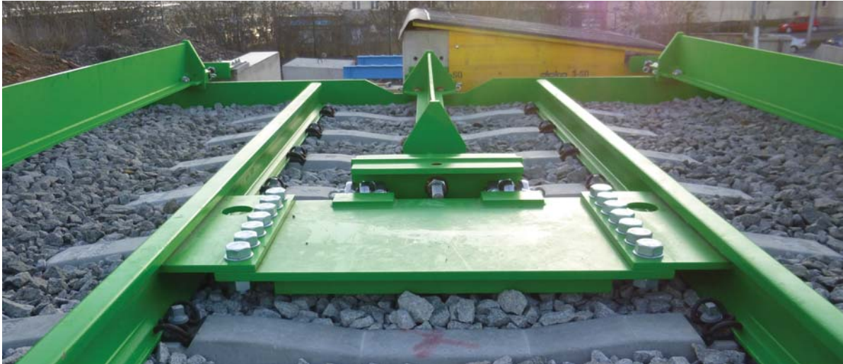
Abbildung 5.10: Versuchsanlage mit Schotteroberbau mit angekoppelter Ankerstange
