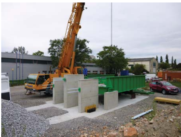
(a) Montage Brückentrog
