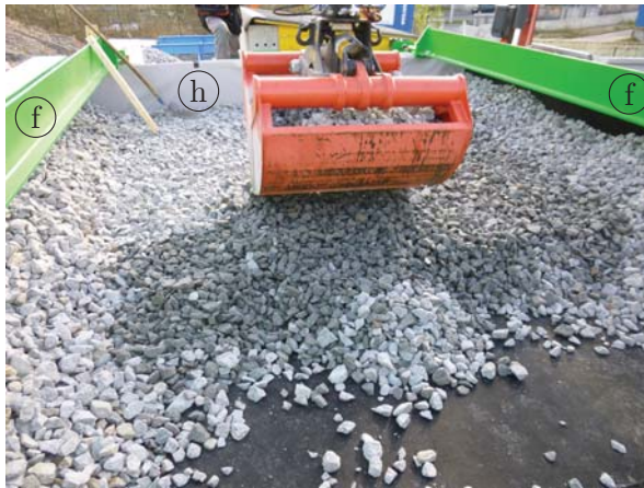
(a) Einfüllen des Schotters
