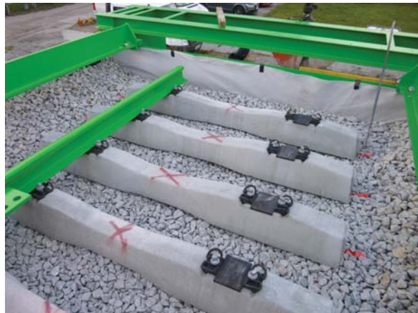
(b) Versetzen der Schienen
