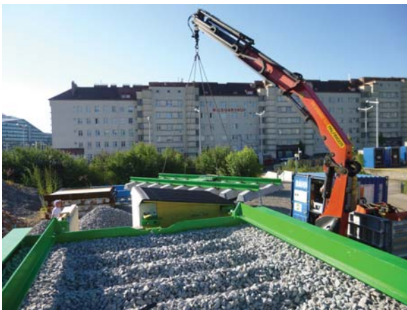
(a) Entfernen des Gleisrostes
