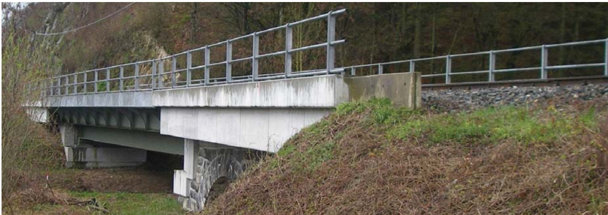
Abbildung 7.1: Fahrenbachviadukt (aus [Kir12])
