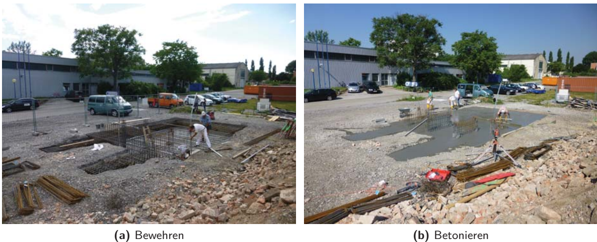
Abbildung 4.18: Herstellung der Fundamentplatte
