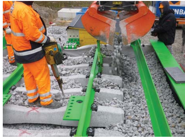
(b) Einschottern des Gleises
