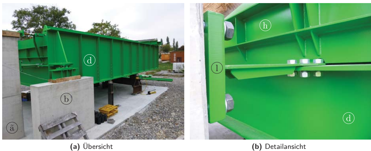
Abbildung 5.6: Horizontalverankerung des Brückentroges im gelockerten Zustand
