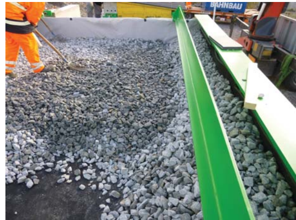
(b) Verteilen des Schotters
