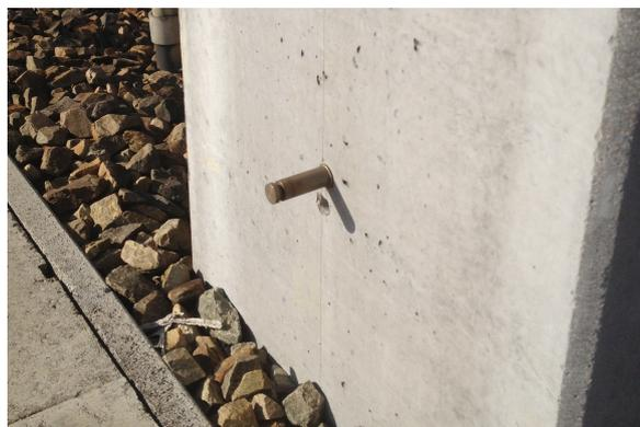
Abbildung 5.5: Mastbolzen, montiert auf einem Fahrleitungsmast (Durchmesser: 15mm; Länge: 60mm).
