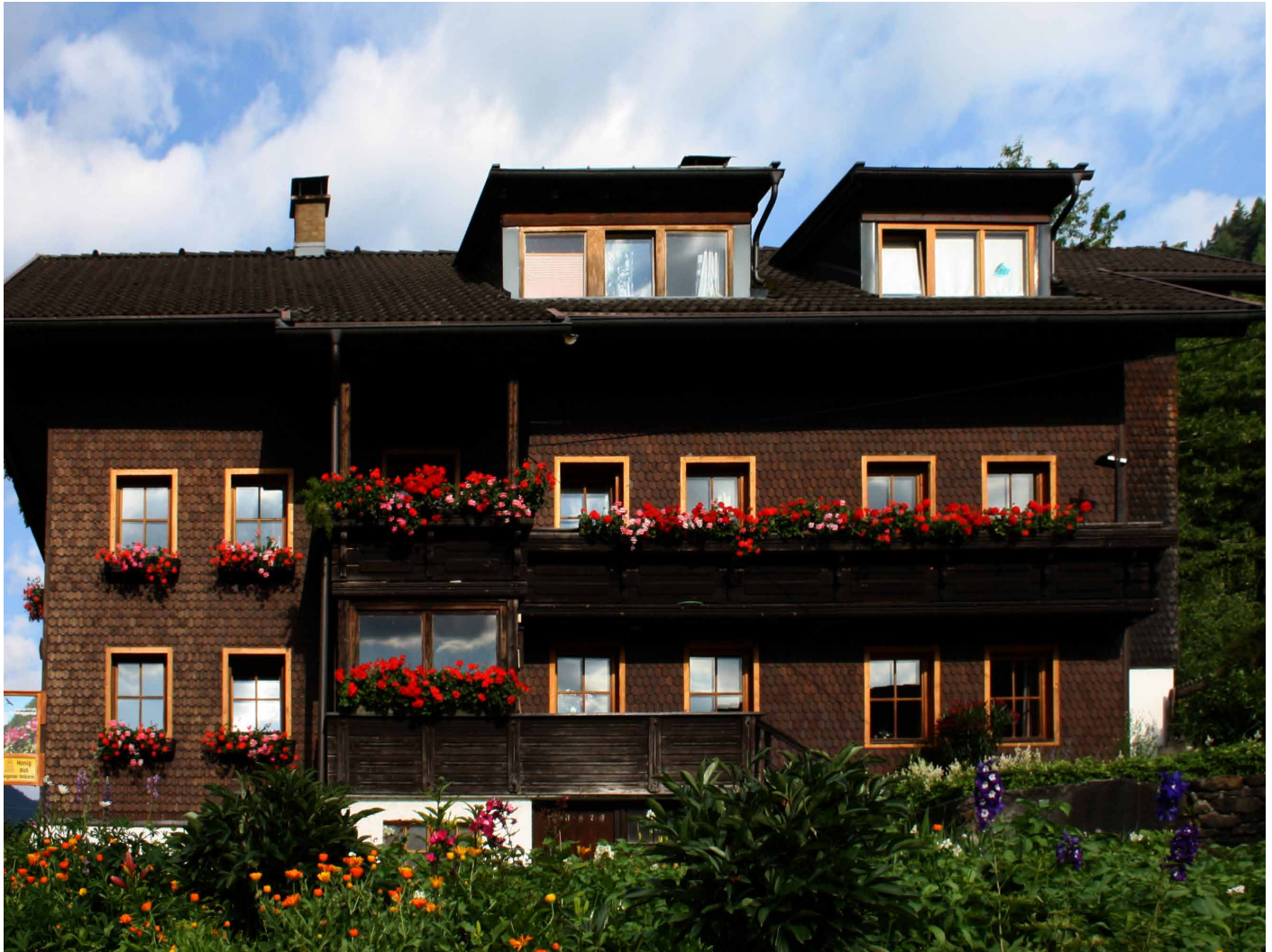
Hopfgarten: Ostfassade in der Morgensonne im Talboden
