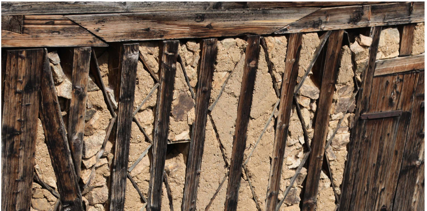
Yağcılar: Fülltechnik mit Bruchstein und Matsch
