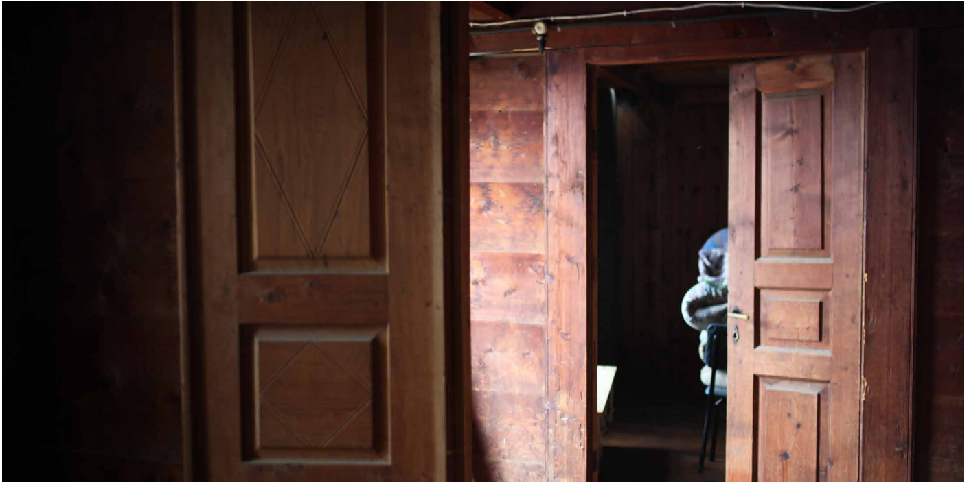
Yağcılar: Innenwände als Bohlenständerwände und Türrahmen
