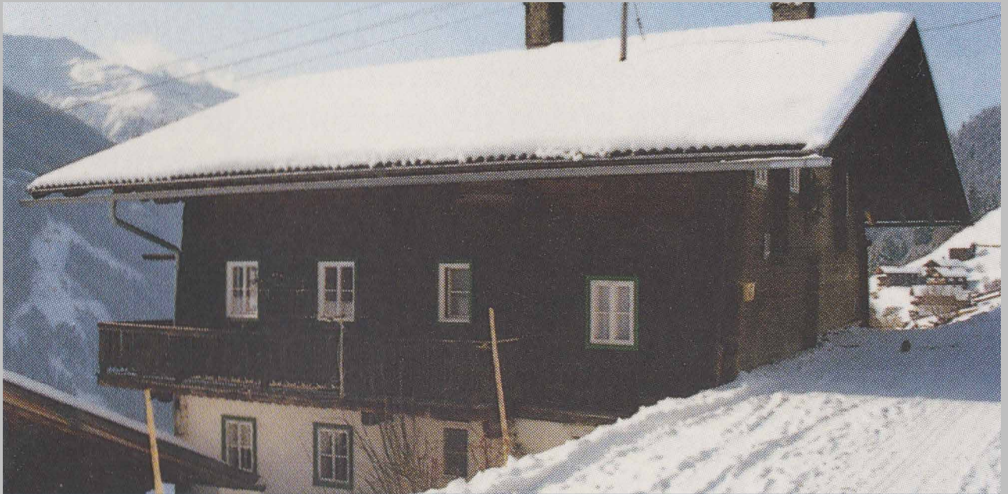
Gritzen: Traufseiten und Giebelseiten geschützt durch den auskragenden Satteldach von der Schneedecke
