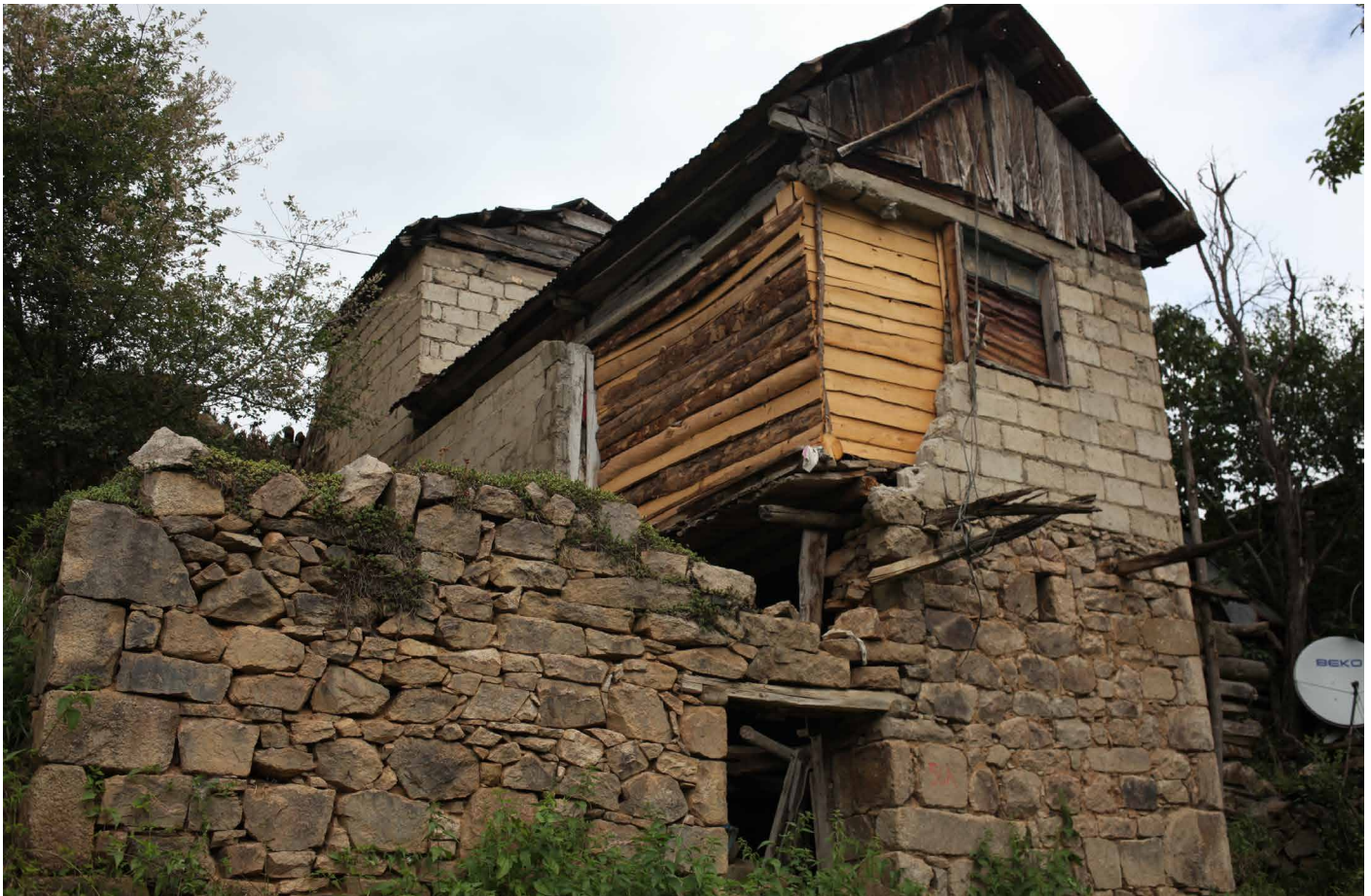
Yagcilar: mit Ziegeln modifiziertes Haus, welches mit Holz repariert wurde
