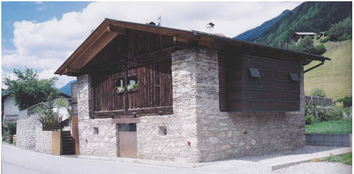
Ahrntal (Südtirol): renoviertes Steinhaus „Haus Tasser“
