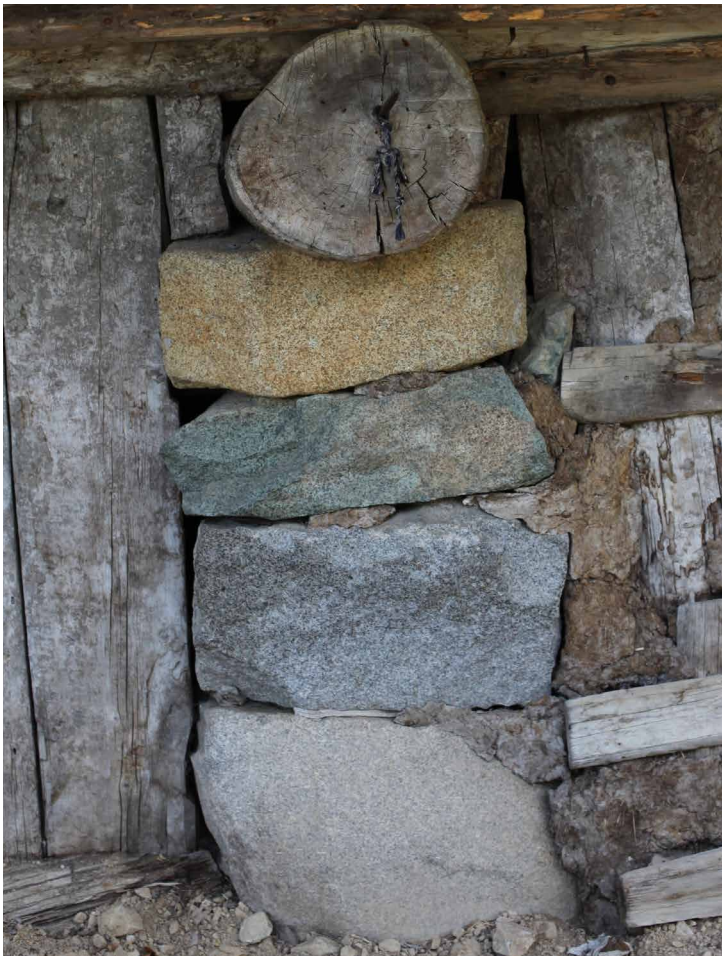
Gölyayla Stein & Holz im Fundament
