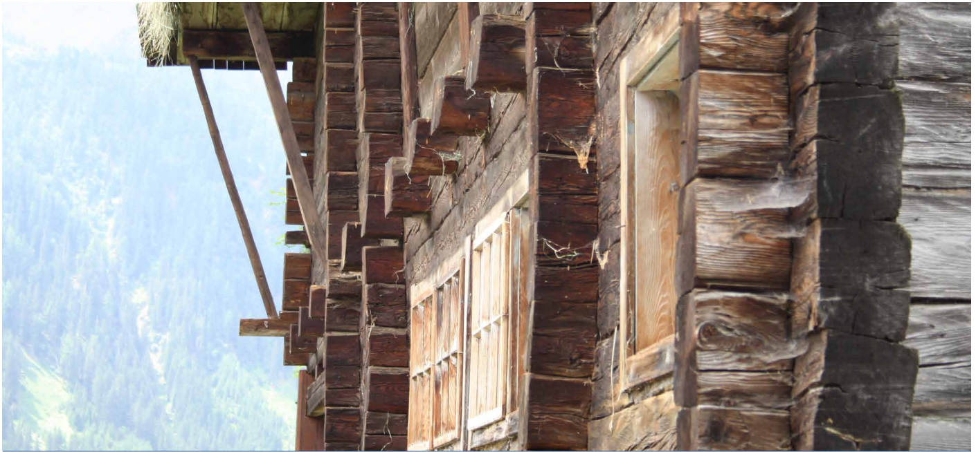
Hopfgarten: Futterhaus in Blockbauweise - Detail
