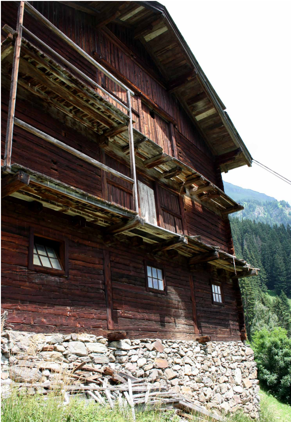
Hopfgarten Stall mit Steinfundament und Blockbau
