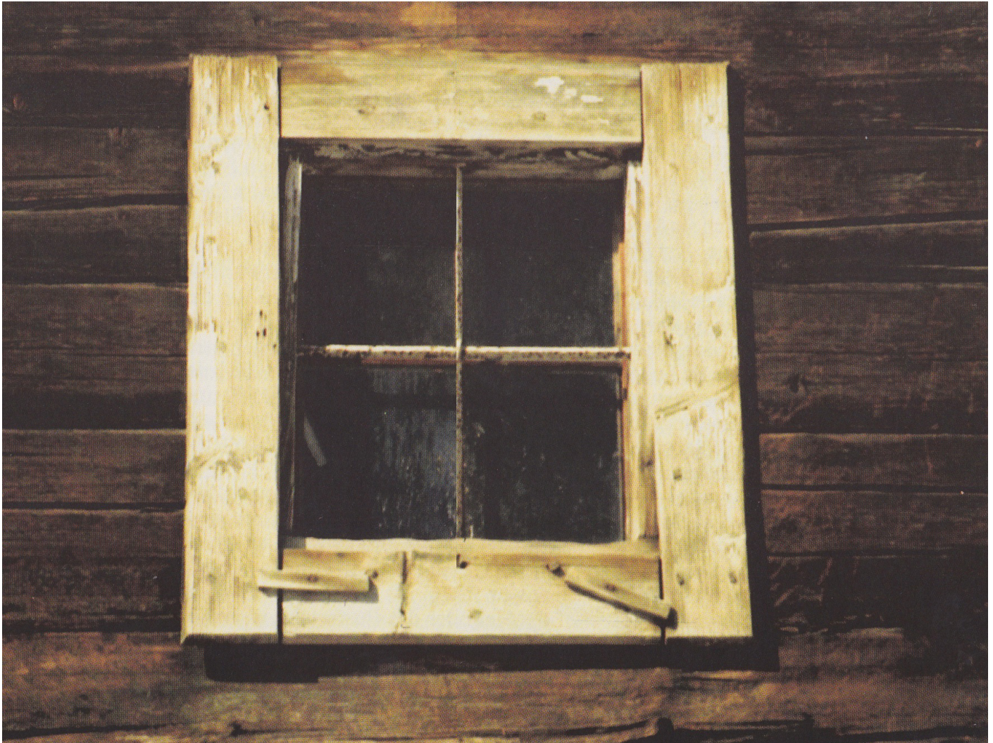
Deferehgental: Fensterrahmen mit Verglasung
