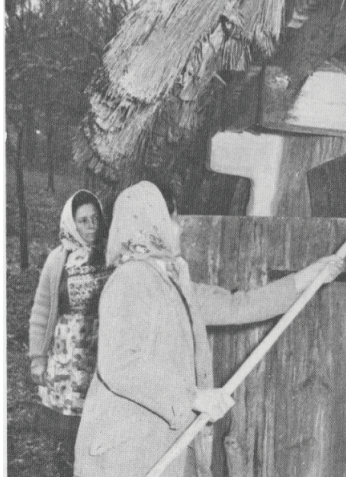
Abb. 39, links Beim Weißkalken des Lehms Abb. 40, rechts weißgekalter Lehm
