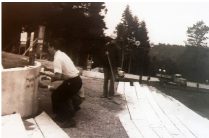
72 Historische Aufnahme von der Errichtung der Zugangstrepfen, September 1972
