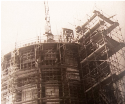
70 Historische Aufnahme vom Bau des Denkmals 3
