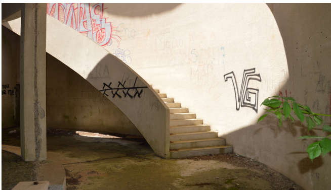
112 Treppenansicht von unten
