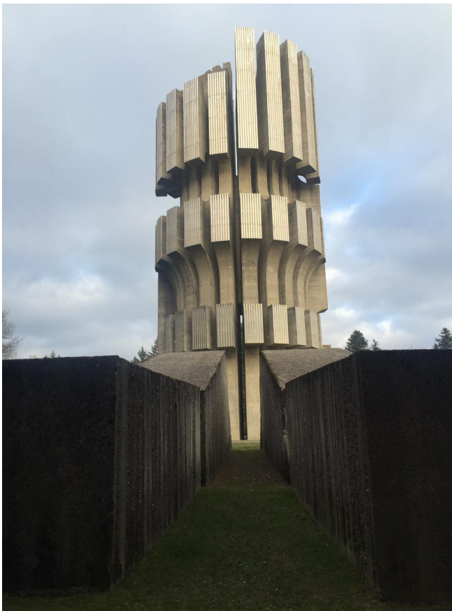
77 Blick durch die zweite Gruppe der Betonblöcke
