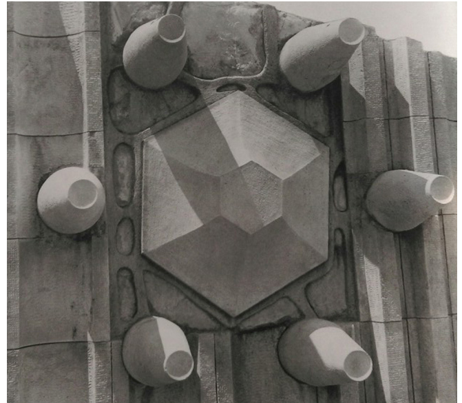
37 Kannelierten Stützmauern mit kosmischen Symbolen, Detail, 1968
