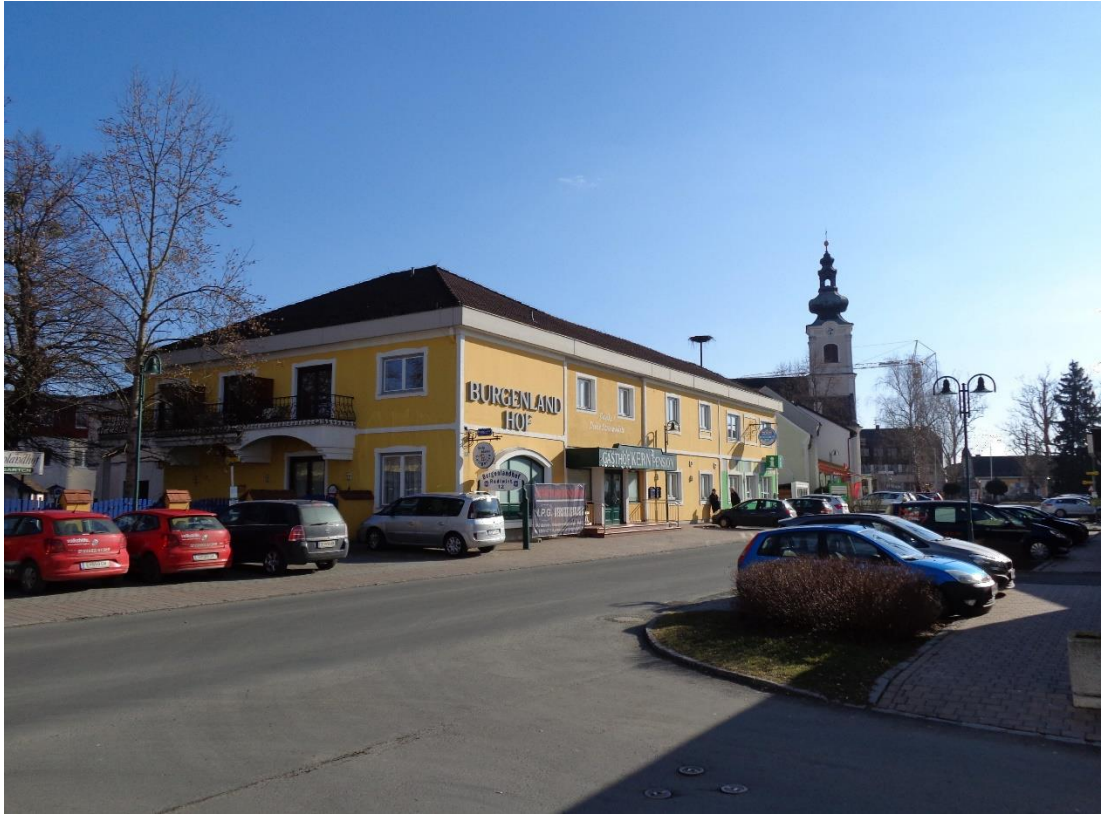
Abbildung 15: Burgenlandhof in Jennersdorf vor Umbau (OSG)
