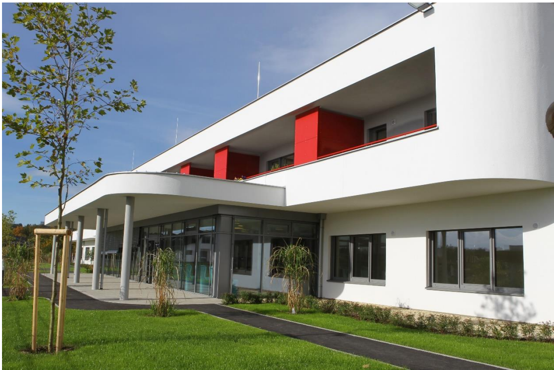
Abbildung 21: Demenzzentrum Oberwart Ansicht 1 (OSG)
