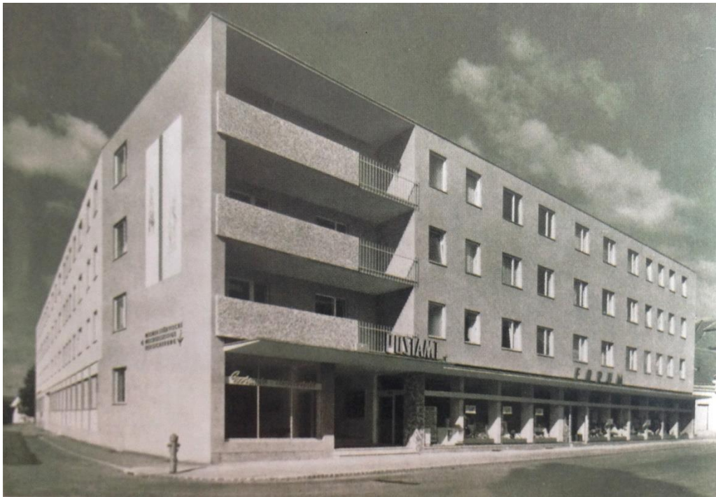
Abbildung 9: 1. OSG-Wohnanlage in Oberwart aus dem Jahr 1960 (OSG)
