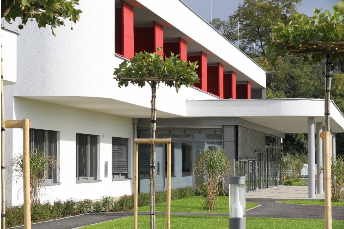
Abbildung 22: Demenzzentrum Oberwart Ansicht 2 (OSG)
