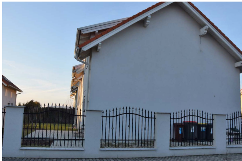
Abb. 55: Warum sind an der Außenwand des letzten Reihenhauses keine Fenster platziert? Wurde hier an Planung gespart?
