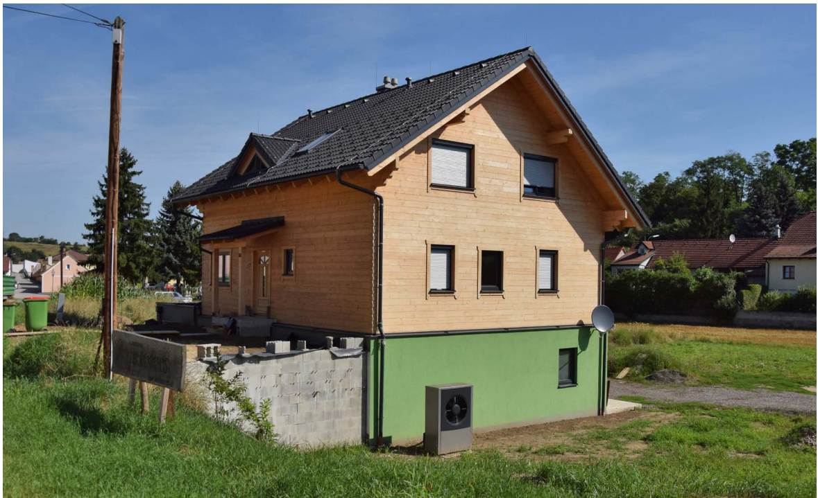
Abb. 90: Eine (Fertigteil-) Blockhütte auf einem „grünen“ Keller. Auf dem Holzschild davor ist zu lesen: „Original Scandinavian Blockhaus“.
