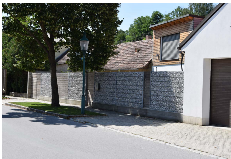
Abb. 74: Hinter dieser massiven Einzäunung aus Geröll lässt sich das Haus nur mehr erahnen.
