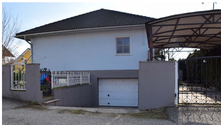
Abb. 54: Diese Straßenfassade wirkt wenig einladend.
