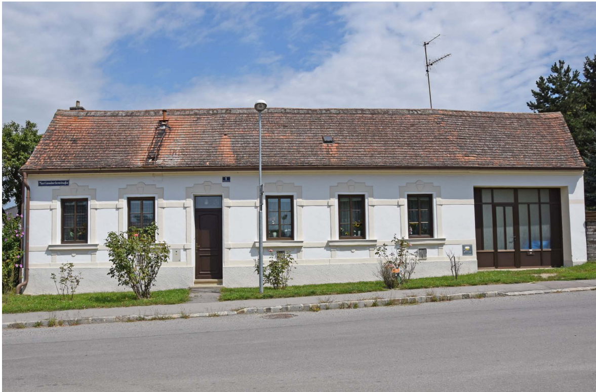
Abb. 27: Ein renoviertes Weinviertler Gassenfronthaus. Ursprünglich waren Kastenfenster und ein Holztor verbaut.
