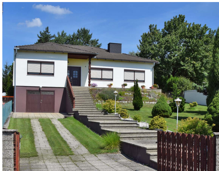
Abb. 46: Anstatt das ansteigende Gelände für eine flachere Garageneinfahrt zu nutzen, wurde dieses Gebäude zusätzlich erhöht.
