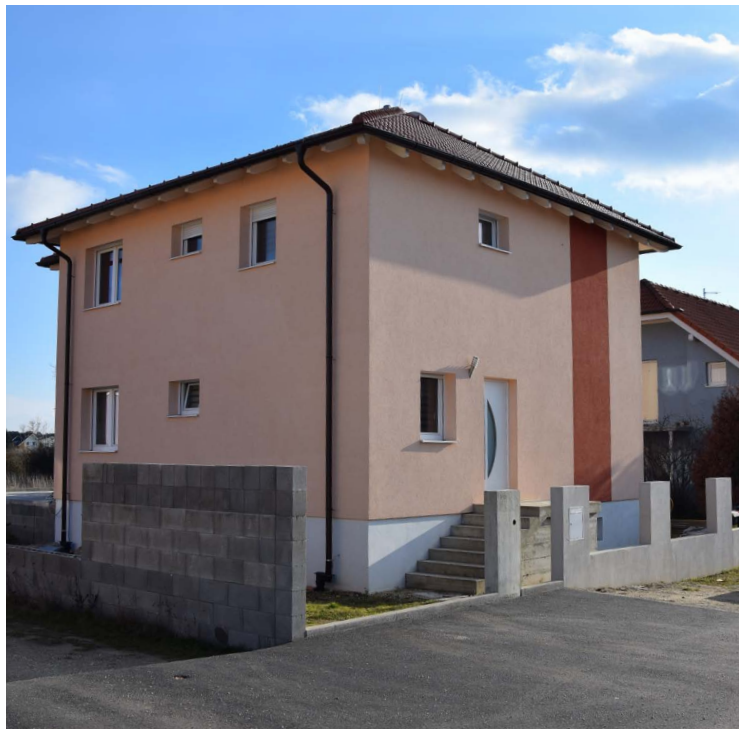
Abb. 57: Der energieeffiziente Kubus funktioniert wie eine Thermoskanne, zu viele Öffnungen sorgen für Wärmeverlust. Dass die Straßenfassade an einer sparsamen Fensteranordnung leidet, ist vielen nicht bewusst.
