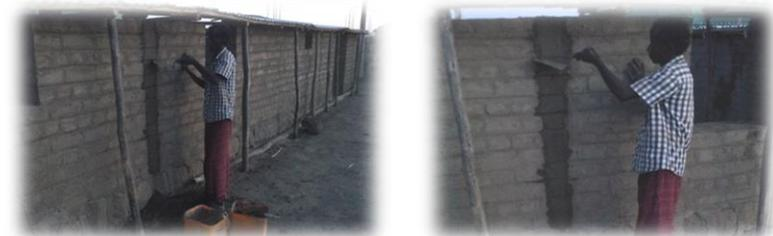
Abbildung 4-29 Ausbessern von Schäden einer Lehmsteinwand, Logiya 2016
