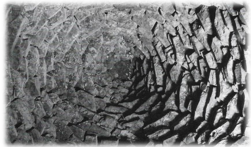
Abbildung 5-8 Kragkuppelgewölbe aus geschichteten Steinen von innen (Löbbecke, 2012)
