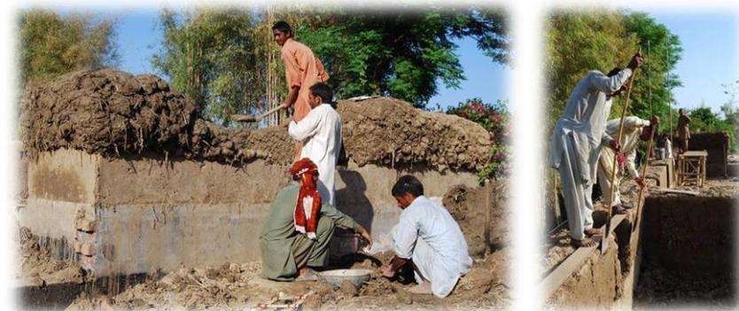
Abbildung 4-8 Wellerlehm-bau ([www.lehmbau-atlas.de/...](http://www.lehmbau-atlas.de/))
