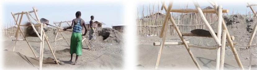
Abbildung 4-28 Sieben der Zuschlagsstoffe, Logiya (Filmausschnitt Kießling, 2017)
