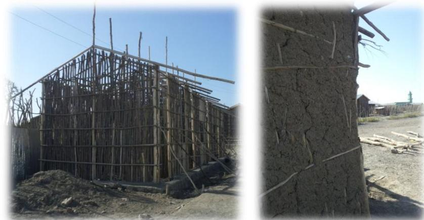
Abbildung 3-25 Konstruktion Chikka Haus (links) und Lehmausfachung (rechts), Logiya 2016
