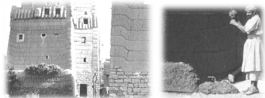
Abbildung 4-13 (links) Zabur-Konstruktion unverputzt (Wichmann et al., 1983)
