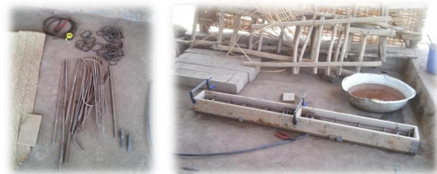
Abbildung 3-12 Bewehrungsstahl und Schalung für Sturz, Logiya 2016
