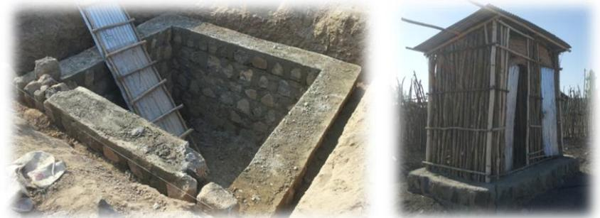
Abbildung 3-30 Grube für Trockentoilette und Trockentoilette in Logiya, 2016
