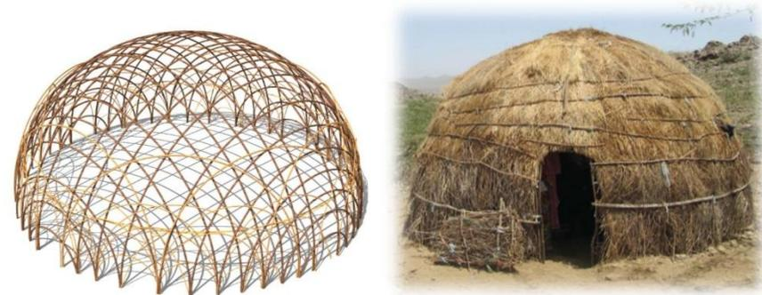
Abbildung 2-22 (von links nach rechts) Traggerüst der Daboyta (Schönher, 2015) und permanente Daboyta mit Schilfdeckung (Chocian, 2017)
