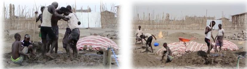
Abbildung 4-27 Stampfen der eingesumpften Mischung, Logiya (Filmausschnitt, Kießling, 2017)
