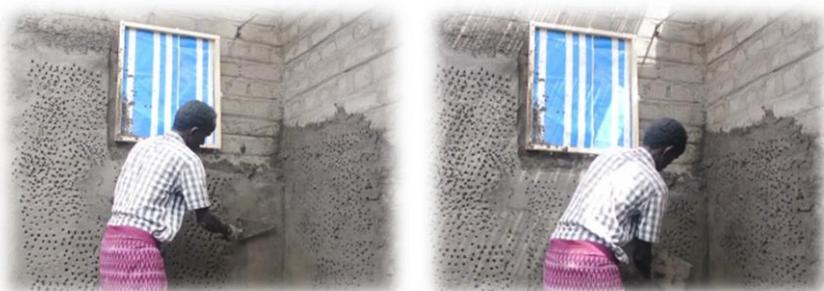
Abbildung 4-18 Glätten des Unterputzes und Bildung von Löcher, Logiya (Filmausschnitt Kießling, 2017)
