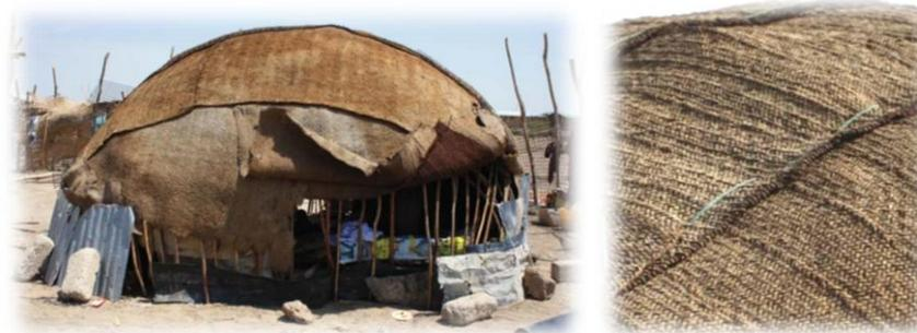
Abbildung 2-18 (von links nach rechts) Daboyta mit geöffneten Matten für die Luftzirkulation und gewebte Deckung aus Palmematten (Chocian, 2017)
