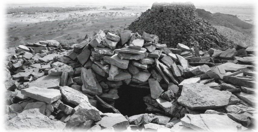
Abbildung 5-23 Lüftungsöffnung eines Kraggewölbes im Oman (Löbbecke, 2012)
