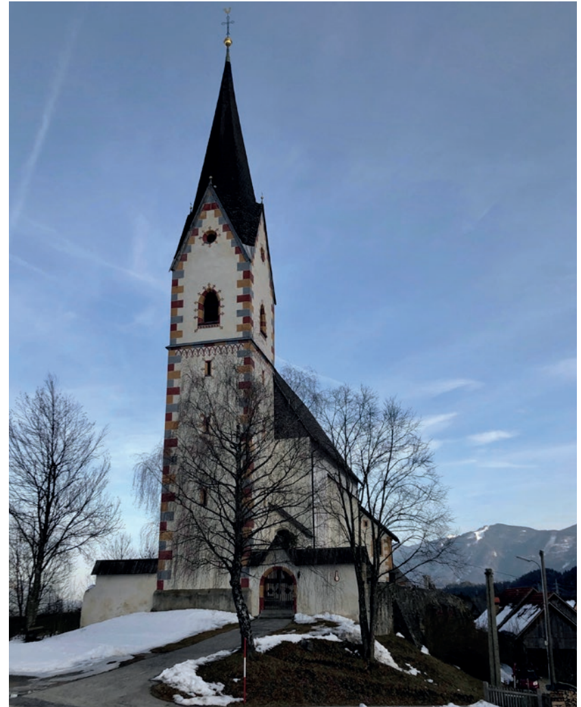
Abb.95: Kirche in Göriach (AT) mit Resten der Wehrmauer und einem massiven Kirchenturm
