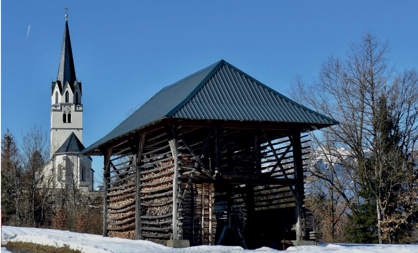
Abb.107: Kärtner Kese (Harpfe) mit Blick auf die Kirche in Feistritz an der Gail, bei Achomitz (AT)- leider ohne originale Schindeldach.
