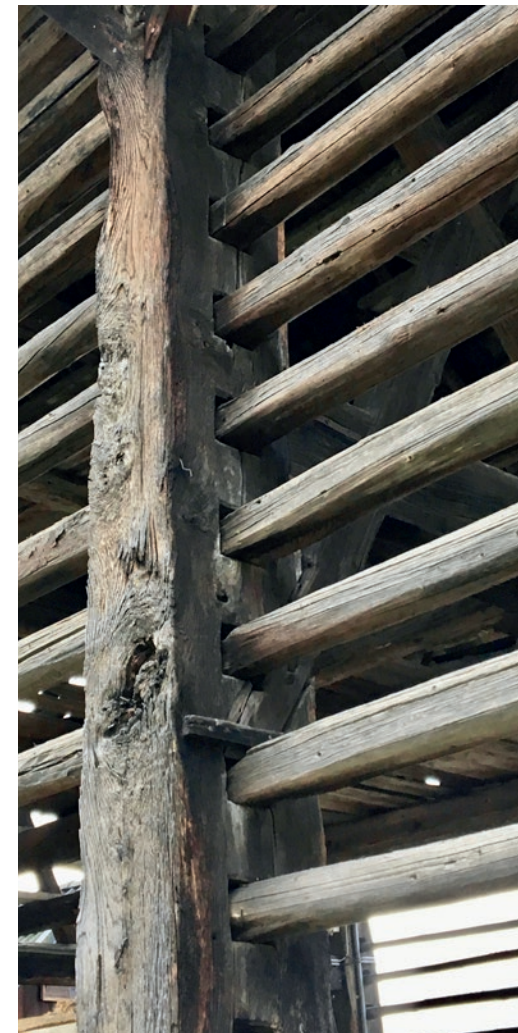
Abb.108: Stützendetail der Harpfen
