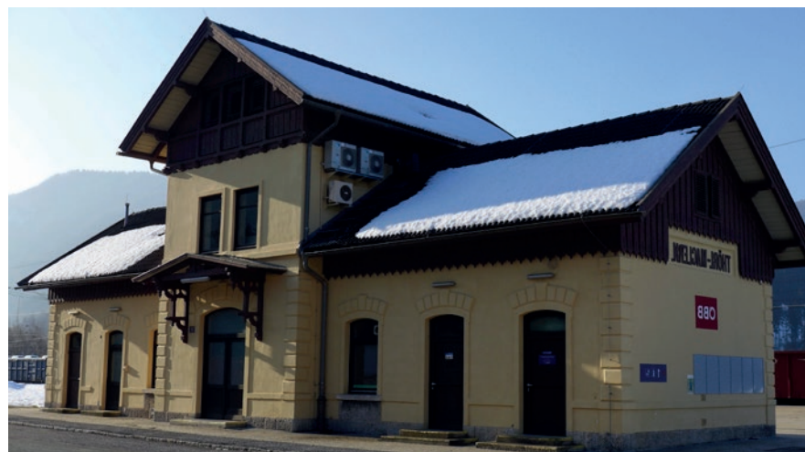
Abb.110: Das denkmalgeschützte Bahnhofsgebäude in Thörl-Maglern (AT) aus 1873.
