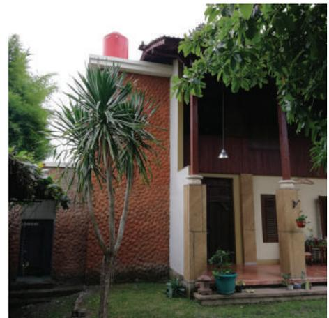
Der translozierte Gebäudeteil ist die Dachkonstruktion. Diese beruht auf der Form eines *limasan* und stülpt sich über das Gebäude. Im nördlichen Bereich ragt das Dach über den Grundriss.
