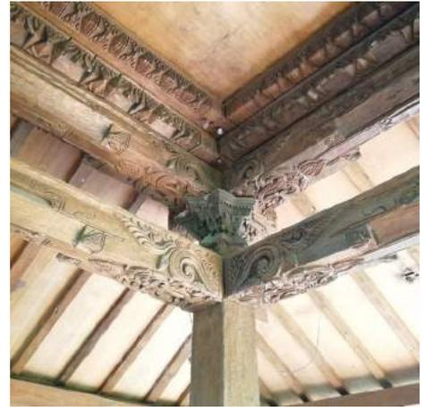
Die umliegende Stützenreihe ist eine Zusammenführung von recycelten Hölzern. Die Stützen weisen unterschiedliche Größen und Querschnittsformen auf und sitzen entweder auf umpak oder auf betonierten Sockel auf.
