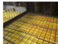
Bewehrung Decke K02 2.jpg
