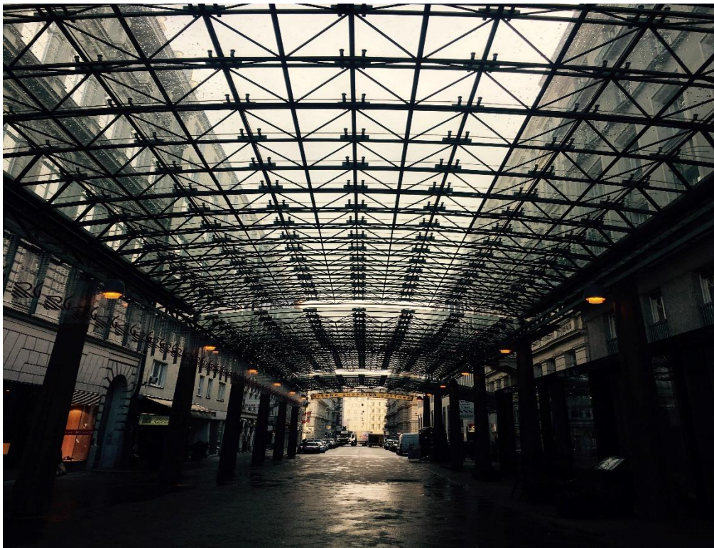
Abb. 10: Glasdach zwischen zwei Gebäuden-Fußgängerdurchgang (Wien, AT) - (eigene Aufnahme)
