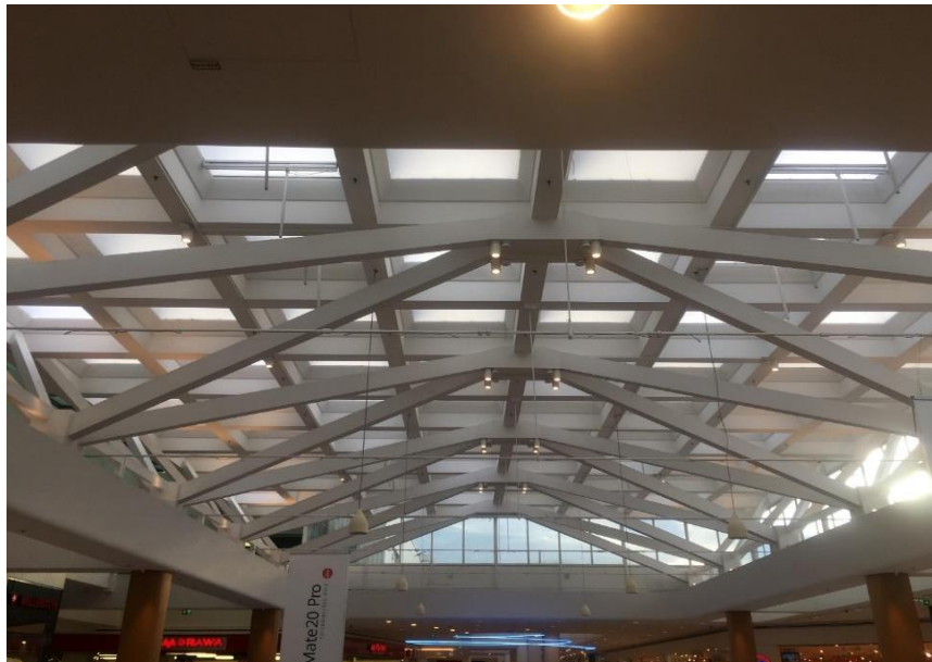
Abb. 1: Dachverglasung - SCS Wien (eigene Aufnahme)
