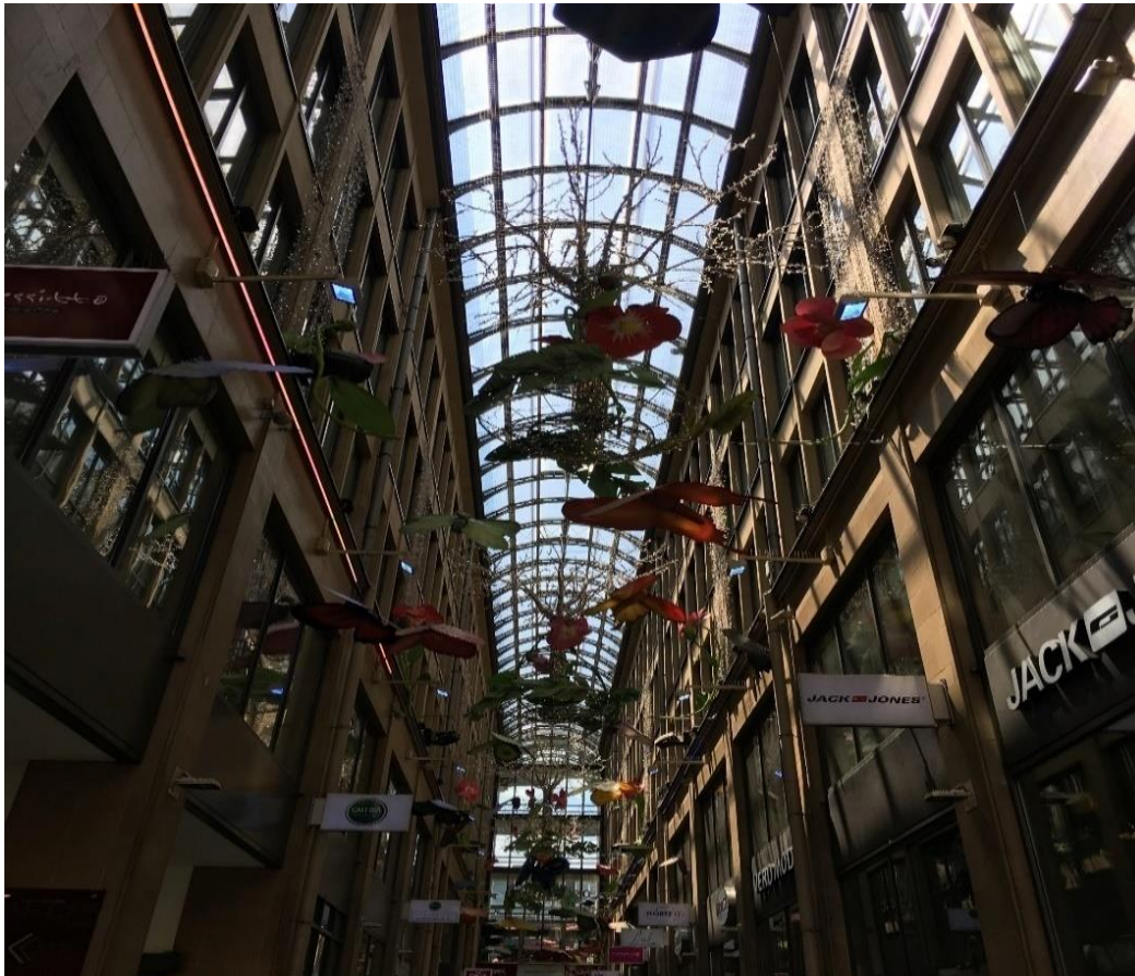
Abb. 8: Glasdach zwischen zwei Baukörpern (München, DE) - (eigene Aufnahme)
