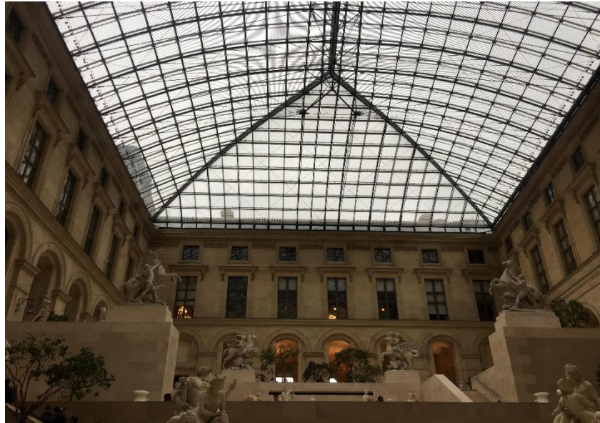
Abb. 2: Dachverglasung - Museum Louvre, Paris (eigene Aufnahme)
