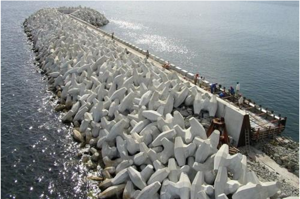
Abb. 29: Geschütteter Wellenbrecher aus Betonteilen (apexresearch, 2018)
