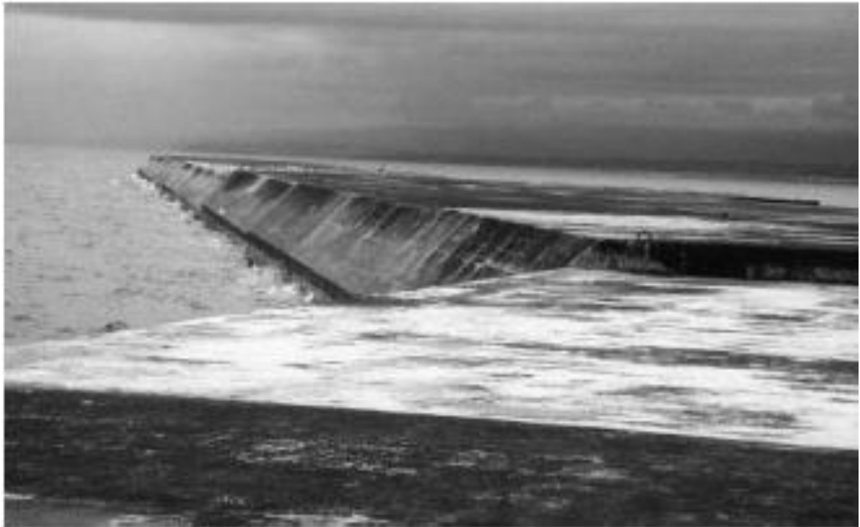
Abb. 27: Wellenbrecher mit abgeschrägter Krone (Brinkmann, 2005, S. 470)
