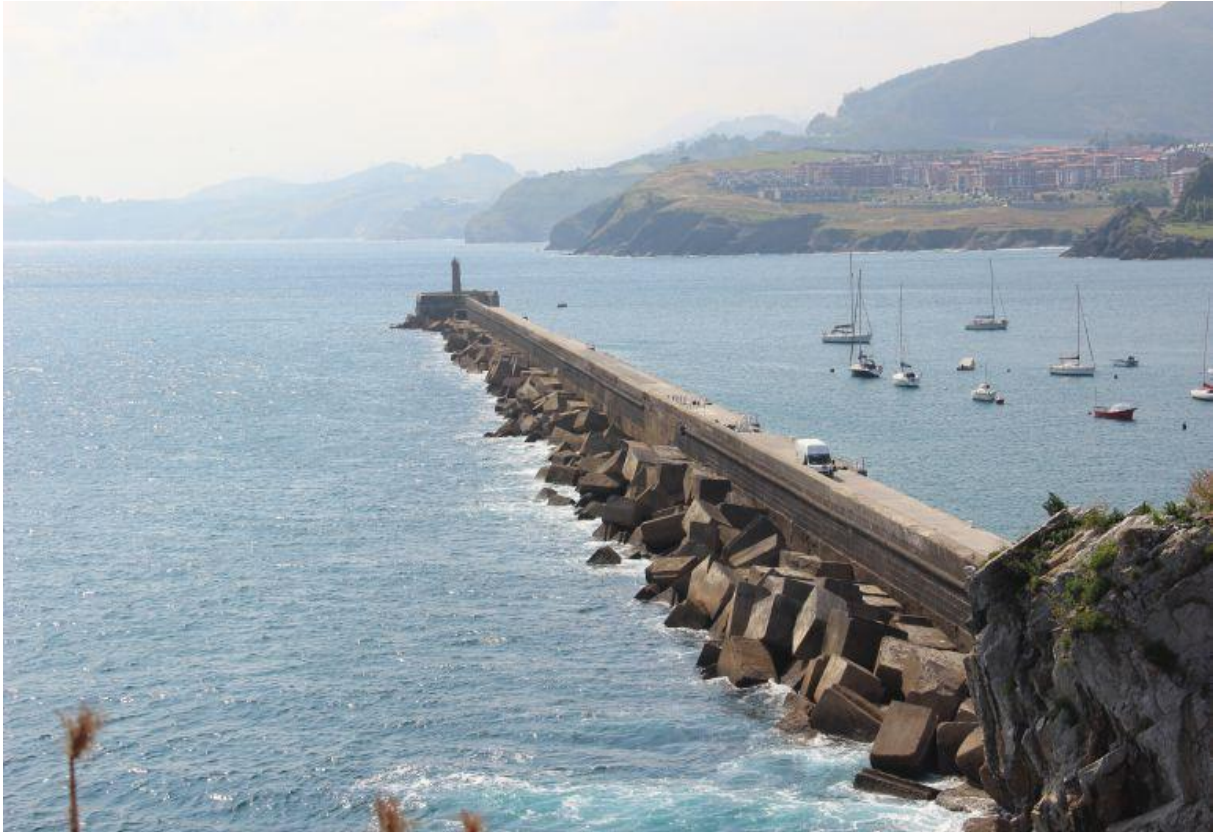
Abb. 35: Kombiniertes Wellenbrecher in Castro, Spanien (CadenaSER, 2018)
