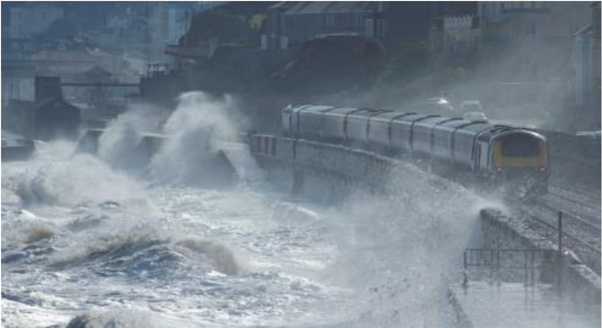
Abb. 5: Zugstrecke unter Einfluss von überschwappenden Wellen, GB (EurOtop, 2016, S. 1)
