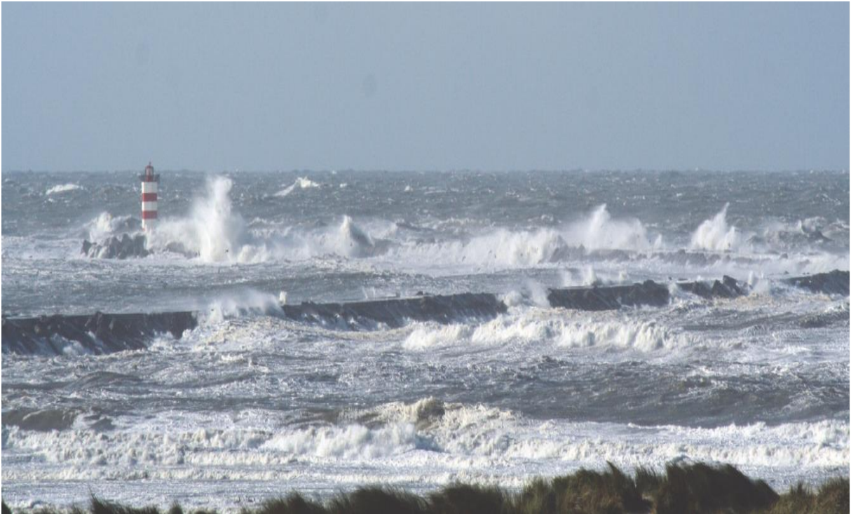
Abb. 13: Transmission durch Überschwappen, Niederlande (EurOtop, 2016, S. 44)
