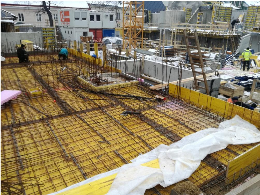
**Abbildung 1.:** Bewehrung in einer Schalung kurz vor Betonage
