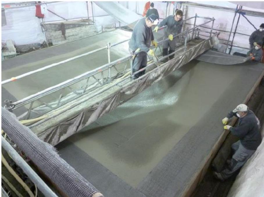
**Abb. 2-16:** Lageweise Herstellung der Textilbetonschale in Spritzbetonbauweise [14]
