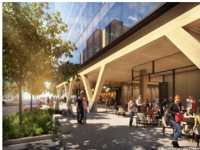
Abbildung 9.28: V-förmige Stützen im Erdgeschoss übernehmen die Lasten aus jeweils zwei Stützen der oberen Geschosse [122]
