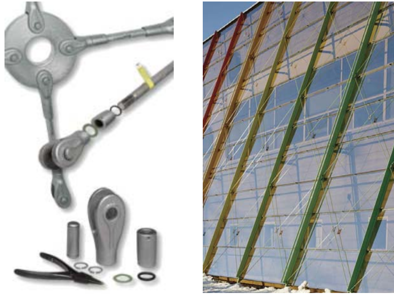
Abbildung 5.5: Detan Zugstäbe als Aussteifungsverbände [30]
