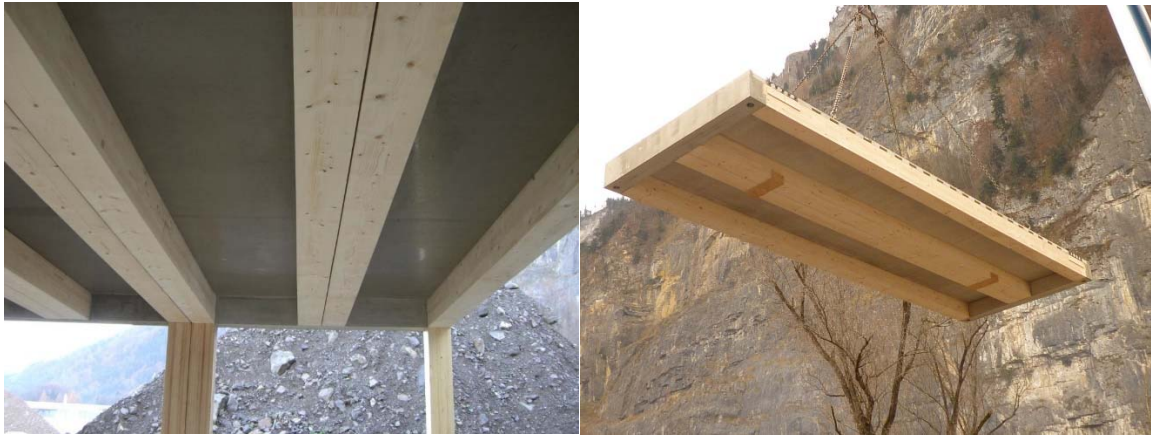
Abbildung 9.7 Verlegung der Deckenelemente [37]
