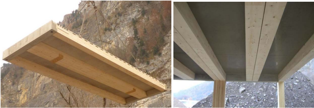
Abbildung 6.3: Fertigteile-HBV-Deckenelemente beim Bau vom Lifecycle-Tower [37]
