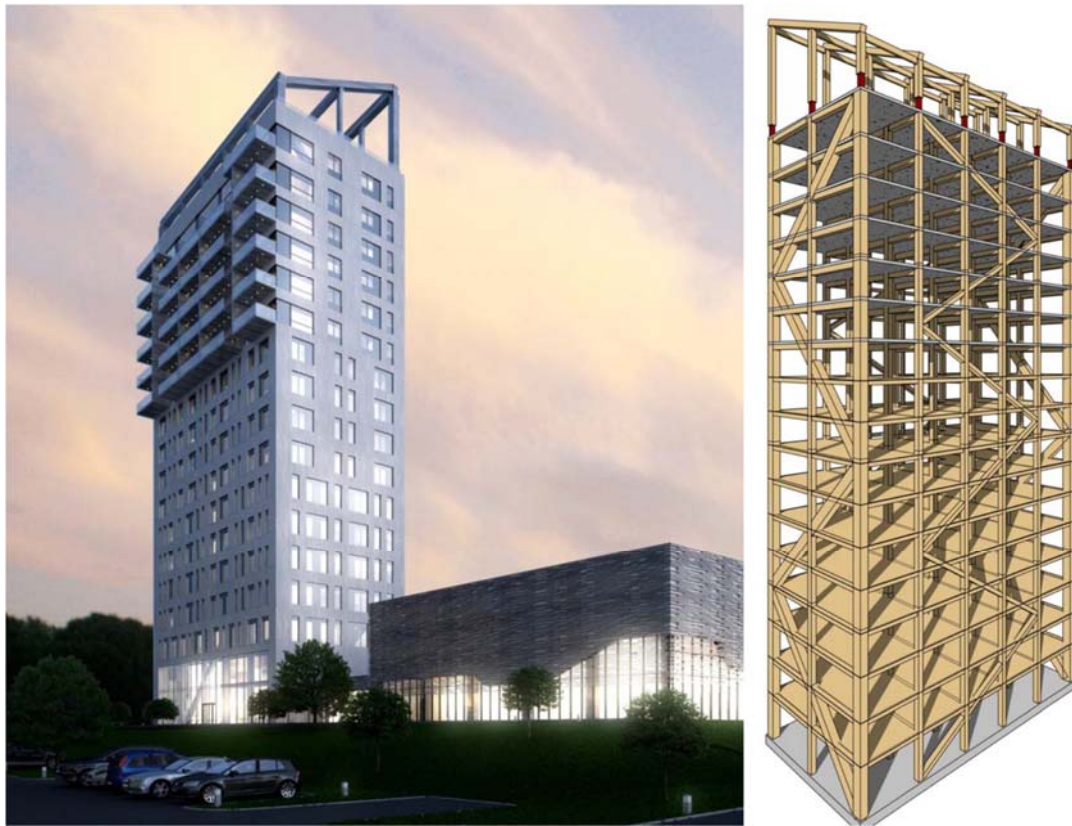
Abbildung 9.23: links: Mjostarnet Außenansicht; rechts: Tragwerksmodell [114]
