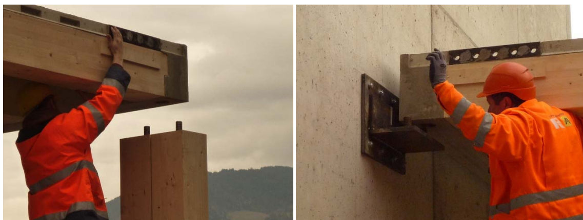
Abbildung 9.6: Auflagerausbildung der HBV-Deckenelemente [37]
