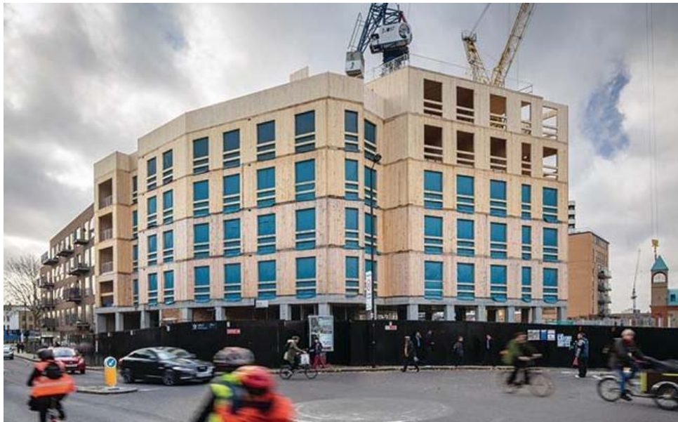
Abbildung 4.3: Brettsperrholzelemente während der Bauphase beim Dalston Lane Gebäude [26]
