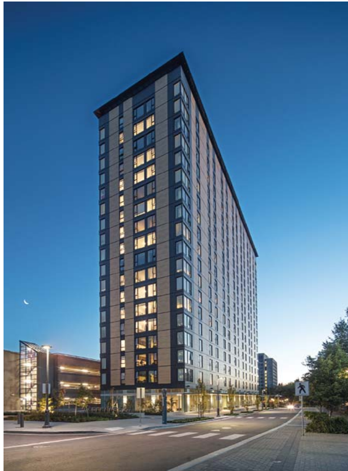
Abbildung 9.13: Brock Commons UBC-TallWood Building [86]
