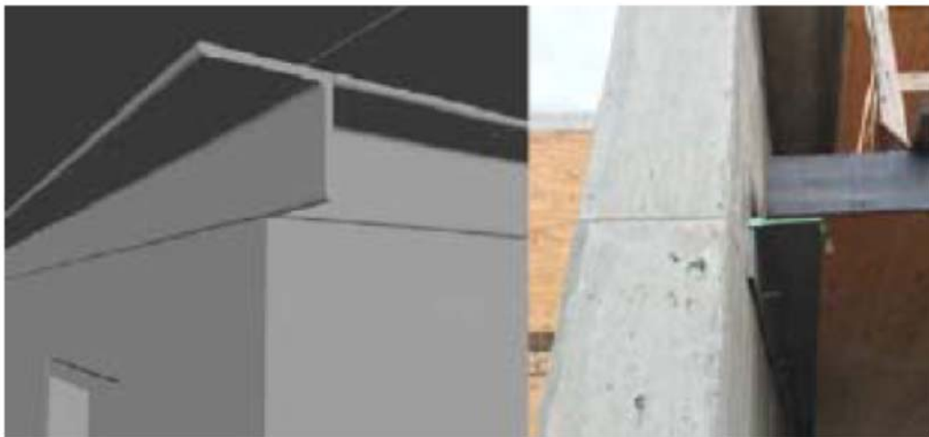
Abbildung 9.16: Auflager für CLT-Decken [88]
