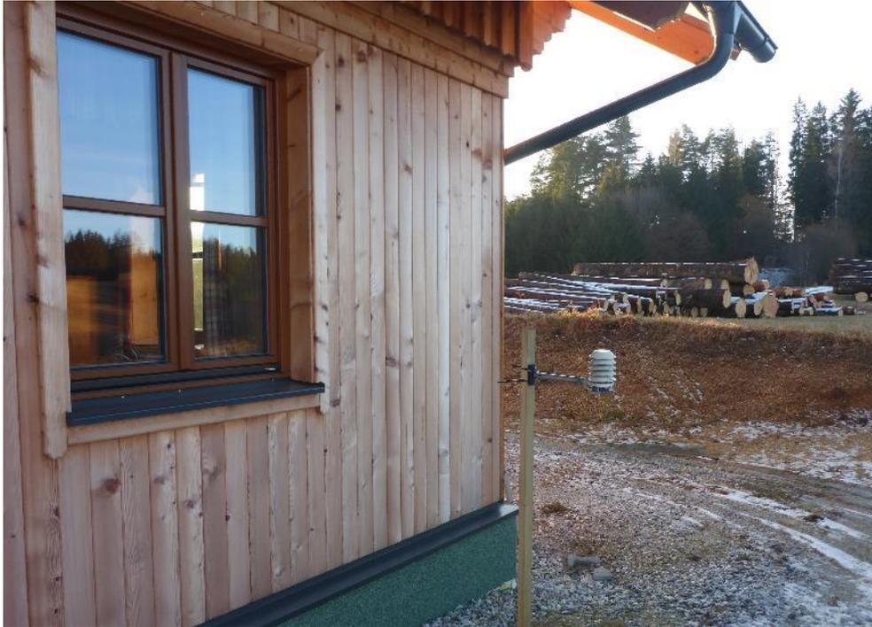
Abb. 32: Außensensor mit Strahlungs- und Regenschutz
