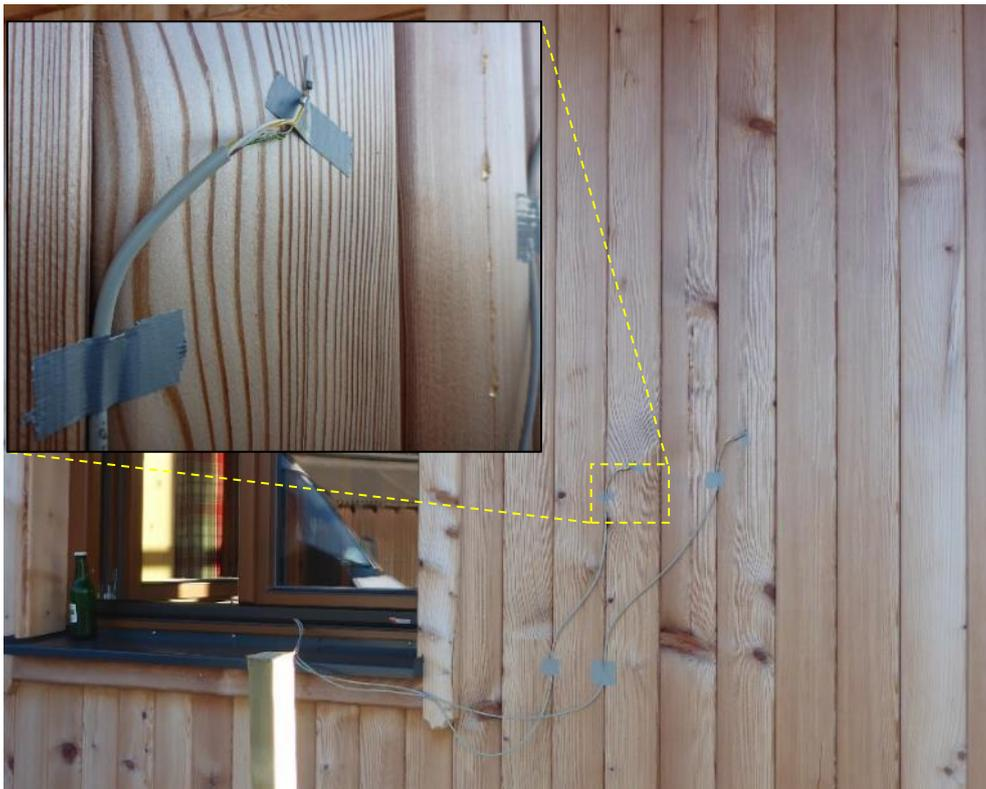
Abb. 11: Anbringung Temperatursensoren außen
