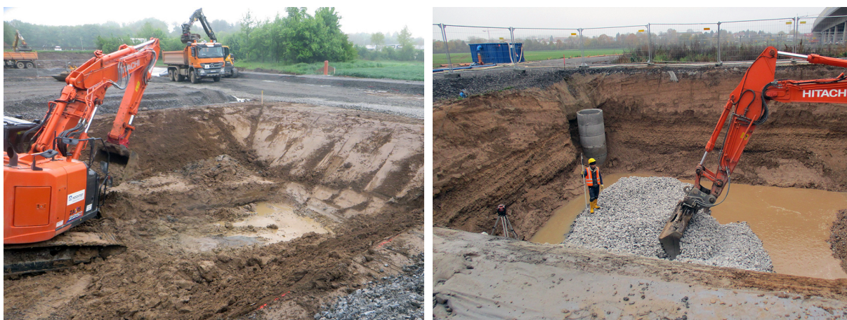
Abb. 3.9: Herstellen einer geböschten Baugrube bei A150 [22]
