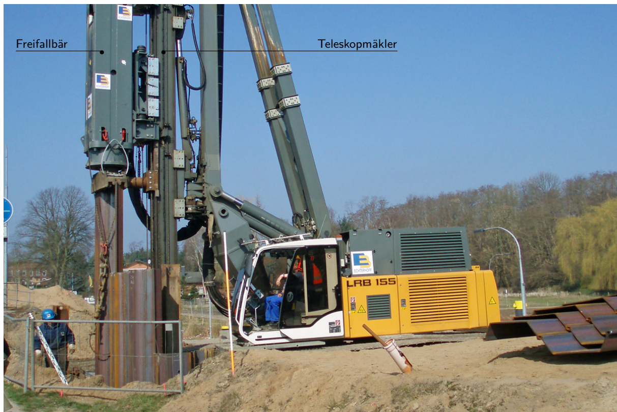
Abb. 2.5: Schlagrammen von Spundwandprofilen (modifiziert nach [31])
