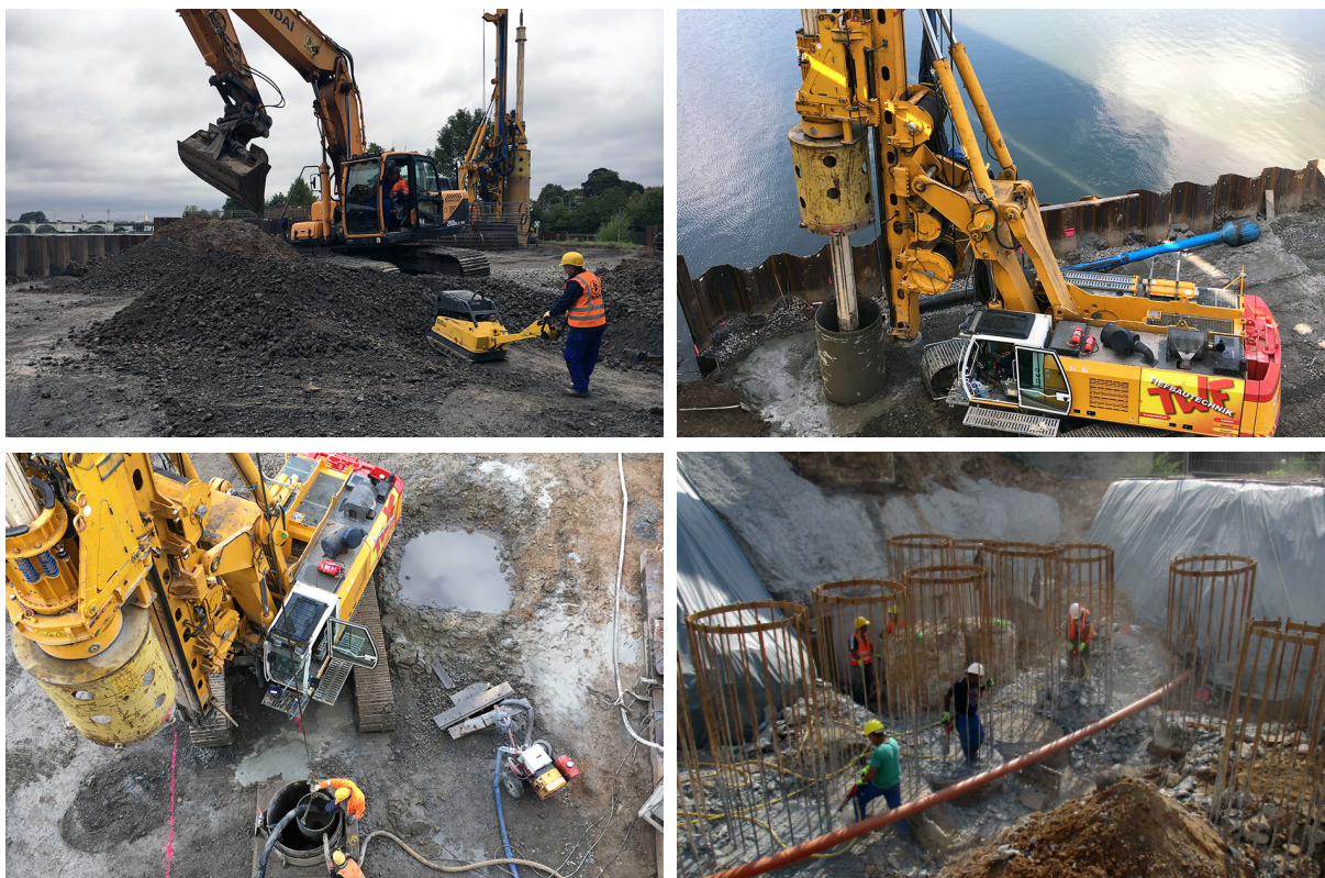
Abb. 3.13: Herstellen von Bohrpfählen bei A260/261 und A290 [22]
