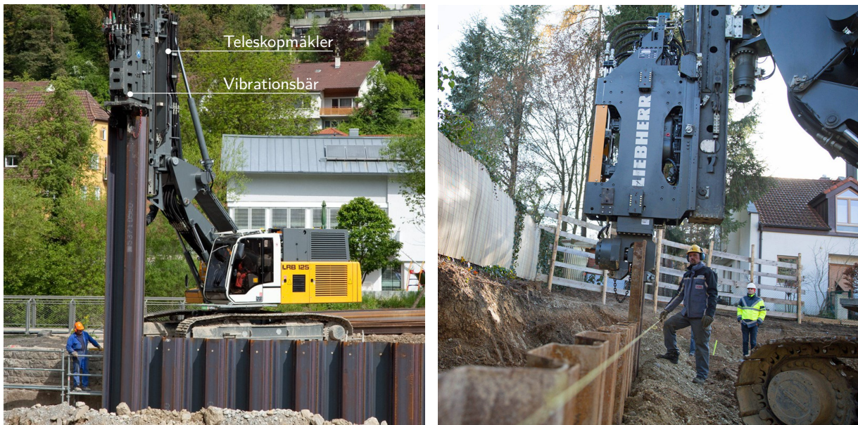
Abb. 2.6: Einrütteln von Spundwandprofilen (modifiziert nach [32])
