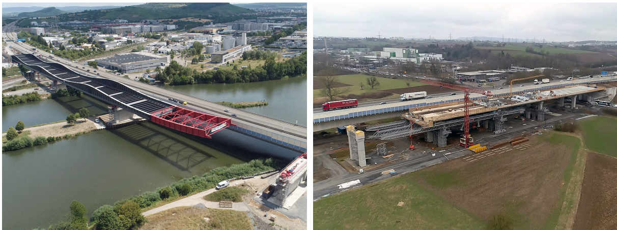
Abb. 3.3: Taktschiebeverfahren (li.), Vorschubrüstung (re.) [52]
