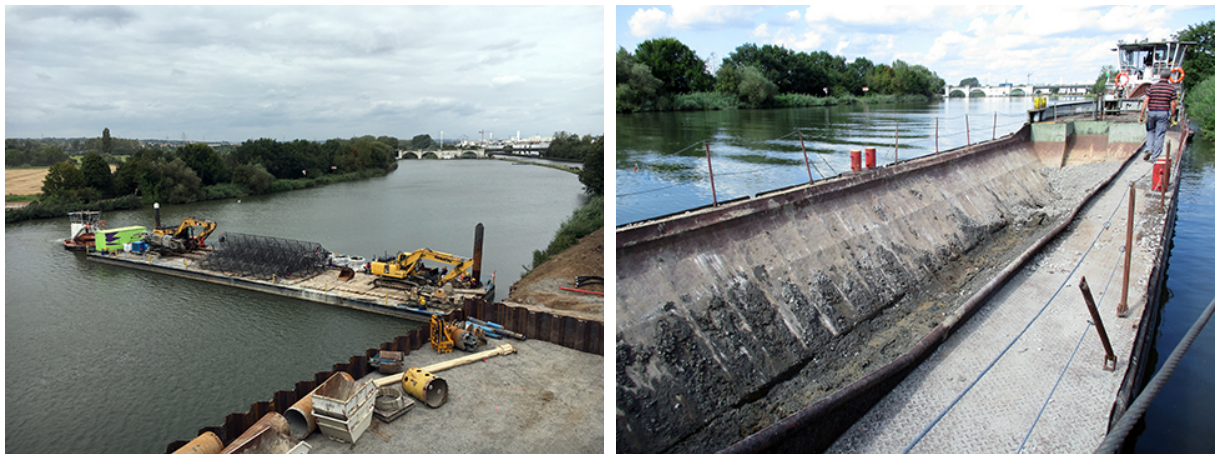
Abb. 5.3: Anlieferung mit Wasserfahrzeugen [22]
