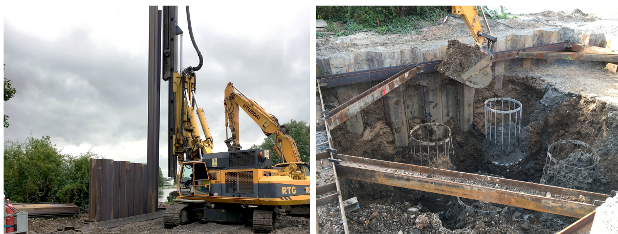
Abb. 3.11: Herstellen eines Spundwandverbaus bei A270/271 [22]
