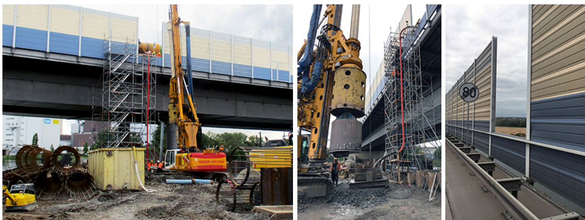
Abb. 5.4: Betonanlieferung über Druckleitung [22]
