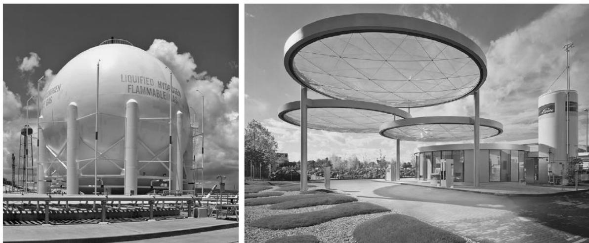
Abbildung 14: Sphärischer Behältertank von NASA in Florida, USA und horizontaler Zylindertank beim Linde-Wasserstoffzentrum in Unterschleißheim, Deutschland [14]
