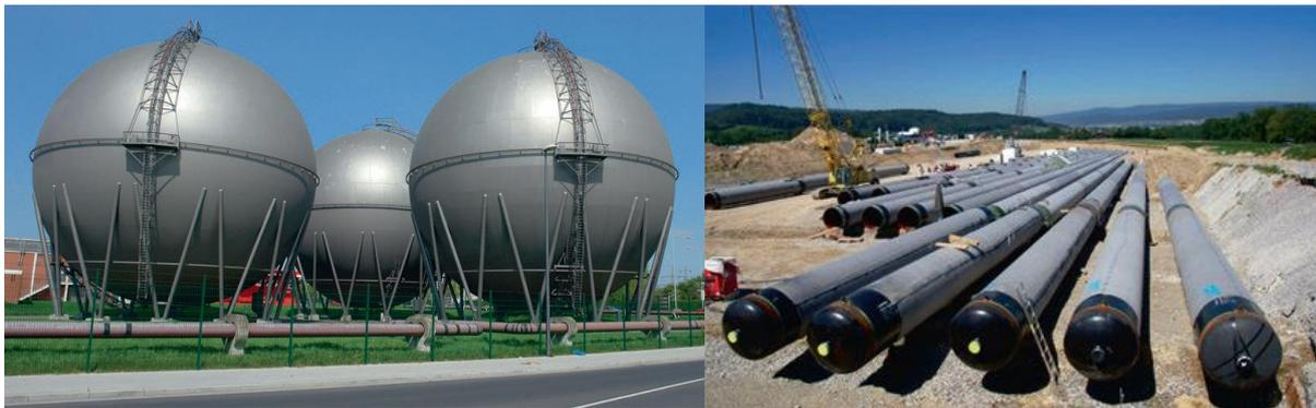
Abbildung 10: Beispiele für großtechnische Wasserstoffspeicherbehälter: Kugelgasbehälter in Aachen (links), Röhrenspeicher in Urdorf, Schweiz (rechts), [9]
