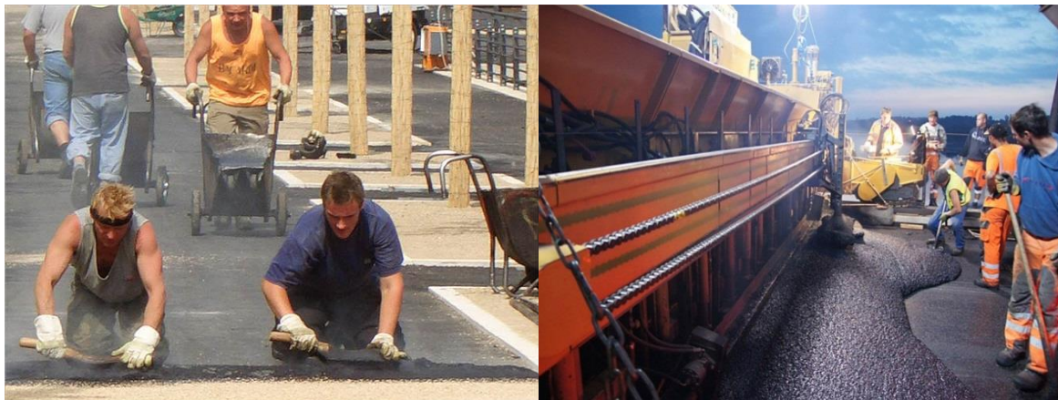
Abbildung 8: händischer (links) und maschineller (rechts) Einbau von Gussasphalt [17]
