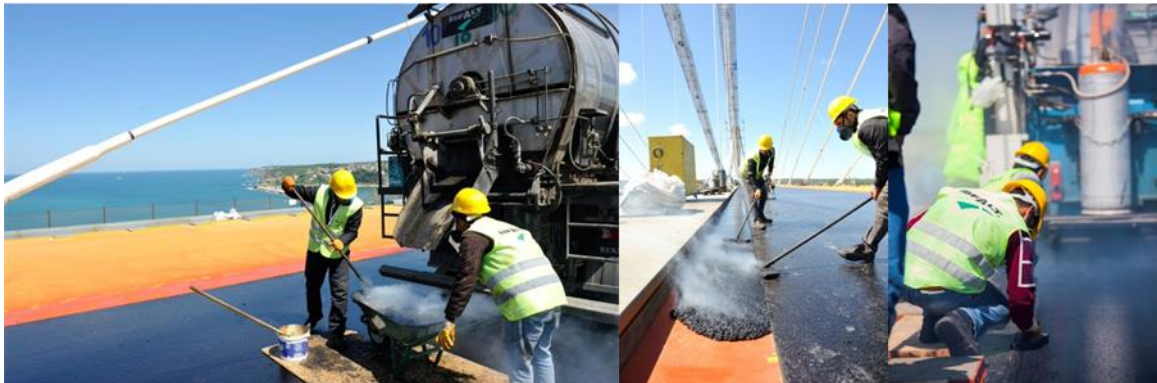
Abbildung 12: händischer Einbau von Gussasphalt [23]
