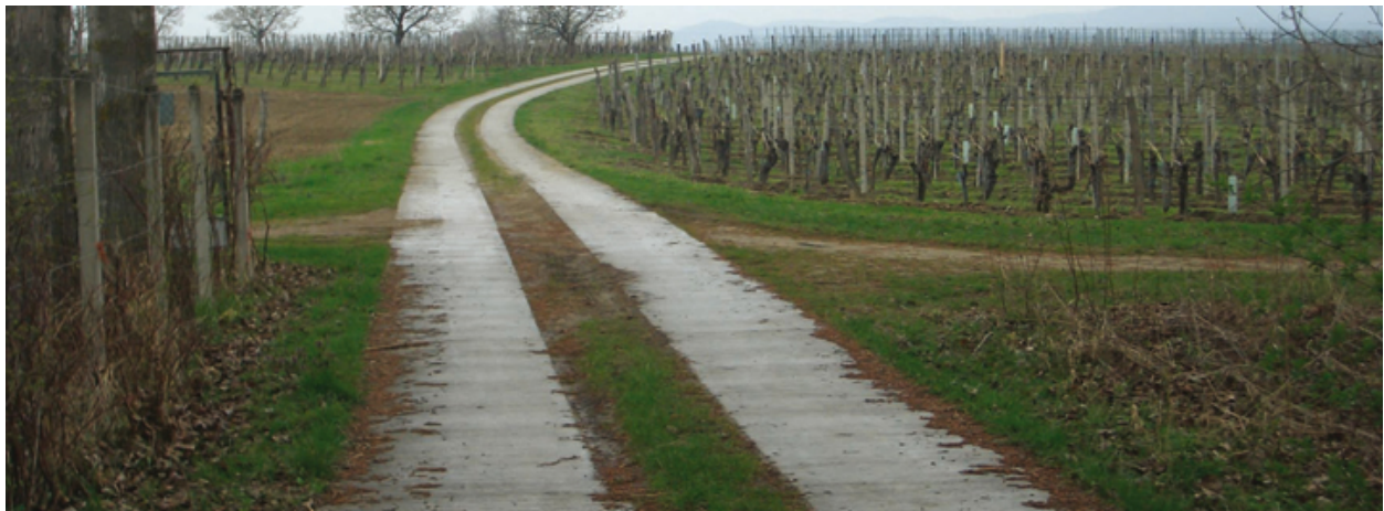
Abb. 9: Betonspurwege in ländlicher Bereich [4]
