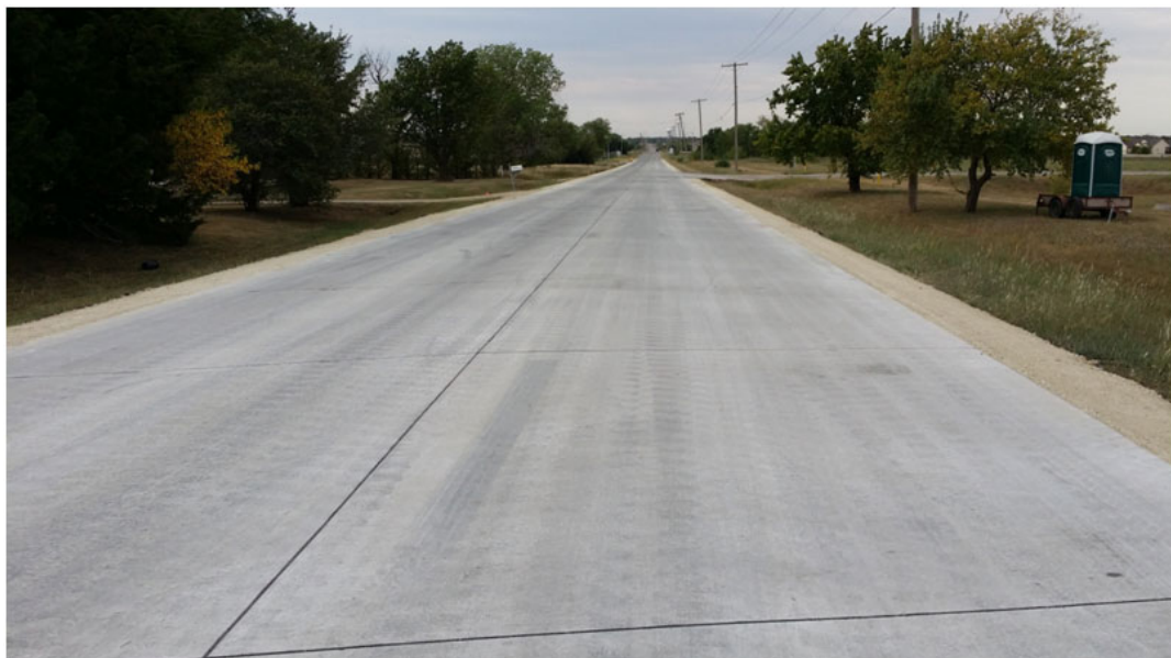
Abb. 28: Hauptstraße, eingebaut mit Walzbeton, in Bel Aire, Kansas [25]
