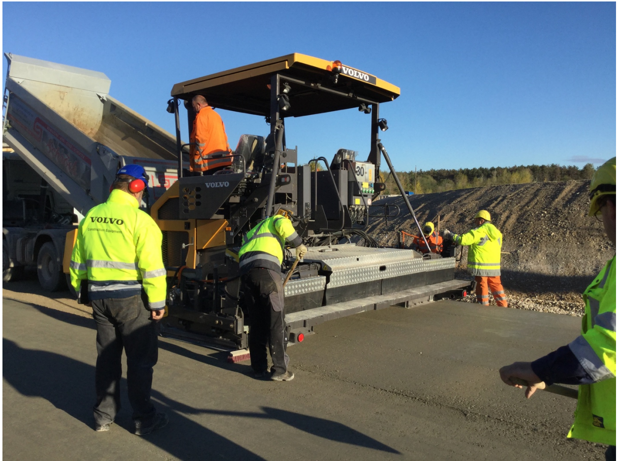
Abb. 31: Einbau von Walzbetonfahrbahn [29]
