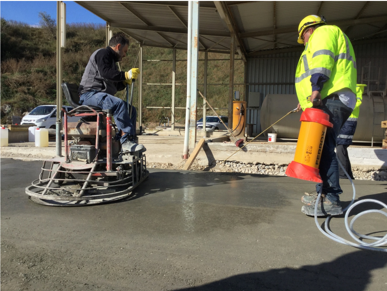
Abb. 34: Maßnahmen gegen Feuchtigkeitsverlust nach der Herstellung [29]
