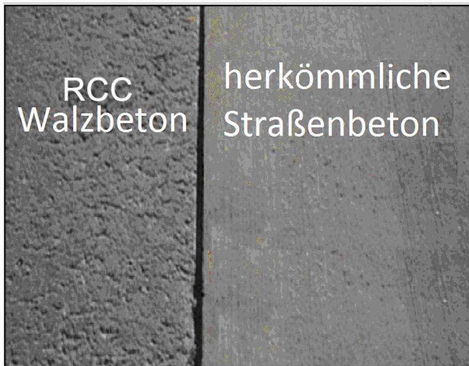
Abb. 35: Walzbetonoberfläche und herkömmlichen Betonstraße [1]
