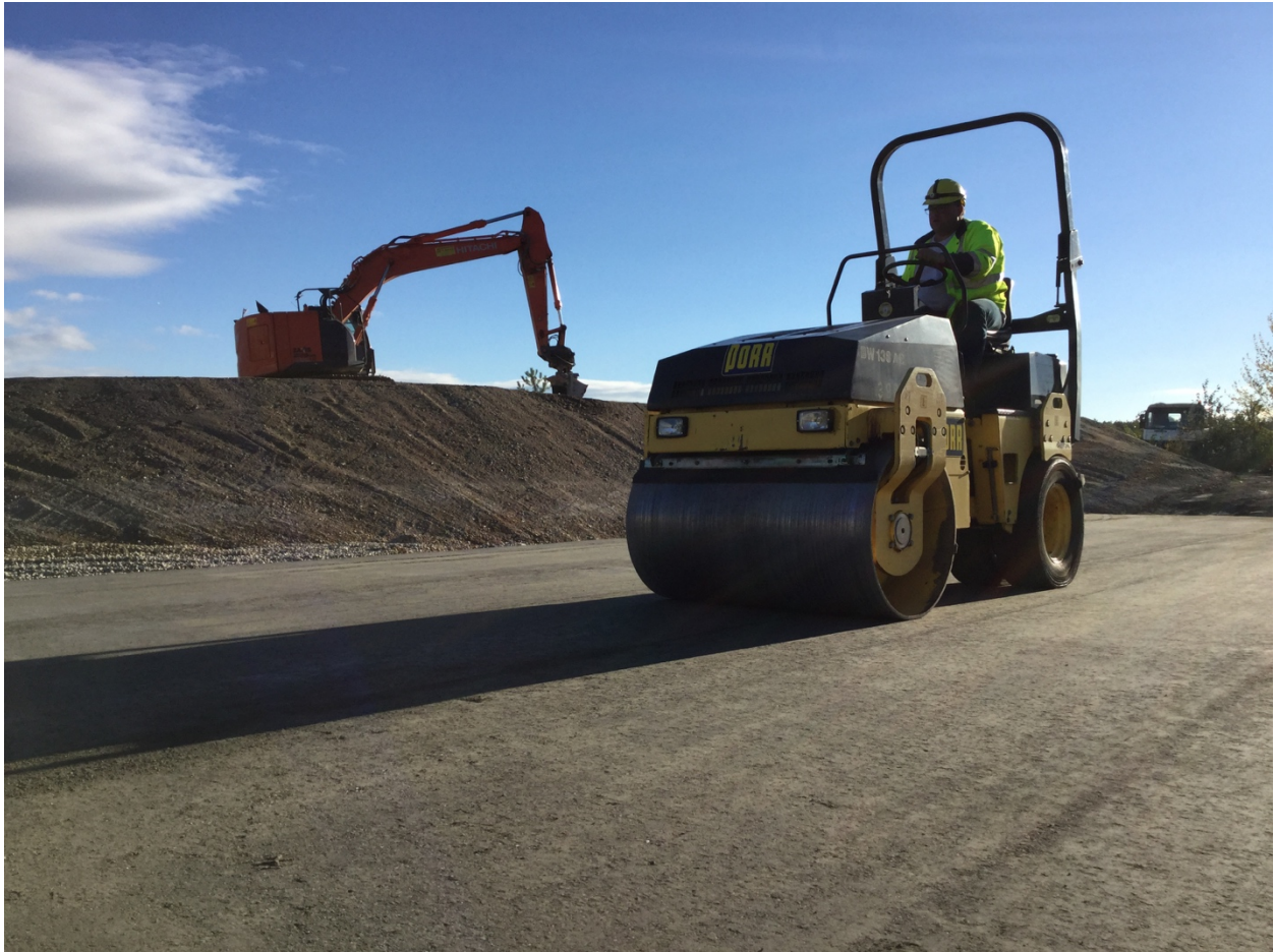
Abb. 33: Verdichtung von Walzbeton [29]
