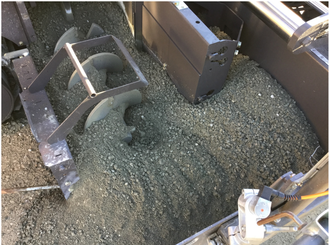
Abb. 25: Walzbetonmischung im Fertiger [29]
