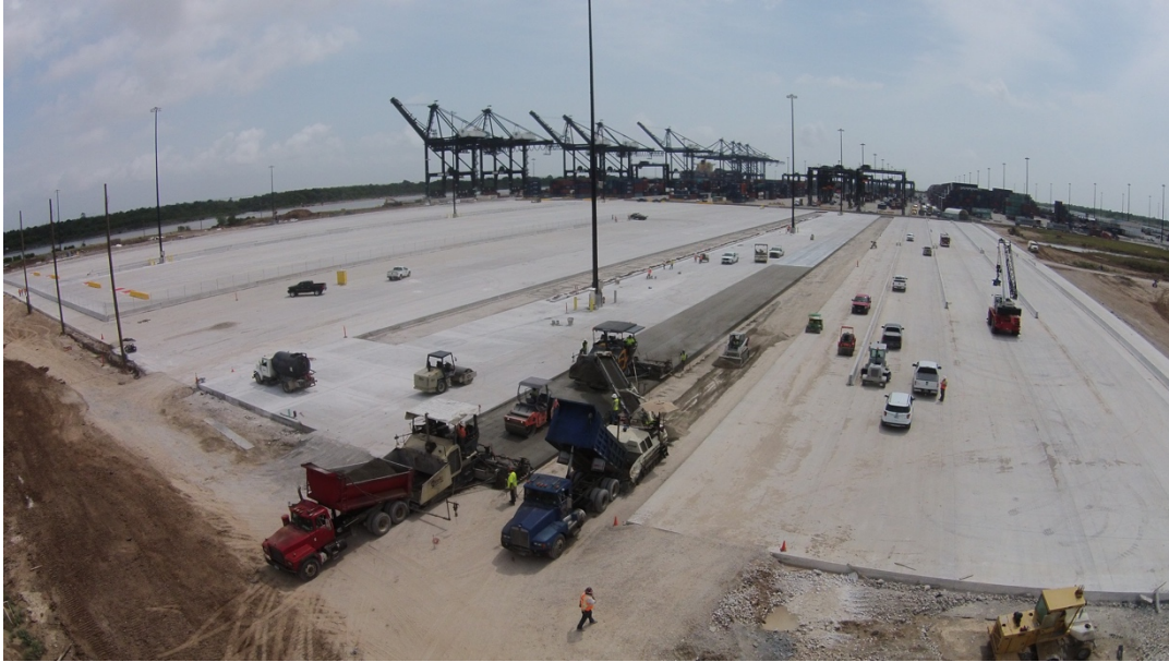
Abb. 27: Einbau von Hafen in Houston, USA [1]
